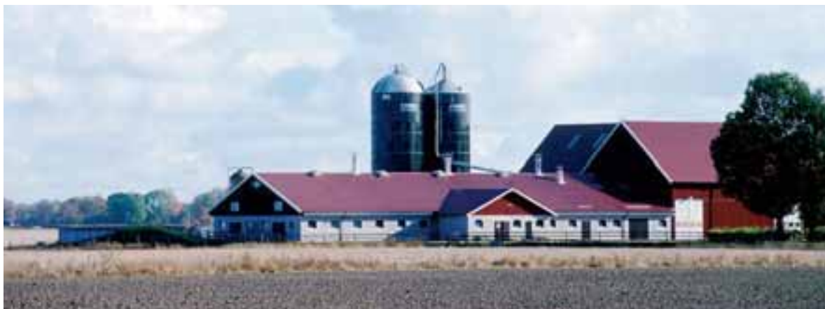
Fåhus i betong, fodersilos samt gödselbrunn är byggnadstyper som utmärker moderna mjölkgårdar och som blivit vanliga inslag i landskapet under det sena 1900-talet. Ingagården utanför Vara. Foto: Ola Erikson, RMVG.
