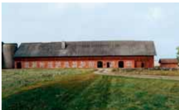
Ladugård med silo.
