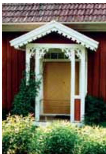
Guntorp Andersgårdens manbyggnad i Berghems sn i Mark har en bevarad pardörr med ett spröjsat överljusfönster. Detta har varit vanligt som entré på många håll i Västergötland. Under sent 1800-tal har en liten veranda byggts till. Foto: VGM.
