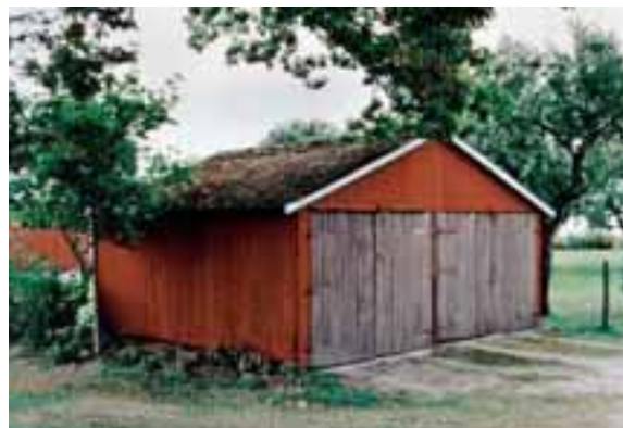
På gården Händenetorp i Händene vid Skara står detta garage. Det byggdes 1954 för en fotogendriven traktor (en Volvo T22) och en personbil. Foto: VGM.
