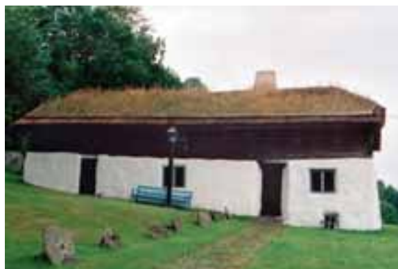
Framkammarsstugan på Borgatorp i Dala på Falbygden är byggd med bottenvåning av sten och senare påbyggd med en låg övervåning av timmer. Åldern är osäker, men stenhuset har ansetts kunna härstamma från perioden senmedeltid till 1600-tal. Foto: VGM.
