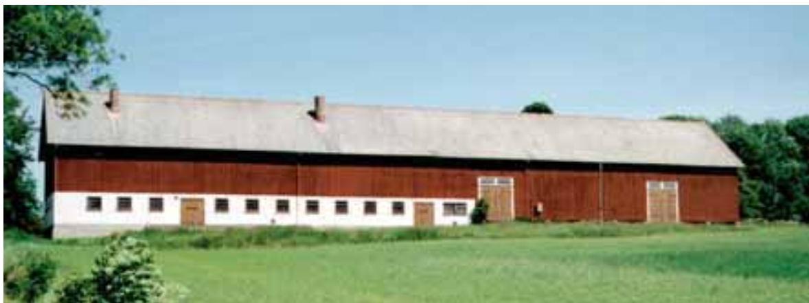
Höghusladugården från 1944 på Hålltorp i Varnhem vid Billingen har fähusdel i putsad cementsten och taktäckning med asbestcementskivor. Foto: VGM.
