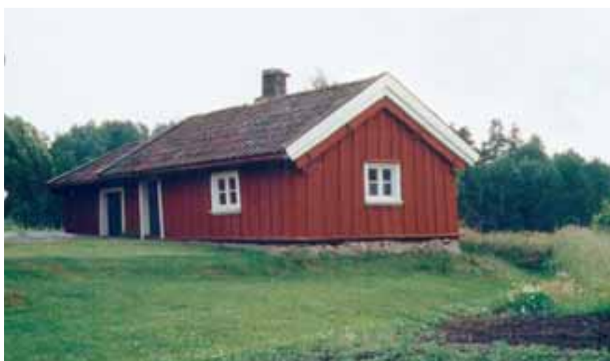
Ryggåsstuga från Gästene härad med enkelstugans planlösning. Vid borte gaveln skymtar ett tillbyggt bodutrymme. Skogsbo, Norra Säms sn, Herrljunga. Foto: VGM.
