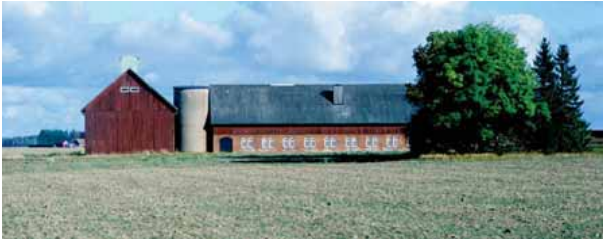
Fägården på Skogsbo i Long på Varaslätten har ladugård från sent 1800-tal med fähusdel i tegel. En tidig silo i cement syns till vänster. På taket ligger skivor av asbestcement, oftast kallad eternit. Foto: Ola Erikson, RMVG.
