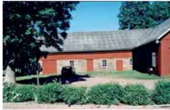
Ladugården på Horla Skräddaregården i Vårgårda har fähusdel från sent 1800-tal, murad i välhuggen gråsten. Foto: VGM.
