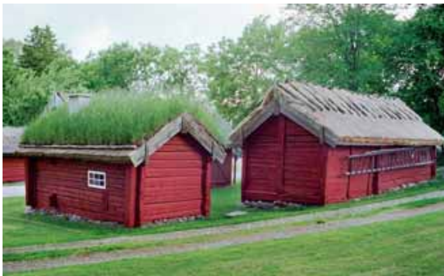
På Odensåkers Klockarebol, Odensåkers sn, Mariestad, finns ekonomibyggnader från 1700-talet som ger en samlad bild av de viktigaste äldre byggnadsteknikerna i Västergötland: skiftesverk (höger) och knuttimring (vänster). Dessutom syns på bilden taktäckning med såväl strå som torv. Foto: VGM.
