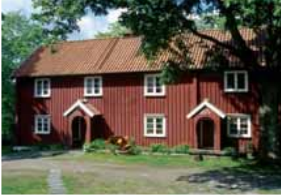
Långloftsstuga i Kalvshult, Sätilla sn i Mark, uppförd 1858 i två fulla våningar. Notera de för trakten karaktäristiska nyckelhålsförstuvistarna. Foto: RMVG.
