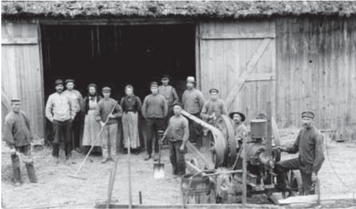
Mekaniseringen bidrog starkt till att kapa säsongsbundna arbetstoppar. Tröskning med tröskverk drivet av råoljemotor gick nu snabbt jämfört med den gamla manuella slagtröskningen! Trösklag hos J.W. Karlsson i Äspång, Fredsbergs sn, i kanten av Vadsboslätten. Foto: Erik Rud 1911, VGM.
