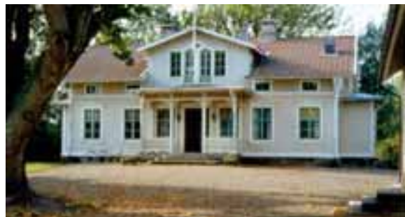
Manbyggnaden på Sjöhaga i Bergs sn i Skövde är byggd 1880. Hustypen har rum på dubbel bredd och förekommer rikligt, med eller utan frontespis. Sjöhaga uppvisar många detaljer som kan härledas från C.E. Löfvenskiölds planschverk; t.ex. stora taksprång, spetsbågiga fönster, figursågade överstycken mm. Foto: VGM.
