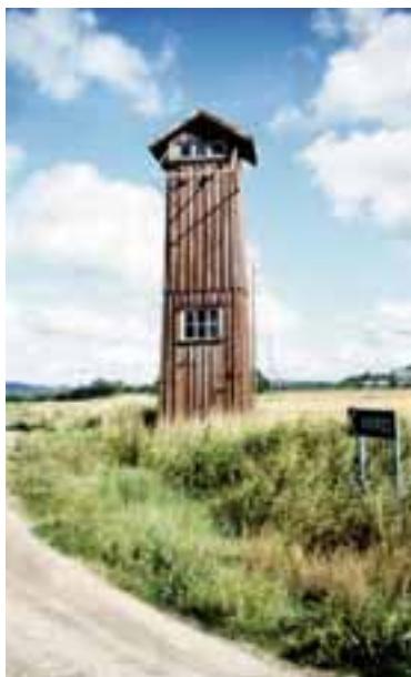
Transformator torn i Istorp, Mark. Dessa karaktäristiska byggnader utgör en konkret påminnelse om en av 1900-talets största förändringar. Utbyggnaden av elnätet förändrade förutsättningarna för såväl boende som jordbruksdrift. Foto: RMVG.
