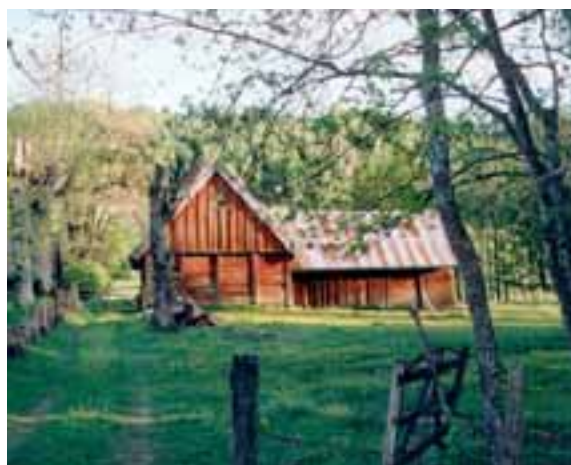
Skiftesverk har använts under lång tid i centrala Västergötland, inte minst på Falbygden. Stora Vådegården i Dala sn är en välbevarad gårdsbildning från 1800-talet med ladugård delvis byggd i skiftesverk. Foto: VGM.
