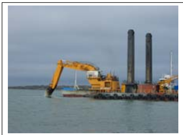
Figur 1. Enskopeverk för muddring av sprängstenen (skopvolym max 13 m 3 )
