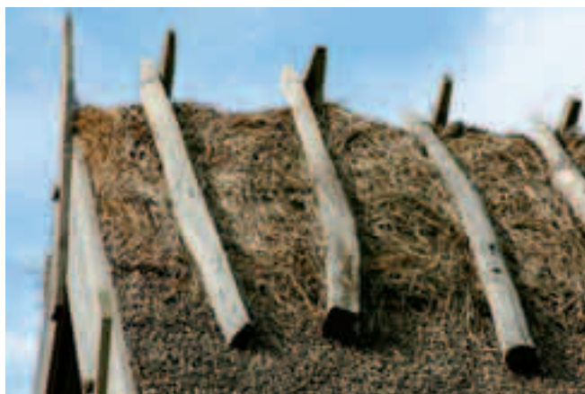
Mörning vid östra gaveln.
