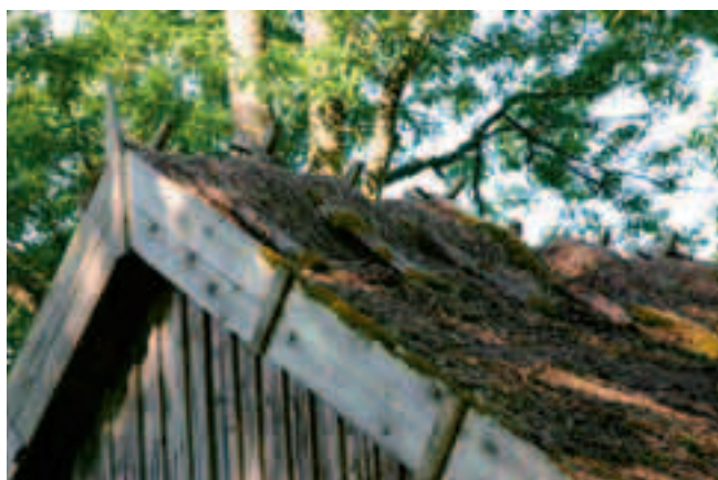
Pållträn, mörning och vindskivor åt nordost.
