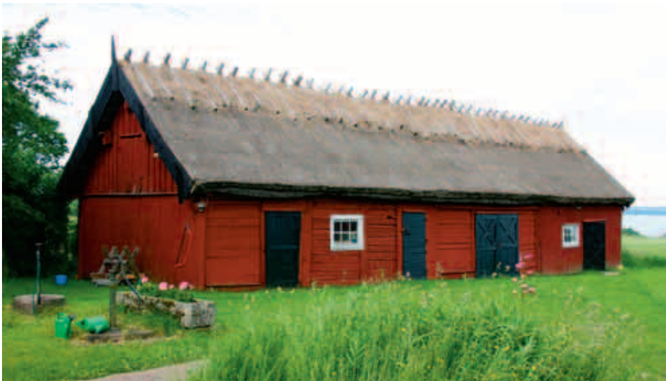
Stallets fasad mot öster och norr.
