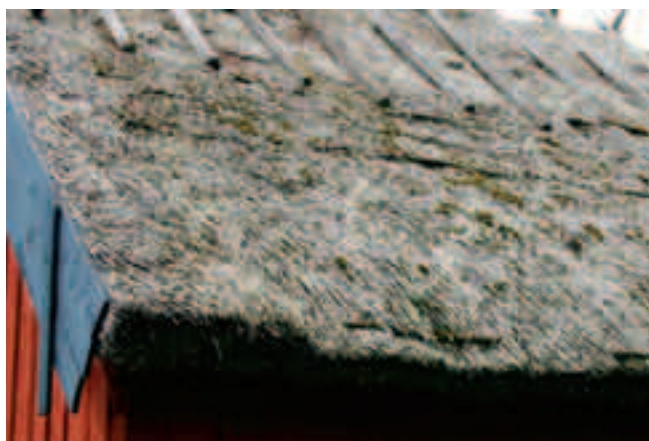
Öfs och vindskiva vid det sydöstra hörnet.
