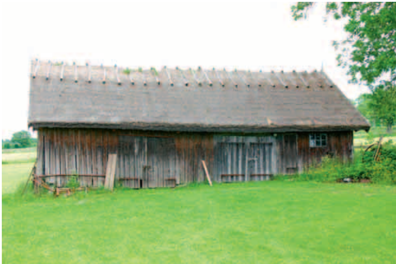
Vagnboden mot söder.
