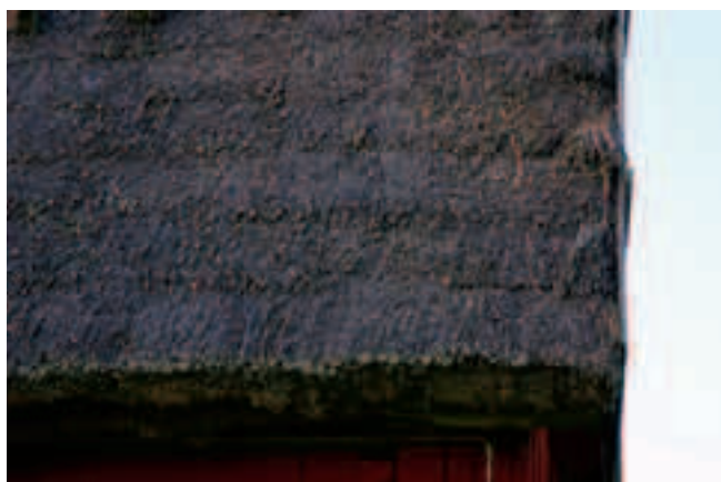
Takfallets utseende i detalj på sydöstra hörnet.
