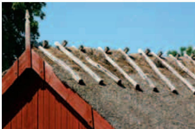
Södra gavelspetsen med mörning och östra takfallet.
