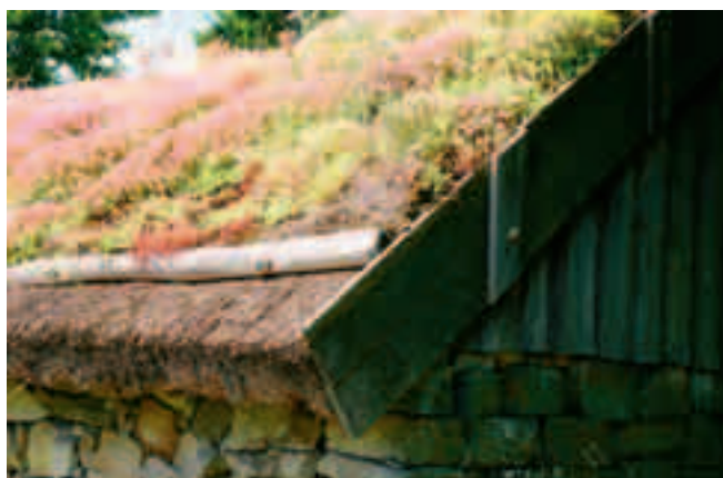
Ladugården södra takfall.
