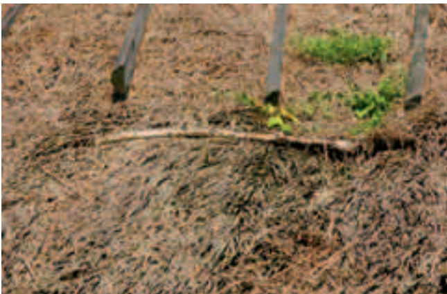
I det femtioåriga taket börjar täckespröten att synas.
