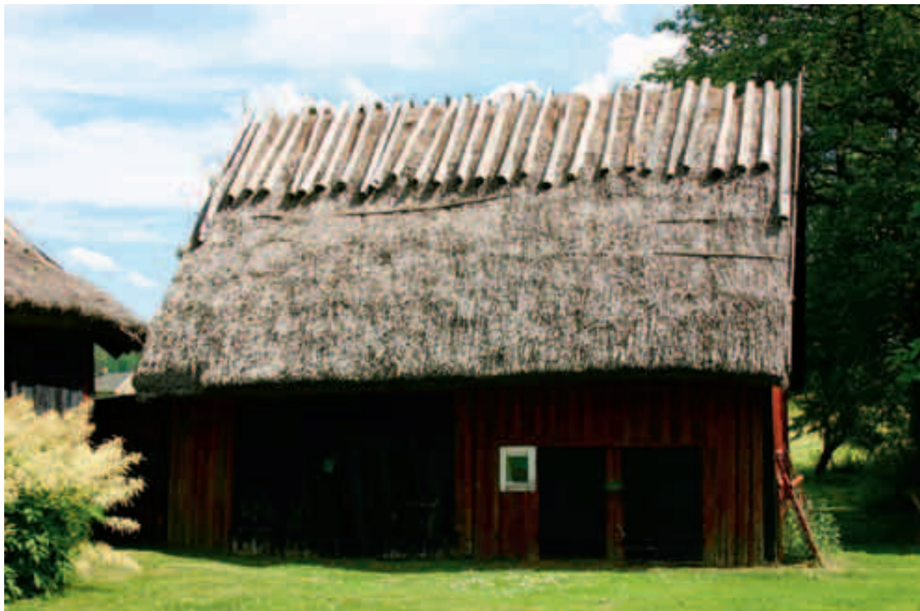
Bodlängans västra takfall.
