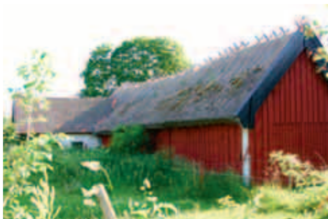
Det västra takfallet med rännal till svinhuset.
