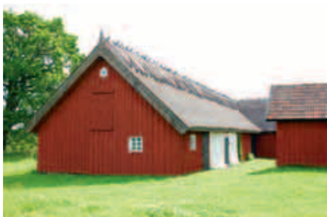
Ladugårdens västra gavel med gårdstunet och vedbod.
