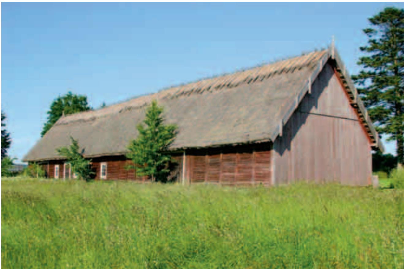
Ladugårdens västra fasad.
