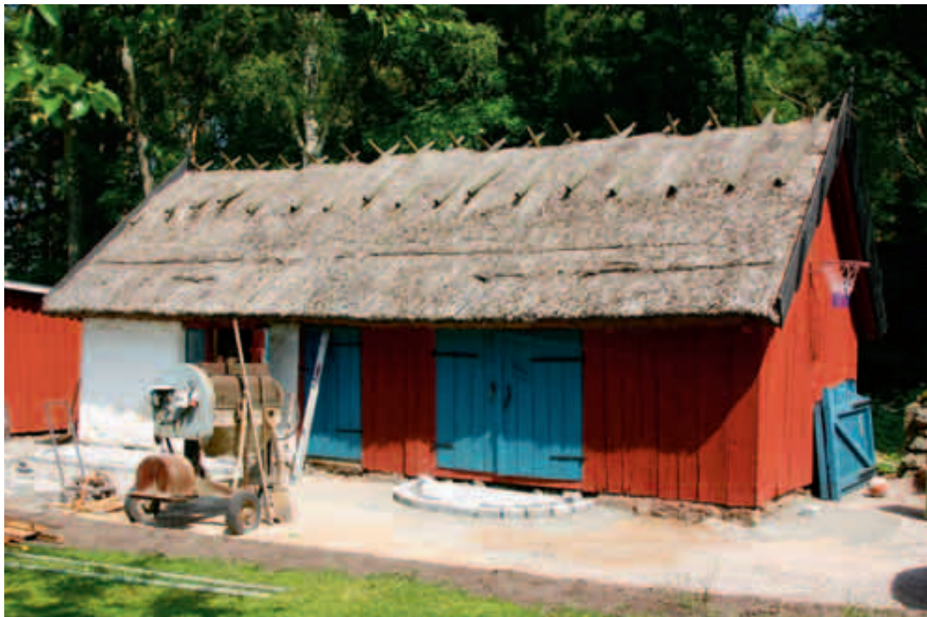
Fasad åt väster.
