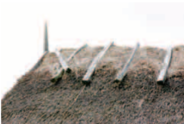
Mörning och återanvända pallträn vid södra gavelspetsen.
