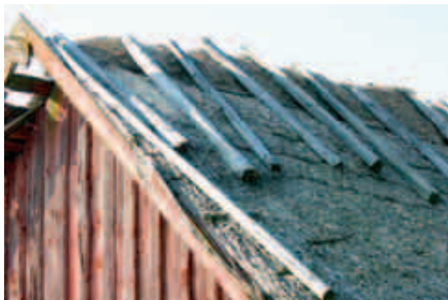
Vindskivor, pallträn och mörning på södergaveln.
