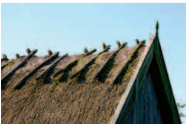
Mörning och pållträn längs norra takfallet.
