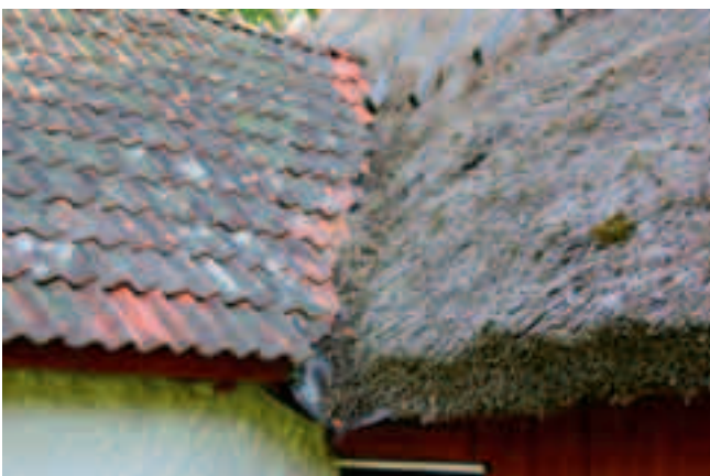
Rännan på västra takfallet.
