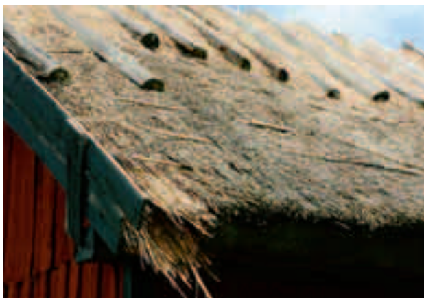
Taket sydvästra hörn med mörning, päll och blottade täckespröt.
