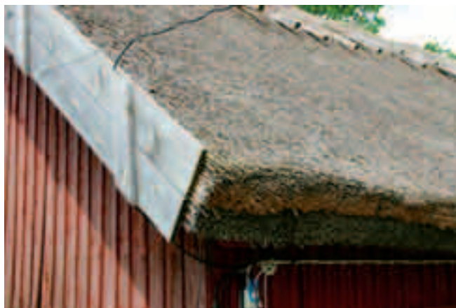
Det östra takfallet och vindskivan mot söder.
