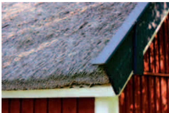
Del av det södra takfallet .
