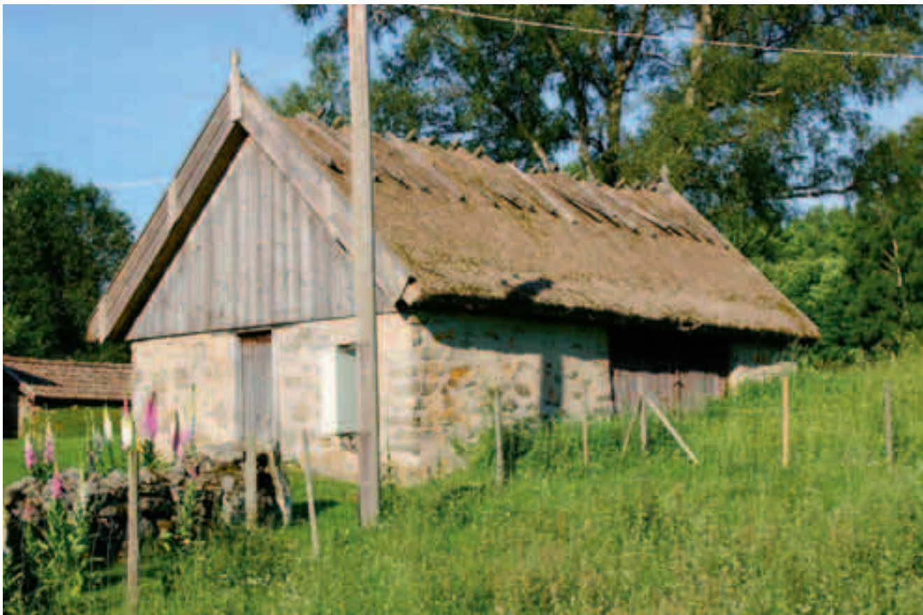
Den östra gaveln och det norra takfallet.
