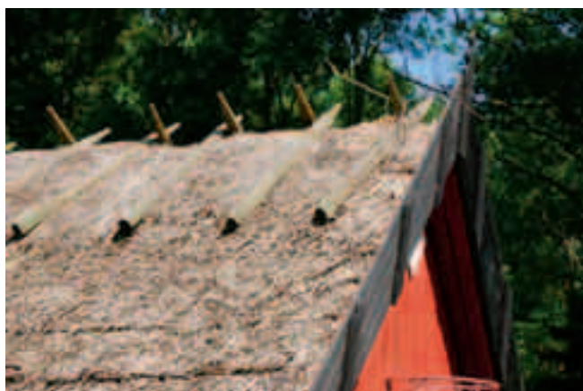
Mörning och takfall på västra takfallet.
