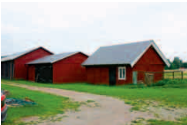
Ladugården är till stor del riven. Fähusdelen till höger är dock sparad med tre fack skiftesverk. Utrymmet efter den rivna ladugårdsdelen är ersatt med en mindre maskinhall. Maskinhallen visas i mitten på bilden.
