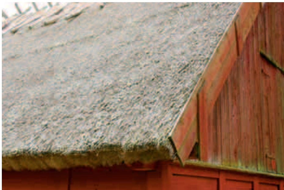
Det östra takfallet och norra gaveln.
