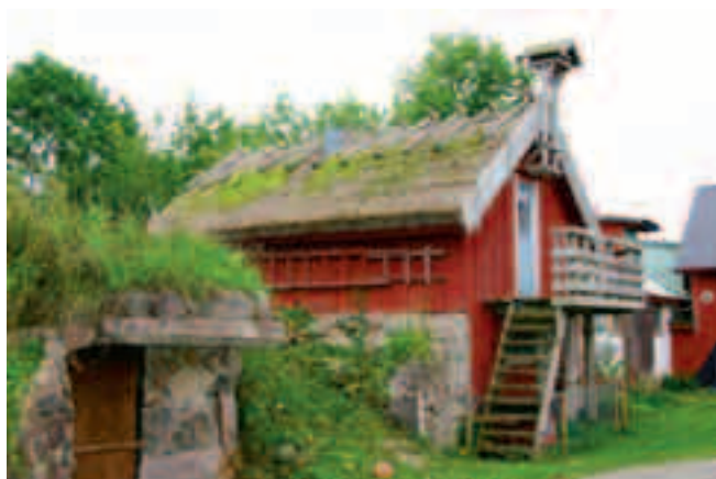
Byggnaden sedd från norr.
