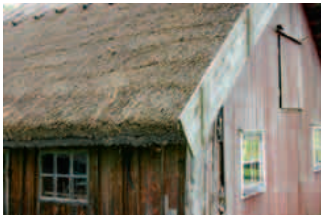
Takfall, öfs och vindskivor på det sydöstra hörnet..
