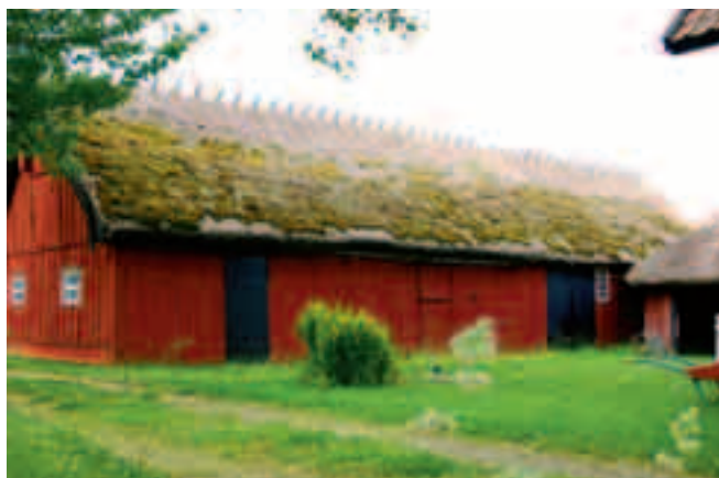
Det norra takfallet.
