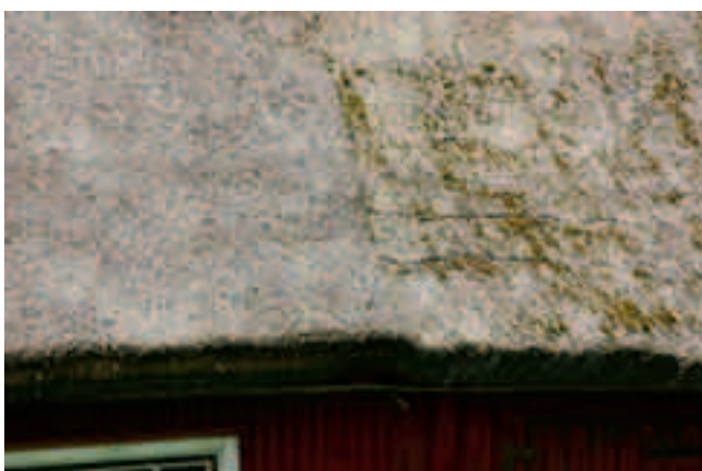
Skarven på östra takfallet, mellan ny täckning över fähuset och den äldre över ladorna.
