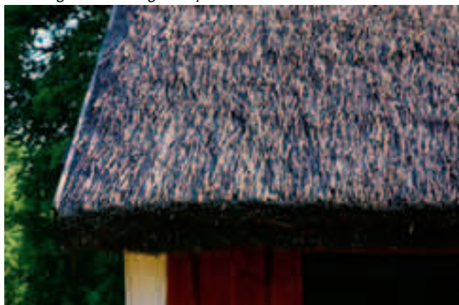
Takyta på södra takfallet.
