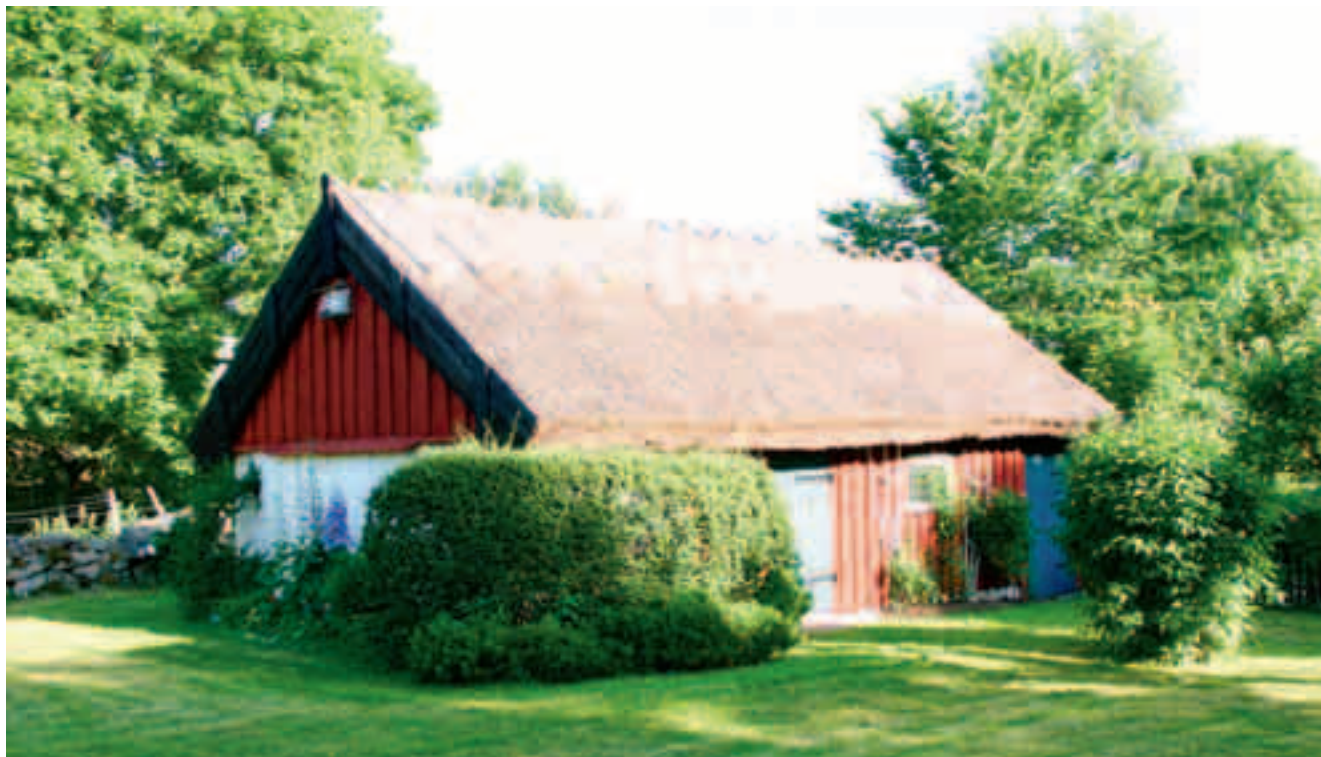
Ladugårdens södra och östra fasader.
