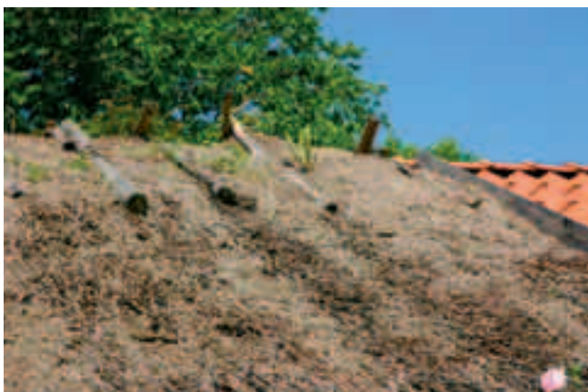
Det södra takfallet med pällträn och mörning.
