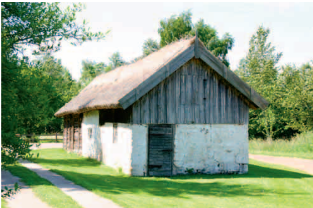
Ladugårdens norra gavel och östra fasad.
