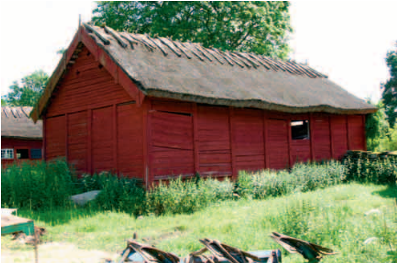
Vagnbodens norra gavel och västra fasad.
