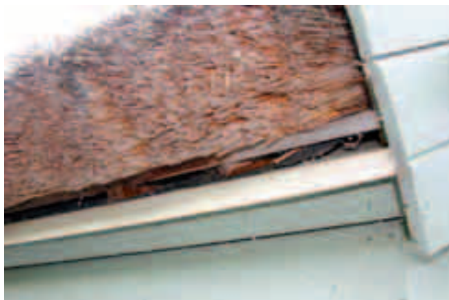
Närbild av öfs med undertak och vindskiva.
