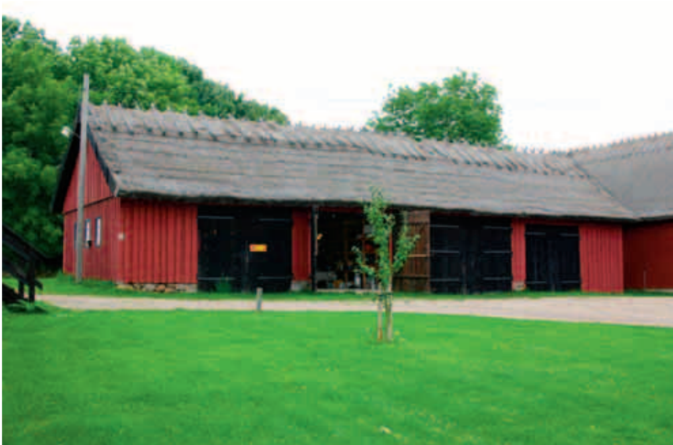
Det södra takfallet. Till höger skymtar den senare tillkomna maskinhallen. Denna ingår inte i inventeringen.
