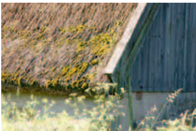
Öfsen längs norra takfallet. En "ränna" är belägen ca 70 cm från öfs.
