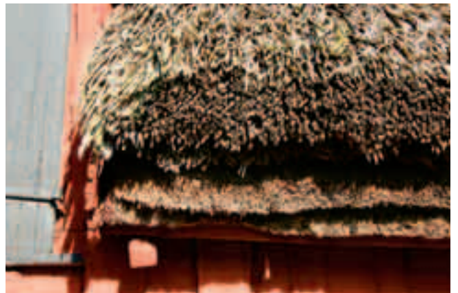
Underliggande tunnpipigt takmaterial och grovpipig Hornborgavass överst.
