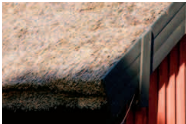
Takfallet mot öster.
