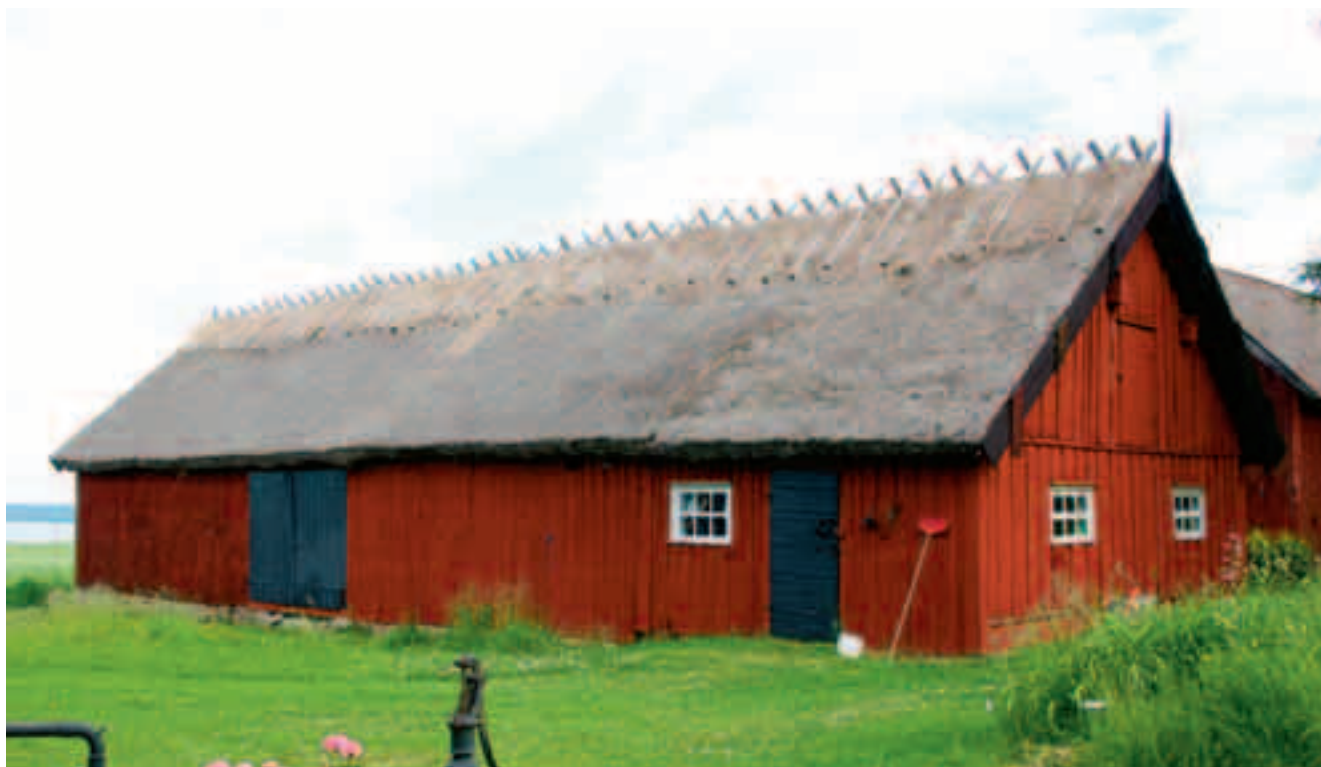
Ladugårdens södra och östra fasader. Det sparade äldre takavsnittet syns till höger på takfallet.
