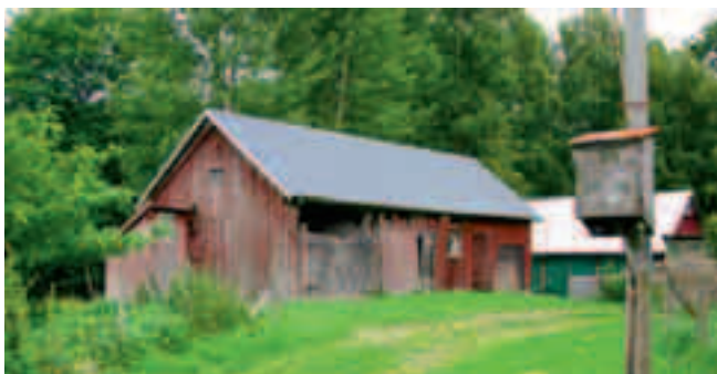
Stallets västra gavel och södra fasad.
