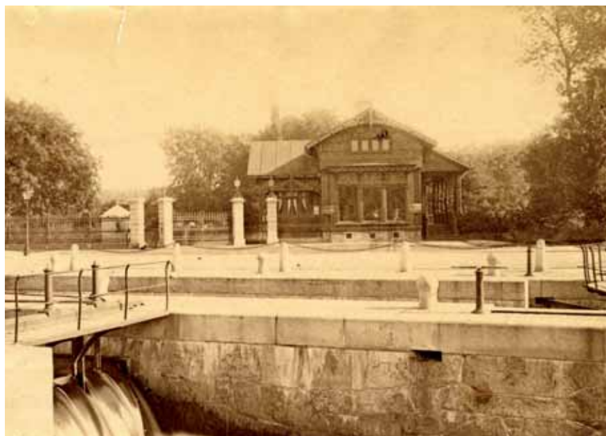
Norra entrén flyttades och omgestaltades 1876 mot den nyanlagda Slussgatan. Observera den rikt dekorerade Fröhandeln med verandan mot Vallgraven samt grindpartiets placering och utformning. GSM.
