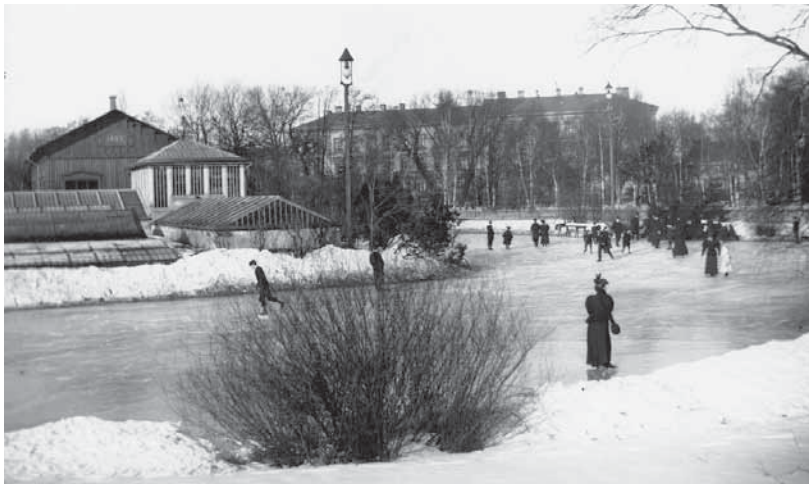
Dammen arrenderades vintertid av Göteborgs Skridskoklubb. Foto taget mellan år 1899 då elbelysning infördes i parken och 1905 då dammen lades igen. TF.
