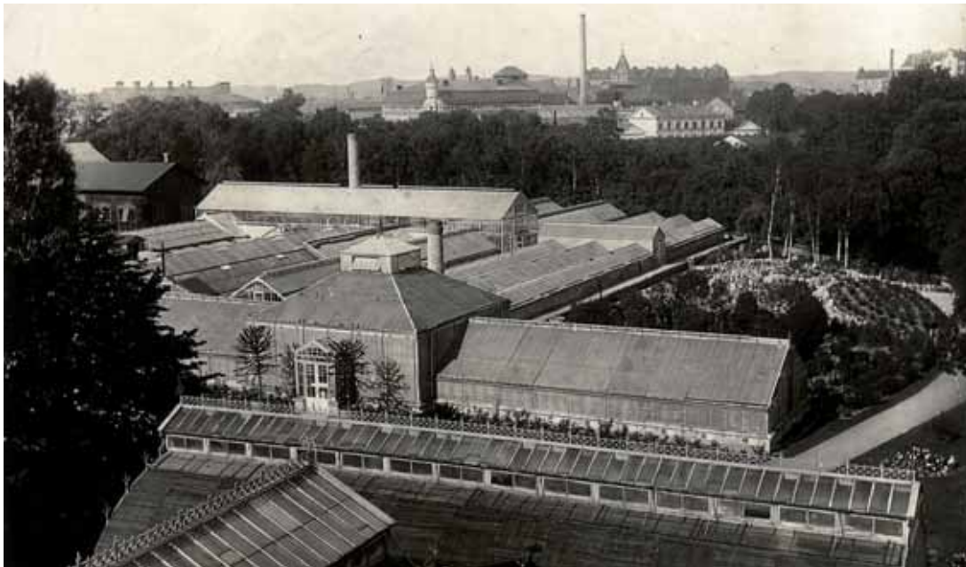
Utsikt från Palmhusets tak över det fullt utbyggda växthusområdet, där dammen tidigare låg. I bakgrunden till vänster skimtar Lagerhuset. I förgrunden Orkidéhuset (nuvarande Växthuset). TF
