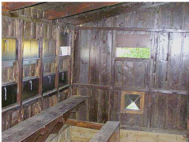
Utsiktsöppningar på olika nivåer med luckor som regleras med en kedja. En bänkskiva under öppningarna fungerar som armstöd. Observera den låga öppningen för fotografering i marknivå.
