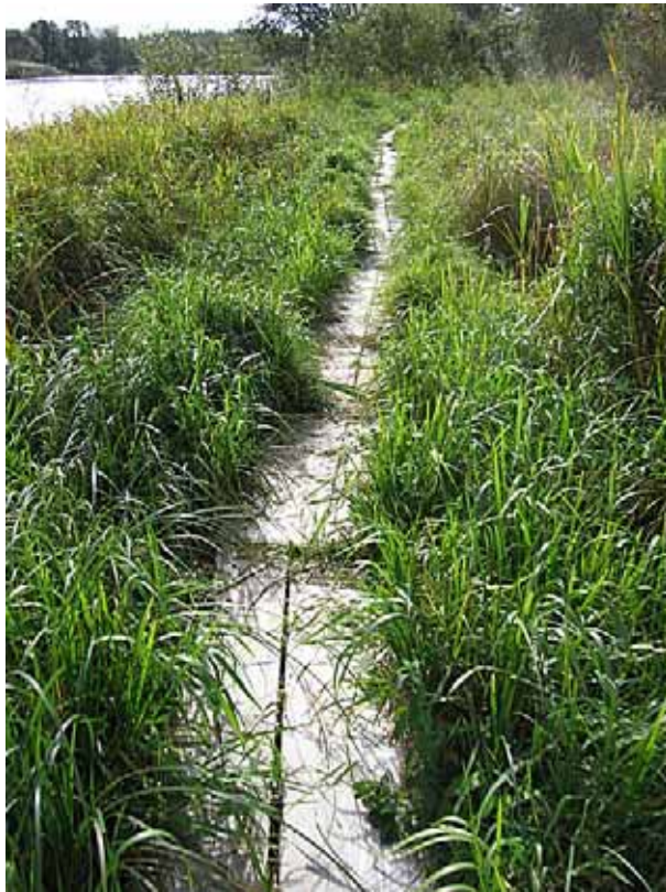
Vegetationen har växt över spången, stort behov av skötsel.
