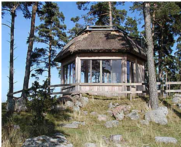
Torn och vaderskydd i lite mjukare former och med luftiga glaspartier. Vasstaket knyter an till närliggande vassområden.
