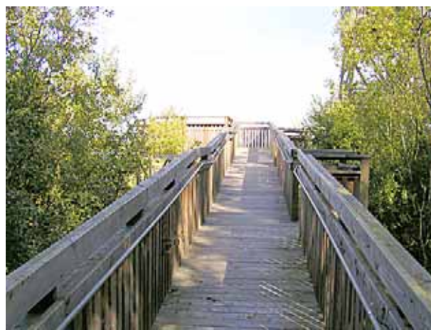
Ett föredöme till ramp, bred med stabila räcken och ledstång på båda sidor. Vilplan har placerats med jämna mellanrum.
