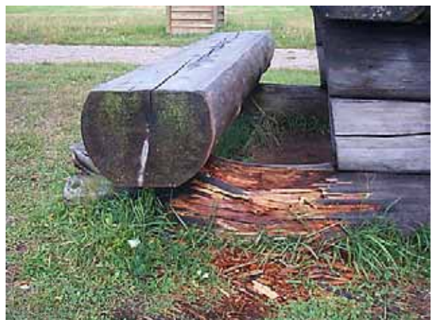
En träkonstruktion som vilar direkt på marken kan röta redan efter några år.
