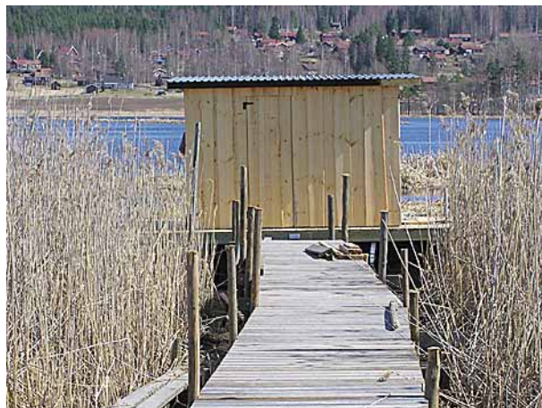
En bred spång leder genom vassen fram till gömslet som är under byggnad. Återstår bara att komplettera med räcken och avskärmning.
