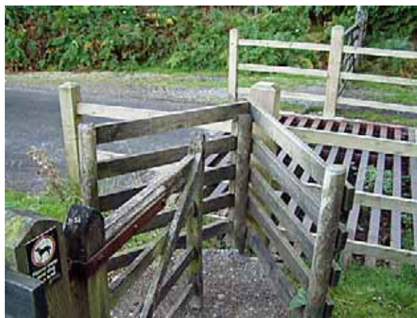
Färist kombinerad med V-formad genomgång med öppningsbar grind.
