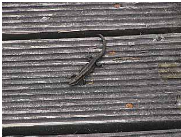
Vandringsled byggd av spårhyvlade brädor. Ger en mindre halkig spång. Torkar snabbare upp efter regn.
