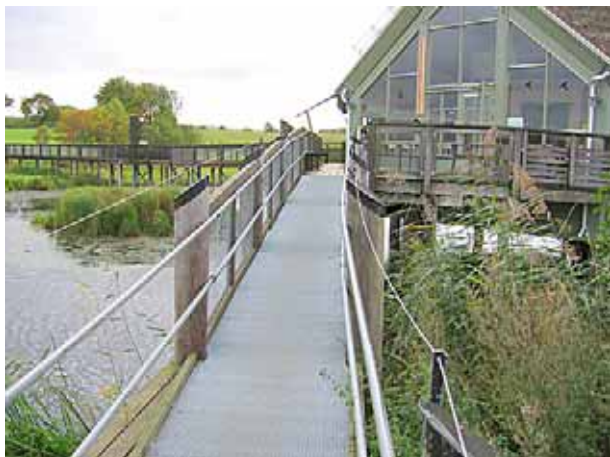
En gallerdurk av sträckmetall har lagts i rampen för att minska halkrisken.
