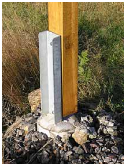
Grundläggning av skyltställ. Stabilt med betong och stålprofil, men utformningen kunde kanske vara bättre?
