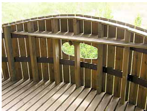
Titthål i räcket är ett annat alternativ för barn att kunna se ut. Av säkerhetsskäl får det inte vara så stora öppningar.
