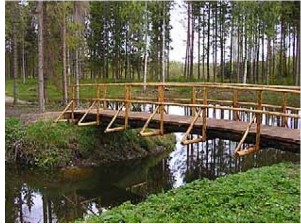
Bro utförd av rundtimmer. Trevligt utförd och med räcken.
