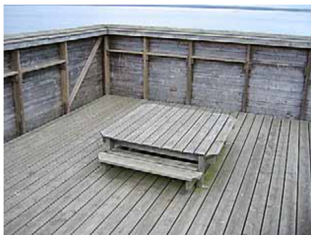
En upphöjning inom plattformen ger barn möjlighet att se över räcket utan risk för klättring.
