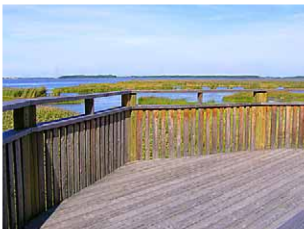
Högt och stabilt räcke med vertikala brädor för att förhindra klättring. Öppningen i räcket överkant ger barn och sittande möjlighet att se ut.
