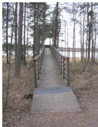
Ett skrapgaller vid ingången minskar nedsmutsningen i tornet.
