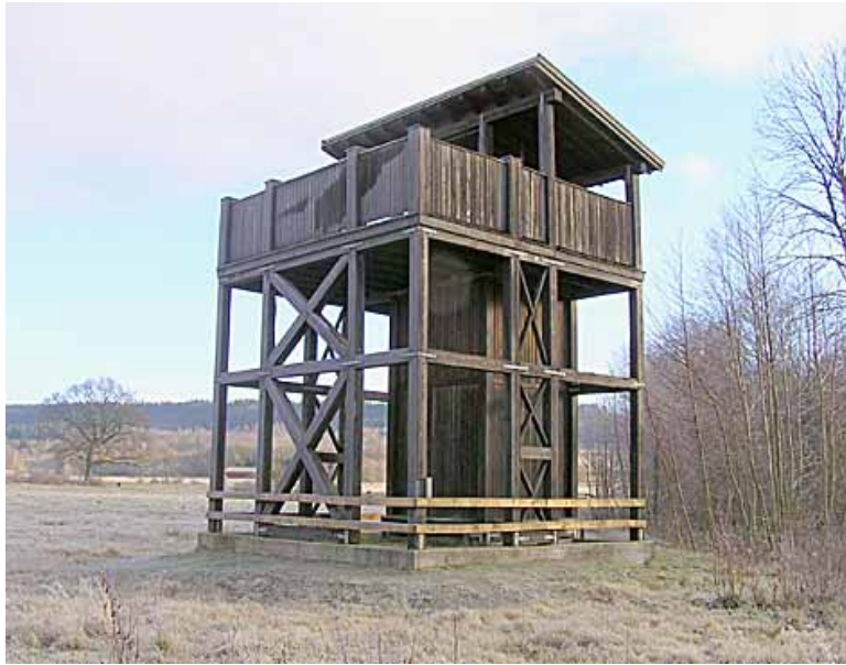
Ett tak över endast del av tornet ger regnskydd vid behov men behåller samtidigt fri sikt uppåt.
