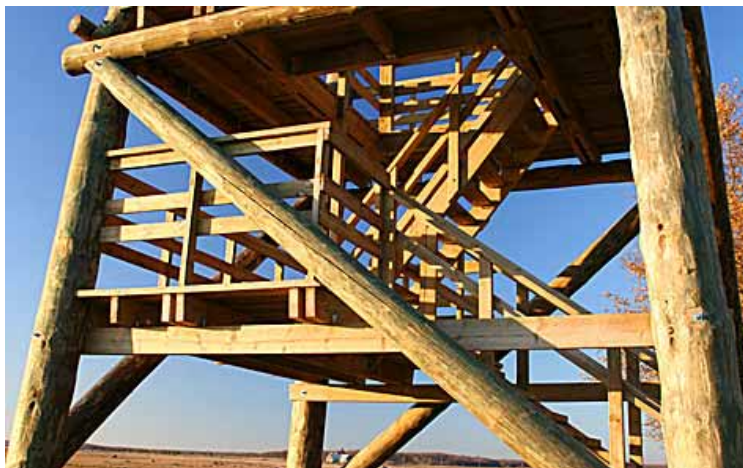
En traditionell trästomme med kraftiga stolpar och diagonaler ger ett stabilt torn.
