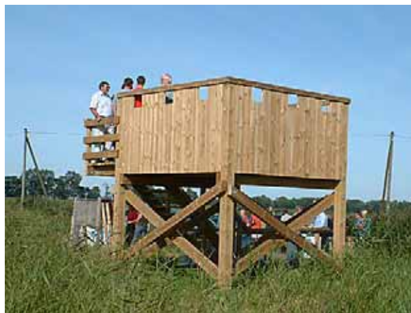
Plattform med öppningar i räcket som gör det lättare för barn att se, Delver Turm Tyskland.
