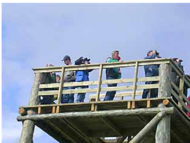
Klättringsbara räcken med stora öppningar utgör en stor säkerhetsrisk vid höga torn.
