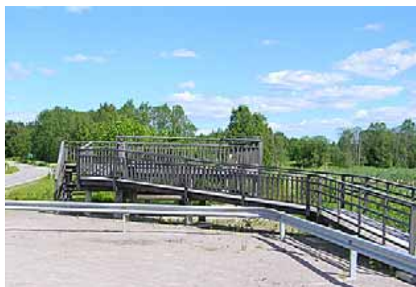
Den här plattformen har placerats i sluttningen av en vägbank vilket underlättar anslutning av ramp och trappa.
