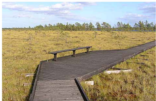
Bra vandringsled av granvirke lagd på blöt mark. Dyrt att bygga och underhålla.
