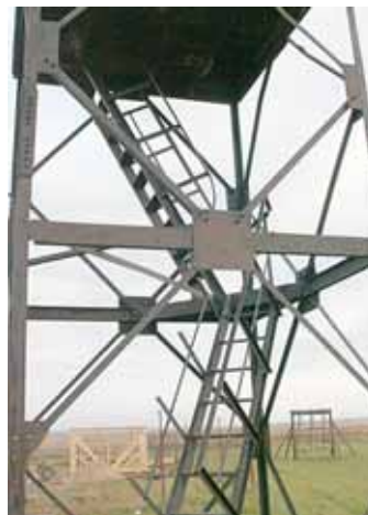
Stål ger en slankare stomme och lång livslängd.
