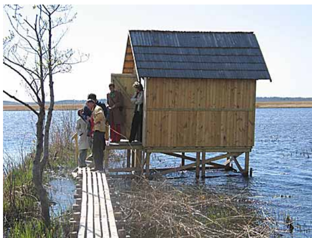
Grundläggning i vatten innebär stora påfrestningar från vatten, is och rötangrepp.
