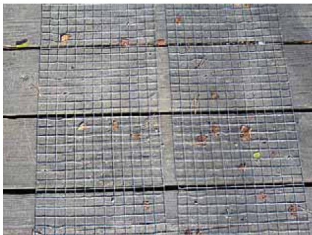
Halkskydd av metallnät. Nätet måste vara tillräckligt grovt, så att det inte går sönder och blir lätt att snubbla på.
