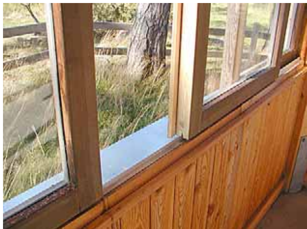
Skjutglaspartier ger stora öppningsytor men de kan vara svåra att få täta i skarvarna vid slagregn.
