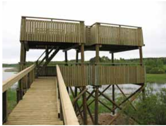
Rantasalmi, Finland. Dubbeltorn, det högra fristående för att minska vibrationer.
