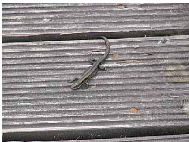
Exempel på en gång som lagts med spårade brädor för att minska halkrisken.
