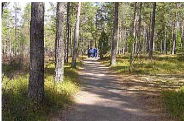
Bra vandringsled på torr mark med yta av bergkross. Billig konstruktion och låg underhållskostnad
