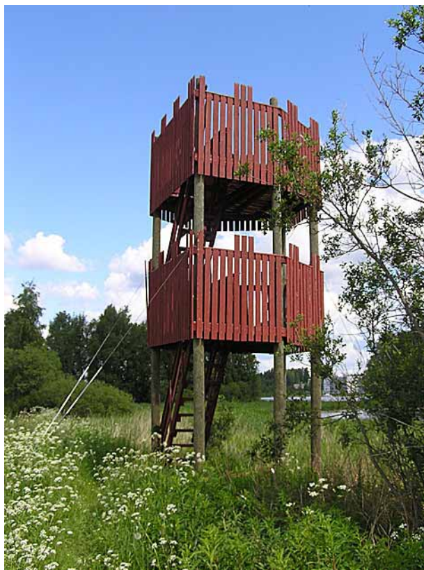
Torn med ovanlig utformning av räcket, Mikkeli Finland.
