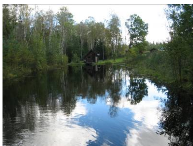
Den norra dammen.
