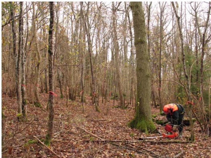
Det mesta av röjningsarbetena gjordes manuellt med motorsåg och röjsåg. På bilden arbetar ett av Skogsstyrelsens lag i Blomberg.
