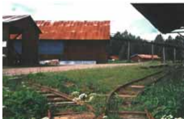
Rytterns torvströfabrik, Falköping. Foto: Per Lindegård.
