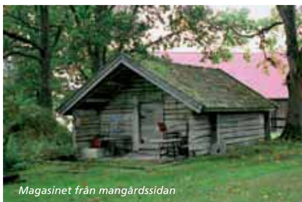
Magasinet från fägårdssidan
