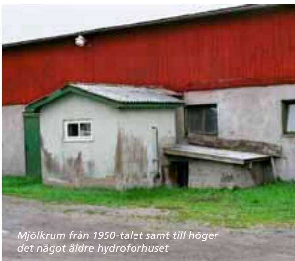
Dörr för utgödning samt gjuten gödselplatta
