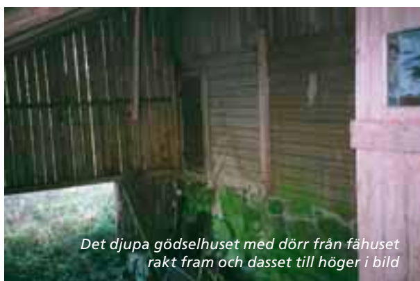
Den täckta gödselstaden är byggd som en stor snedtäcka i stolpkonstruktion
