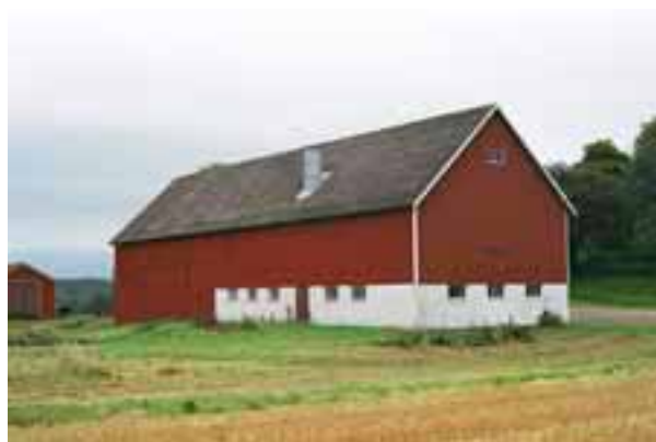
På Brötegården i Ödeborg står denna mycket välbevarade mönsterladugård från 1950. Karaktäristiskt är eternittaket med ventilation från fähuset, den vitmålade stalldelen och den höga skullen. (MOW)
