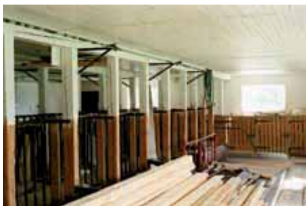
Interiör från det ljusa fähuset med bl.a. fodergrindar i metall och vakuumrör till mjölkmaskinen.
