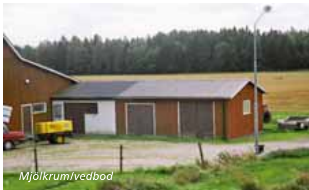
Maskinhall uppförd i vinkel med ladugården
