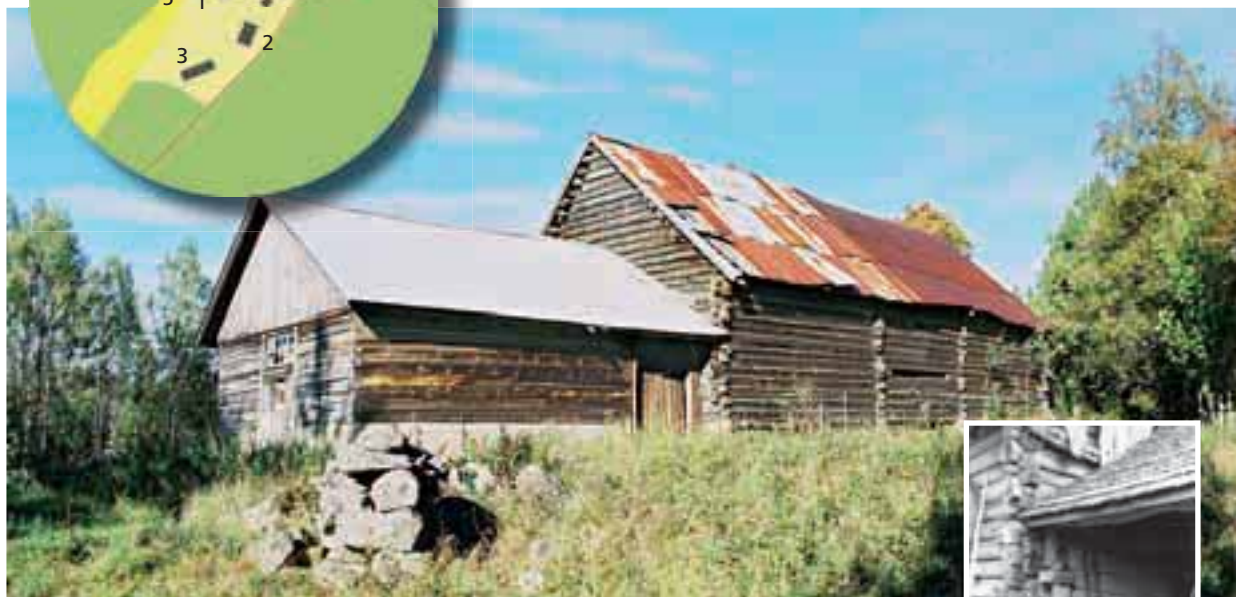
Ovan: Ladugårdslängan. Höger: Dörren in till skålstallet har ålderdomliga trägångjärn. Foto från 1972.
