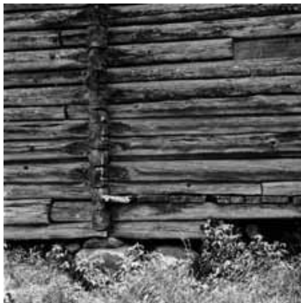
Timrad parloge från före år 1800. Byggnaden har dubbelhaksknutar. Här syns baksidan med loggolvet tillhör synliga mellan ett par av stockvarven och ovanför dem kastgluggen. Höglund i Tisselskogs socken. (GvSINM 1949)
