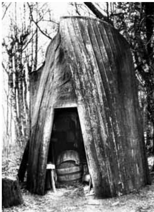
Sjönära bod för fiske och förvaring byggd av en itusågad laxbåt. Typen är karaktäristisk för Vänerkusten. Jakobsbyn, Grinstad socken. (CAA)
