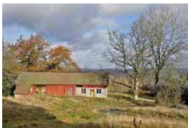
Överst: Denna välbevarade ladugårdslänga från Fagerhult i Gestad socken uppfördes på 1940-talet med fähus i tegel och tak av eternit. Dörrarna leder räknat från från vänster till stallet, mjölkrummet och ladugården. (MOW)
