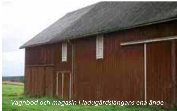
Ladugårdslängan med fähusdelen till höger
