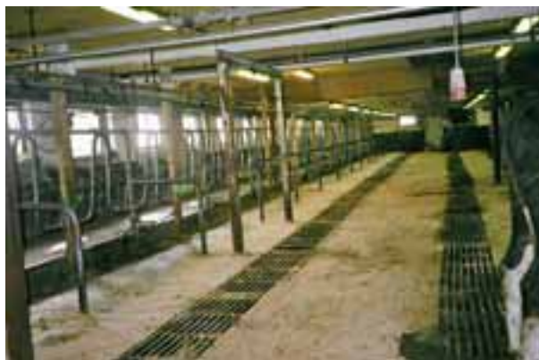
Interiör från 1954 års ladugård där djuren står uppställda mot ytterväggarna, på var sida om en mittgång
