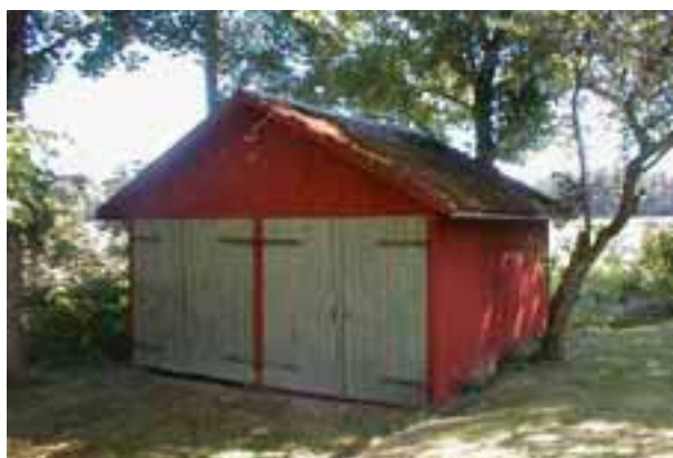
Överst: Invid tillfartsvägen till Östra Bodane i Ånimskog ligger en källarvind med naturstenskällare och träöverbyggnad med brant sadeltak. I källaren har förvarats rotfrukter men hur överbyggnaden använts är idag oklart. En lucka in till detta utrymme finns från baksidan. (MOW)
