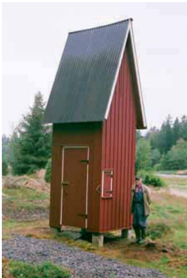
Som ett minnesmärke över elektrifieringen av landsbygden står det lilla transformator tornet kvar på Gömmans marker i Frändefors. Det byggdes på 1940-talet och togs ur drift 1975. Sven Mattsson har sedan vårdat det och använder det som förvaringsbod. (LB)
