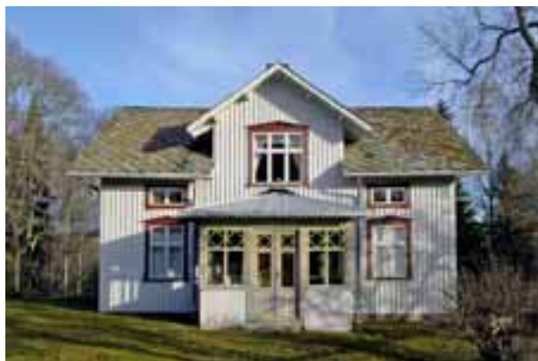
Ovan: Mycket karaktäristiskt västsvenskt dubbelhus från 1880-talet med frontespis och glasveranda i Gälnäs, Torrsjögards socken. Hustypen blev oerhört vanlig på gårdarna i Dalsland under senare delen av 1800-talet och 1900-talets förra hälft. (OE)
