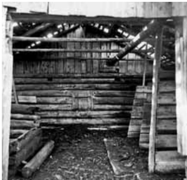
Interiör från ett sommarfähus på Assleruds marker, Håbols socken. Huset som är timrat med rösten av bräder och har spåntak är byggt kring 1900. Det har båsindelning med plats för fem kor och en kalvkätte. (GvSINM 1948)
