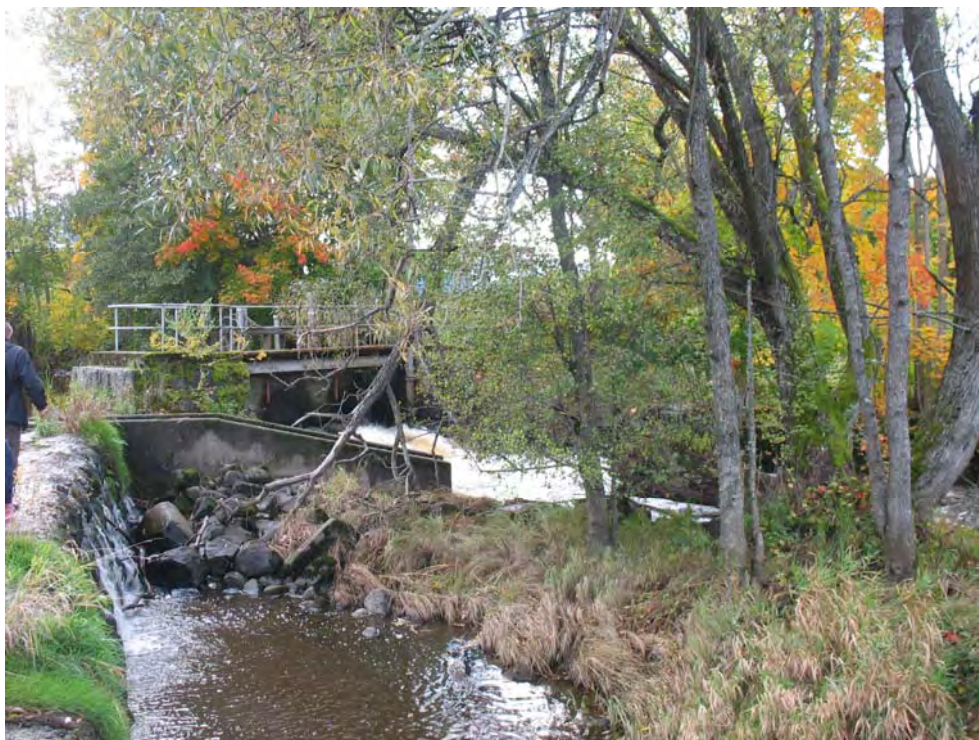
Figur 15. Dammen vid Katrinefors vattenkraftverk. Foto: Niklas Egriell.
