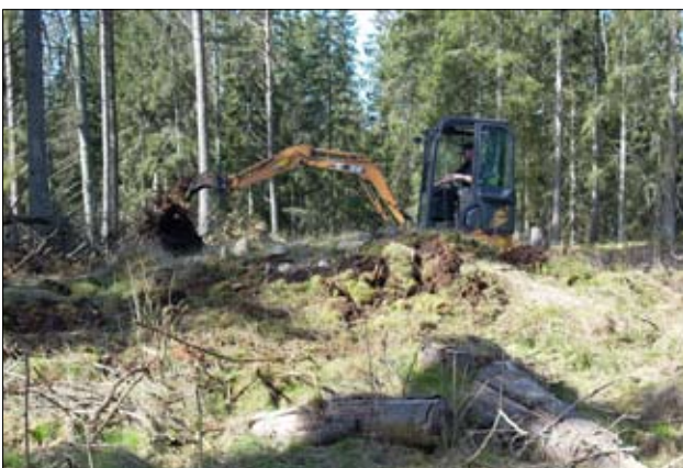
Tranemo 363_2 under arbete.
