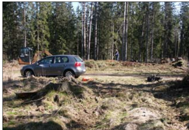
Tranemo 363_1 under arbete.
