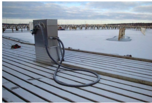
Figur 2. Sugtömningsstationen i Björlanda Kile står placerad så att båtarna vid samma brygga kan tanka och fylla på vatten samtidigt som septiktanktömning sker. Stationen är kopplad till avlopps nätet. Foto taget till denna undersökning.
