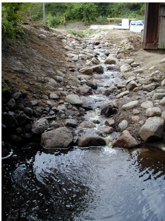
Foto. Den nyanlagda forsén vid Gate kvarn i samband med vattenpåsläpp. Foto: Robert Versa, IGNITA.
