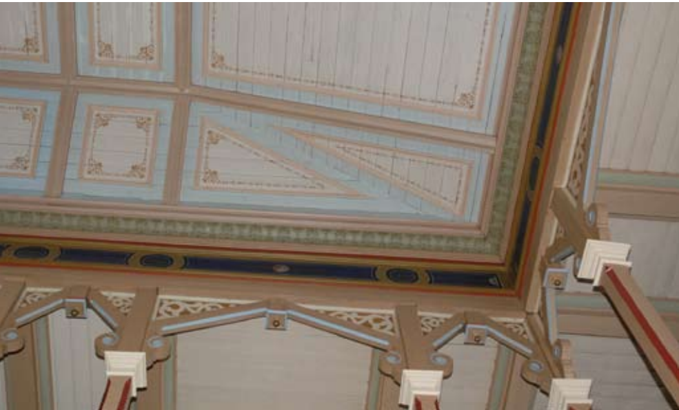
Takmålerierna i Stora salen har restaurerats, måleriet har aldrig varit övermålat.
