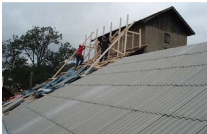
Från ovan: Hålet efter stormen Per. • Arbetsbild med takomläggning
