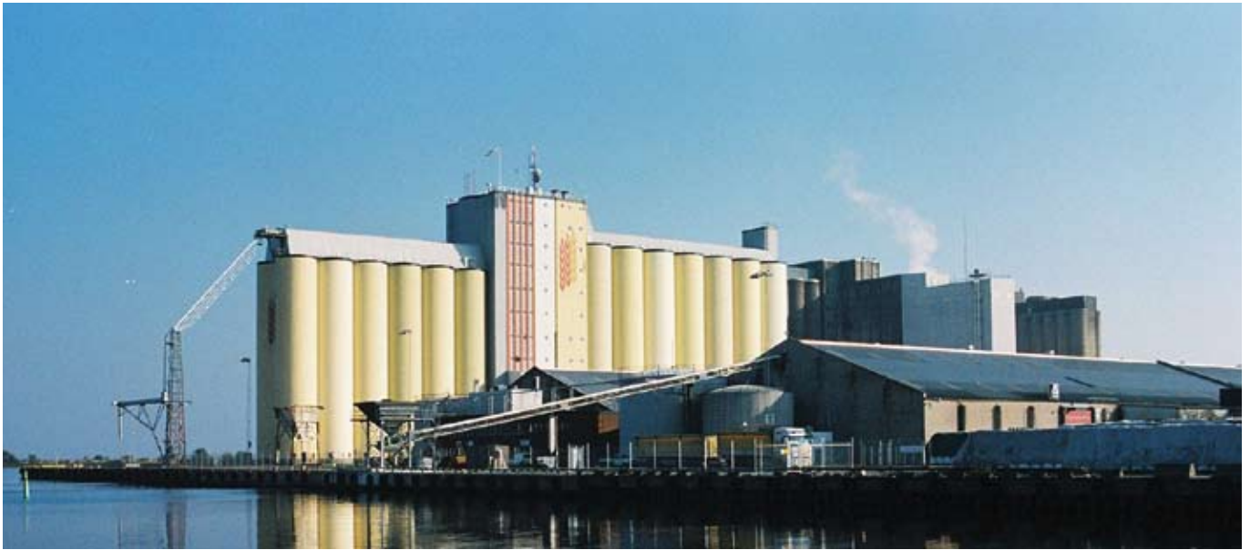
Silos i Lidköping. Den största av lantmännens siloterminaler i Västsverige.
