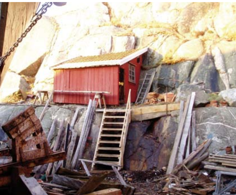
Galvaniseringsboden var i mycket dåligt skick före restaureringen. Efter renoveringen används den gamla galvaniseringsboden för visningar.
