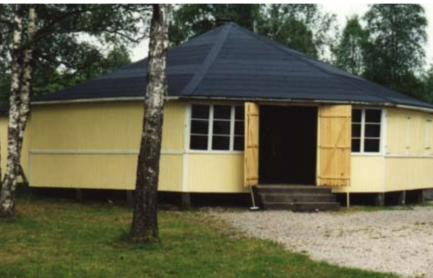
Granbacka festplats i Bäckefors, från 1936 kunde invånarna dansa och umgås här. Efter rivningshot räddades byggnaderna av Bäckefors hembygds- och framtidsförening.
