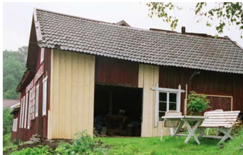
Bilderna visar fasadrenovering.
