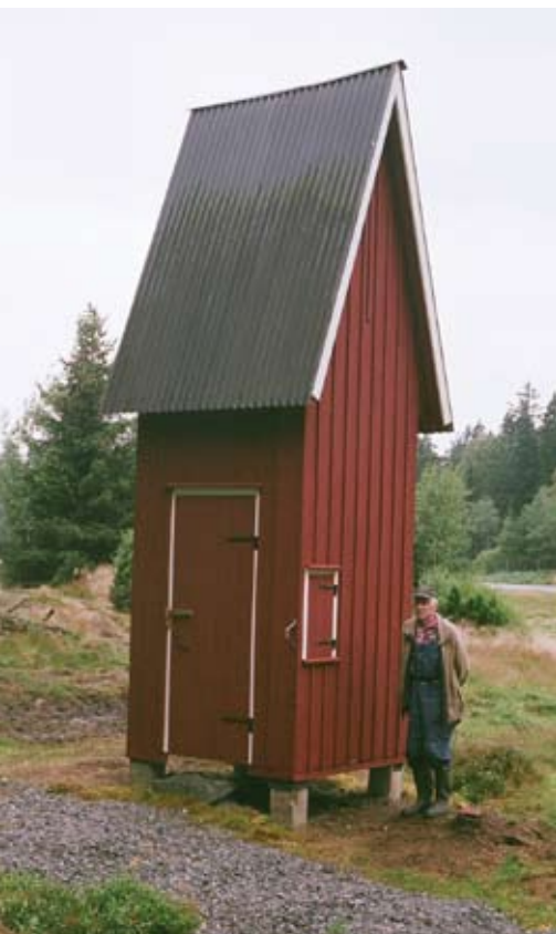
Gömmans transformator i fint skick tack vare uppmuntrande bidrag
