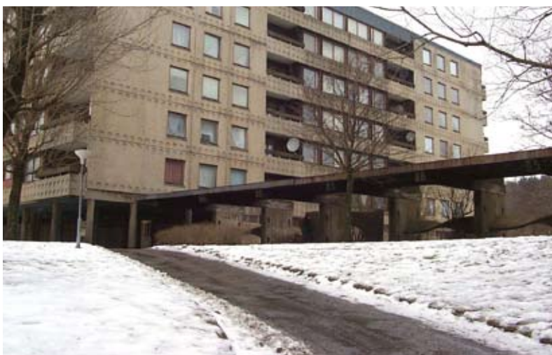
Det restaurerade skärmtaket möjliggör en torrskodd promenad in i området, kantad av betongskulpturer.
