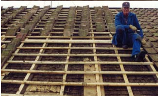
Från ovan: Efter renovering. • Takomläggning.
