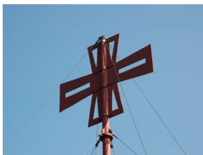
FRÅN OVAN: Sjömärket renoverat efter äldre ritninga • järnkors på Valens topp
