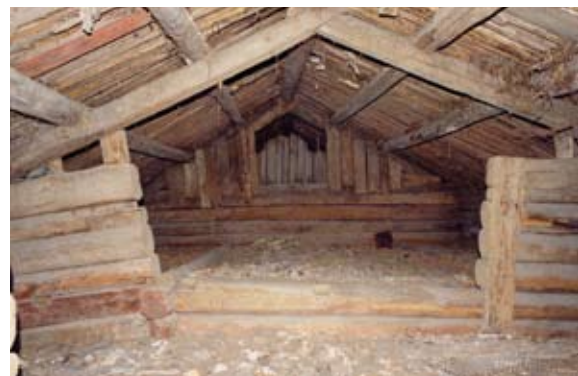
Från ovan: Foto från gården. • Bild från vinden med det grova timret.
