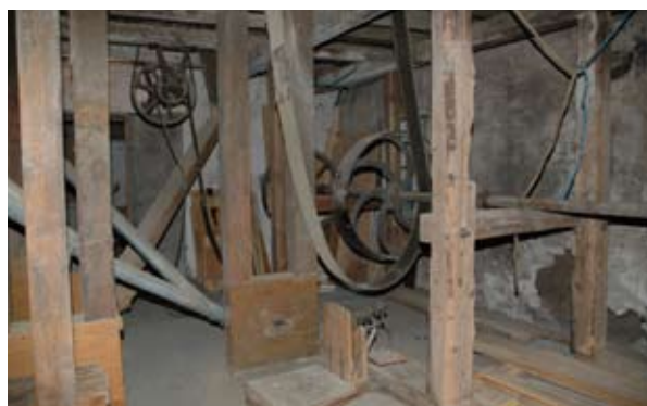
Från ovan: Yttervägg under renovering. • Hillefors grynkvarn, precis invid Säveån. • Inne i kvarnen finns det gamla maskineriet kvar.
