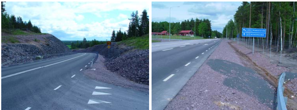
Fig. 18-19. Vägbyggare har anlagt livlösa ökenstrukturer av stenkross flerstädes i Västra Götalands län. Stenskravlet utrotar flora och fauna och hårdgörandet ökar risken för allvarliga skador på personer och fordon vid avkörningsolyckor. Exempel, Bronäs i Skövde kn 3/6 respektive Margretelund i Tibro kn 5/6.
