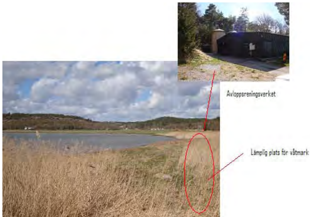
Figur 18. Reningsverket i Svanvik släpper ut utgående vatten i viken Svanviks kile. En våtmark skulle minska utsläppet av kväve och fosfor och fungera som ett extra poleringssteg.
