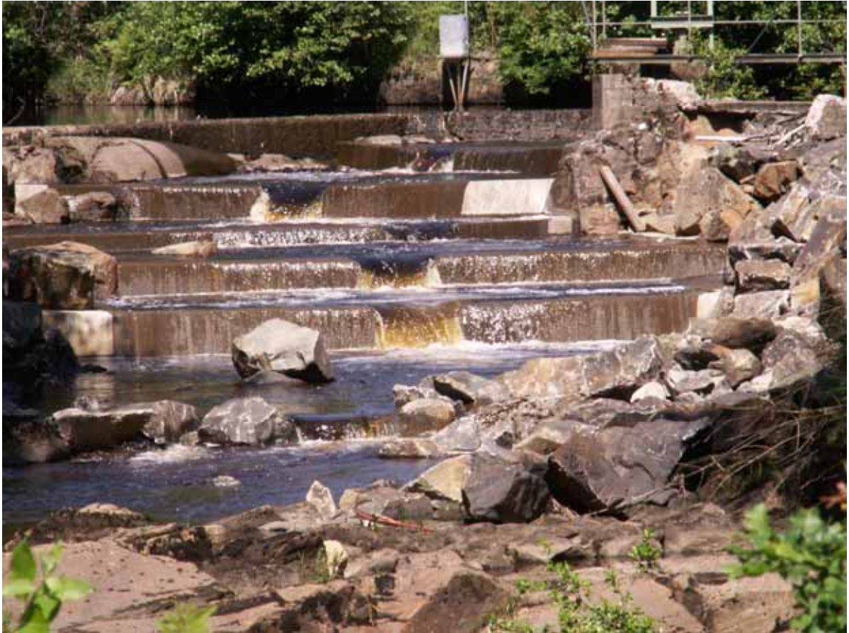
Nya fisktrappan vid Apelnäs kraftverk i Storån.
