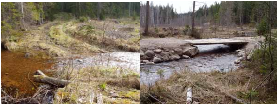
Överfarten nedströms sågdammen i Kasenbergsån före (t.v.) och efter (t.h.) åtgärd
