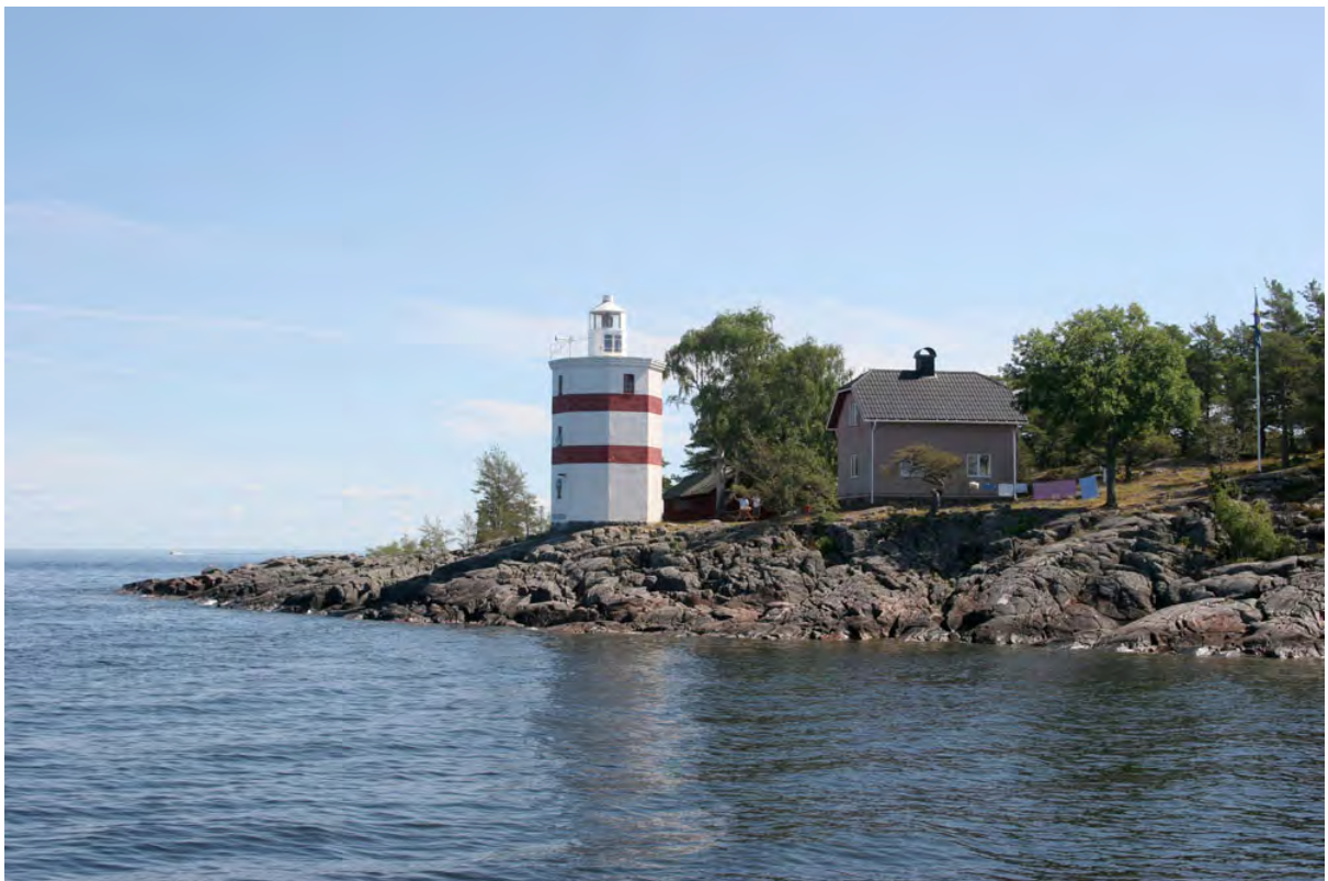
Djurö fyt och fyrvaktarebostad
