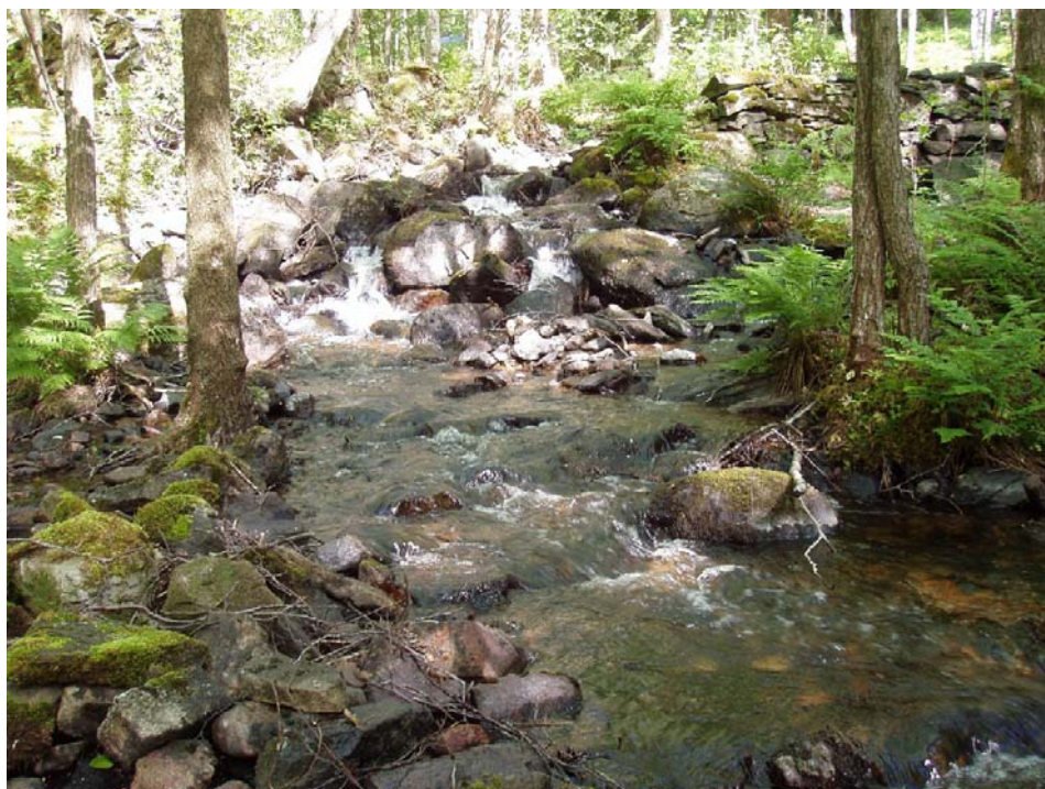
Foto 1. Utriven damm. Nedströmsvy vid dammen vid Ödenäs. Lågt flöde.
