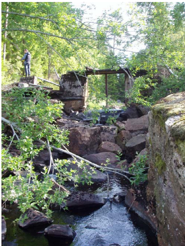
Foto 10. Halvt raserad damm, uppströmsvy vid Sågeviken nedre.
