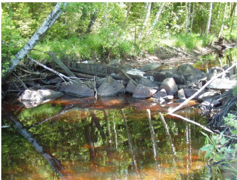
Foto 12. Spjuthult nedre. Uppströms damm.
