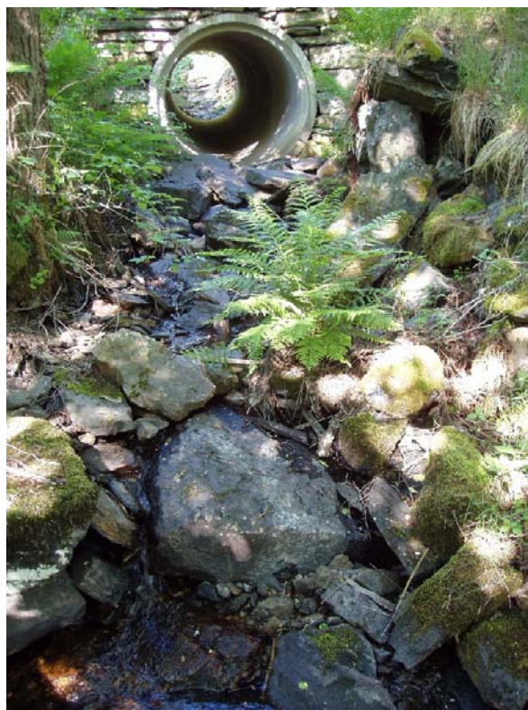
Foto 4. Trumma under väg nedströms bräddavlopp.
