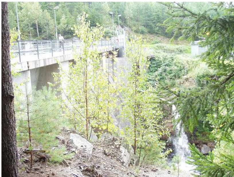
Foto 27. Vandringshinder 3. Strömmens kraftverk Torestorpsån.
