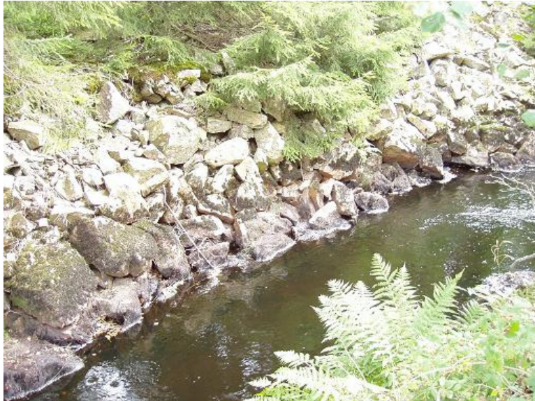
Bild 32. Sprängd kanal i Lundaboån.
