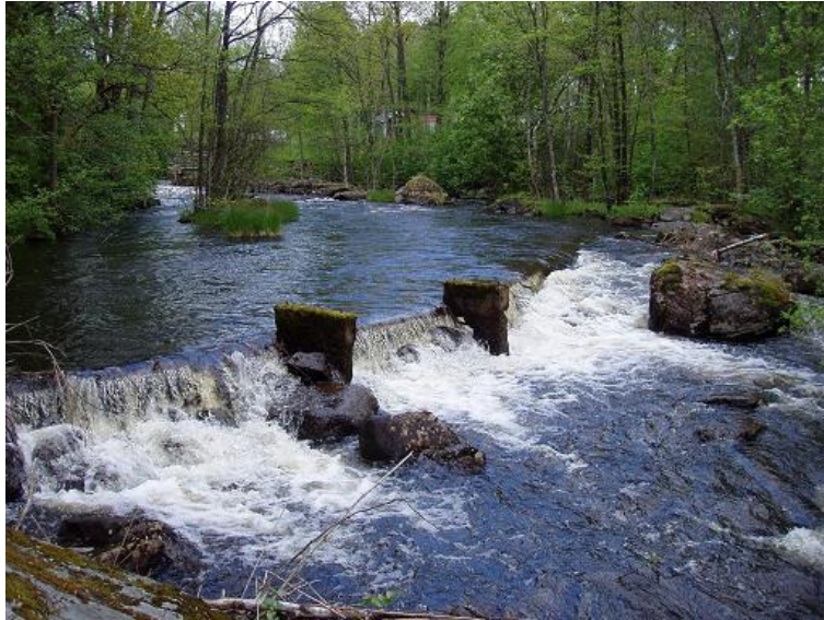
Foto 23. Vattendelare/avskiljare i kvillområdet, Torestorpsån. Vid lågvattenföring styrs vattnet till kraftverksfåran i den övre delen av bilden.
