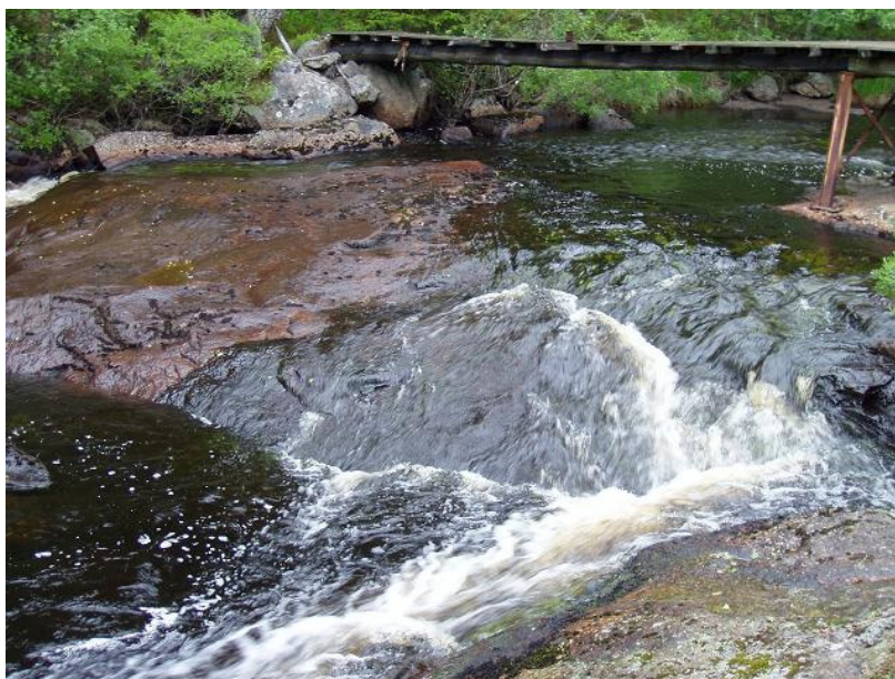
Foto 5. Vandringshinder 6, Bro vid lyckan, naturligt hinder
