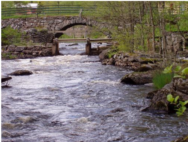
Foto 26. Vandringshinder 2. Partiellt hinder, Torestorpsåns regleringsdamm.
