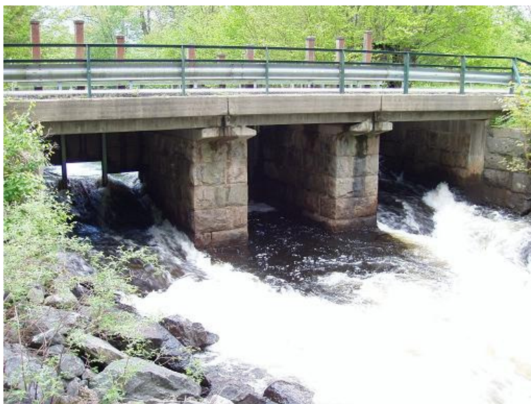
Foto 16. Vandringshinder i Hyltenäsån, Tolken regleringsdamm.
