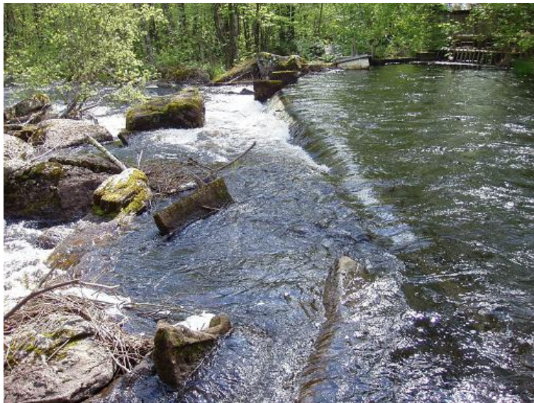
Foto 24. Vattendelare/avskiljare i kvillområdet, Torestorpsån. Vid lågvattenföring styrs vattnet till kraftverksfåran som syns till höger i bildens övre del (gallergrind).
