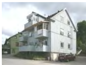
Arbetarbarack med tillbyggda balkonger.
