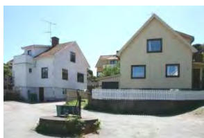
Ombyggda hus med eternit-fasader och enlufts-fönster.
