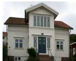
Tillbyggd veranda med vackert spröjsade fönster.
