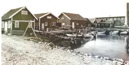
Konservfabriken på Malmön finns kvar 1970.
