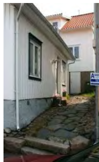
Trappsteg läggs in för att underlätta.
