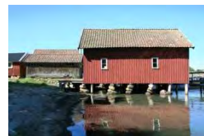
Upplag av travad sten för att nå ut till djupt vatten.
