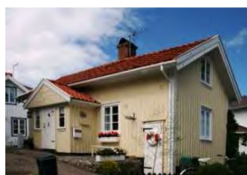
Enkelhusen har från början inte ståhöjd på vinden.
