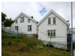
Äldre dubbelhus och påbyggt enkelhus i rad.
