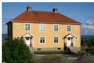
En välbevarad större f d stenhuggarbarack.
