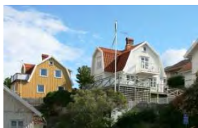
Husen byggs för både fiskare och stenhuggare.
