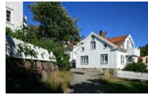
Takkupor och balkonger är senare tillägg.
