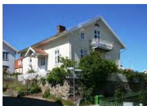
Skepparhus med smidesbalkong på gaveln.
