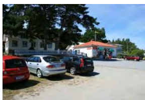
Affären på Rossö har valmat tak och vita väggar.
