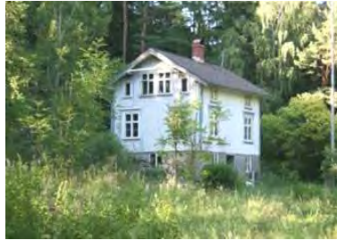
Fönstren är stående och spröjsade. Fasaderna är oftast klädda med profi- och pärlspontad slätpanel.
