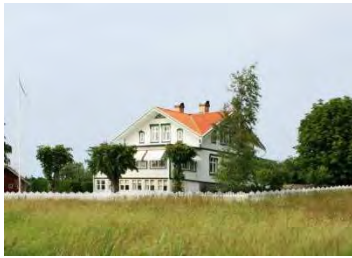
Den stora fd pensionatsbyggnaden på Karnäs är ett av de stora vita fyrfrontshusen med typiskt gröna snickerier.
