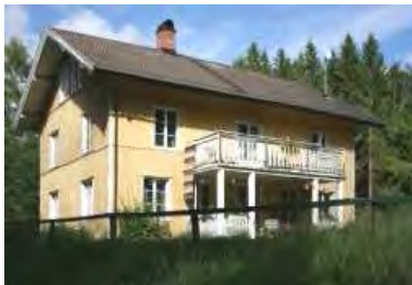
Skorstenarna är höga och smala. Ibland har husen klätts med locklistpanel och klätts med betongpannor på taket.
