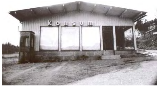
Konsumbyggnaden stod tom sedan början på 1970-talet men hade fortfarande kvar sin mycket tidstypiska form enligt typritningar från KF:s arkitektkontor på 1930-talet.
