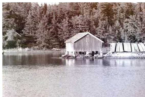
Hummersumpar vid Rossösundet på 1970-talet. Magasinet är nu upprustat med byggnadsvårdsmedel.
