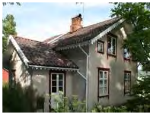
Tillbyggnaden är stor men utförd med material och formspråk som stämmer med huvudbyggnaden.
