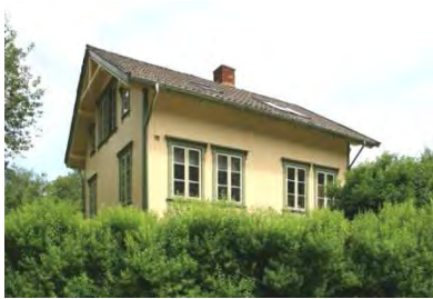
Karaktärsdrag för hus i Krokstrand är tunna tak klädda med tegel och med korsformad dekor på gaveln.
