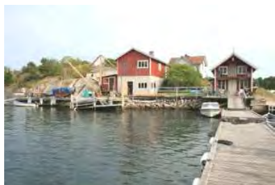
Vid Killingholmen har bland annat båtbyggeri bedrivits, vilket kranen och den höga byggnaden vittnar om.
