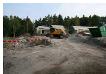
Den mesta nybebyggelsen sker i skogsmark där stora markarbeten jämnar ut den kuperade terrängen
