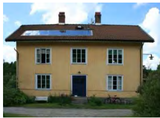
En av de stora arbetarbarackerna har försetts med stora solfångare på taket men har i övrigt bevarad karaktär.
