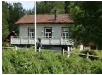
Ombyggnader som inte kräver bygglov är vanliga. Här är nya fönster, en ny skorsten och en altan.
