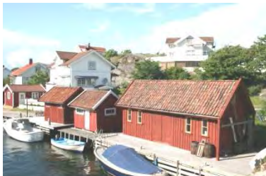
Magasin och bodar är grundlagda på travade stenar, träpålar, plintar och betongsten mm.
