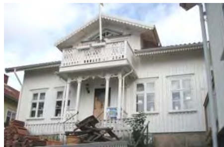
2010 har fönstren vitmålat liksom hela huset och en ny balkong har tillkommit ovanpå förstukvisten.
