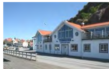
Uppdelningen av långa fasader med tvärgående sadeltak är ett vanligt motiv i Grebbestad.
