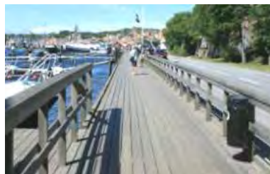
En avskärmad ”bryggväg” har anordnats längs bilvägen. Rester av Badhusparken ligger vid berget.
