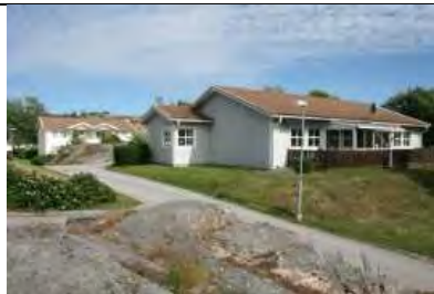
Öster om det gamla samhället har flera välplanerade grupphusområden byggts i slutet av 1900-talet.
