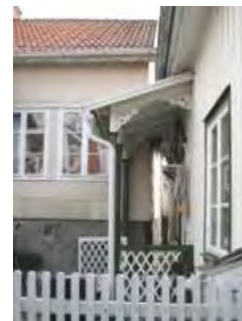
2010 har det tillkommit ett stuprör med ränna, ett spjälstaket, och spröjsade fönster.
