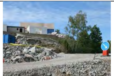
2010 har Härlidsberget plansprängts för byggnad av nya uppstickande bostadshus med utsikt.
