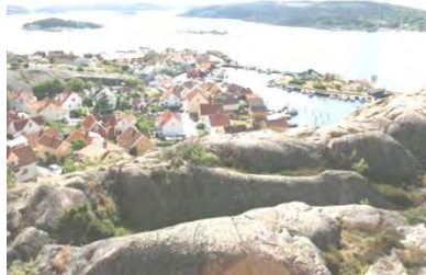
Innanför Badholmen ligger den gamla Fiskhamnen och rader med små och stora bodar med bryggor.
