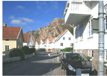
2010 är flera av husen helt vitmålade men stora tillbyggnader saknas mot gatan där täpporna ersatts av bilplatser.
