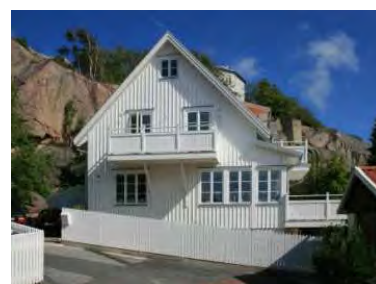
Huset från 1930-talet har fått balkonger, nya fönster och en veranda - typiska för 2000-talet.
