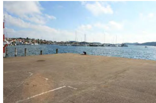
På sommaren 2010 låg kajplanen öde eftersom den enbart tål begränsad belastning – utrustning krävs om den ska fungera som fullgod anlösningsplats.
