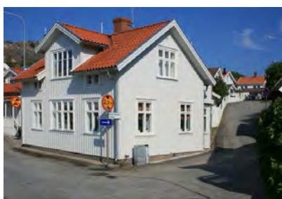
Detta större dubbelhus har tidigare varit falurött med ljusa omfattningar kring fönster och dörrar.
