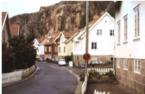
Husen längs Södra Hamngatan byggdes på 1930-talet efter branden 1928. På 1970-talet hade de troligen fortfarande sitt ursprungliga utseende.
