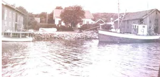
På 1970-talet var ett magasin på Hjärterö i dåligt skick liksom kajen.
