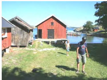
Sjöbodarna har olika ålder. De är traditionellt utformade och upplagda på travad sten eller plintar.
