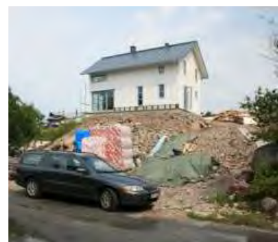
I ytterkanterna av Bovallstrand har nya hus byggts på utfylld mark för att få maximal utsikt.
