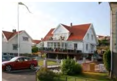
Mitt i ett gammalt kvarter har ett nytt stort hus byggts med traditionellt formspråk och stor veranda.
