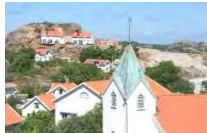
Ny bebyggelse är under uppförande på det tidigare stenbrottet i Stora Korpåsberget.
