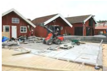
En stensatt plan och stora trädäck med brädiskoning mot vågorna anläggs utanför sjöbodarna.
