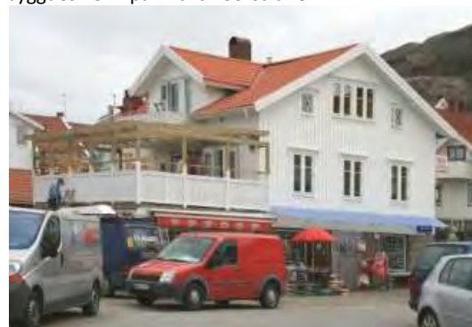
En f d butiksfastighet blir minilivs med restaurang och förses med träfasader, spröjsade fönster och veranda.
