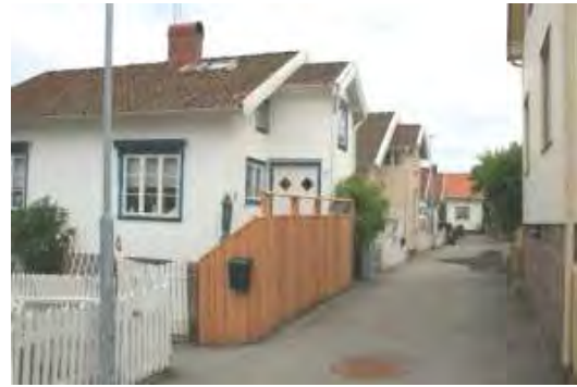
Små tillbyggnader, utbytta fönster och ändrat takmaterial är vanliga – däremot inte plank.
