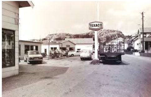
På 1970-talet var biltrafiken problematisk på Strandgatorna med varudistribution till olika verksamheter.
