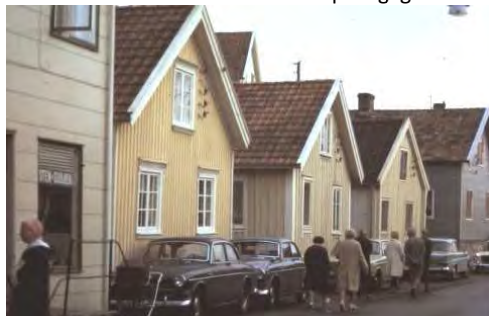
På 1970-talet var butikshuset klätt med eternit liksom flera av de små dubbelhusen. Bilarna stod tätt utmed Södra Strandgatans fasader.
