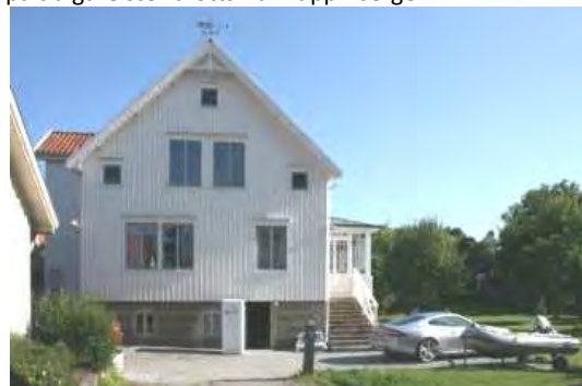
Ett av de största husen har höga stensocklar, utbyggda verandor och förändrad fönstersättning.
