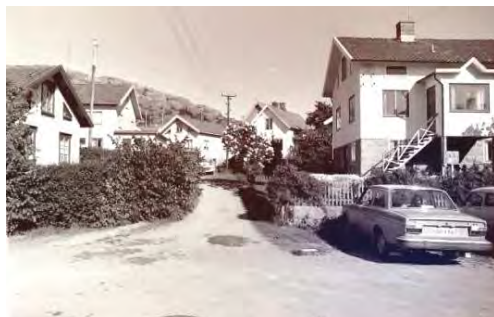
Området från början av 1900-talet nära södra hamnen hade 1970 i stort sett ursprunglig karaktär.
