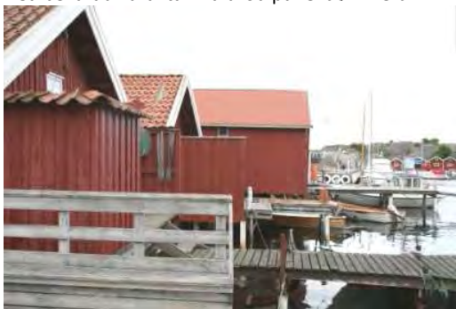
Taken med olika form och lutning är täckta med material som lertegel, betongpannor, plåt eller eternit.
