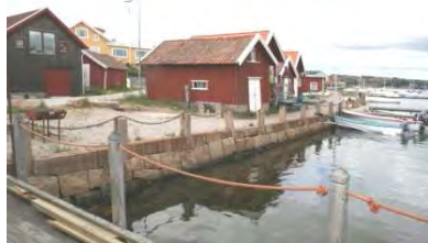
I den norra delen av hamnen kantas kajen av huggen sten, pollare och kätting.
