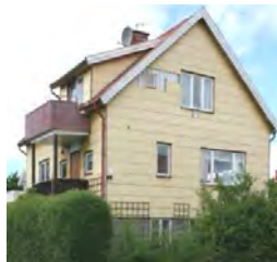
På 1940- och 50-talen byggdes dubbelhus med branta tak och träfasader. En del kläddes med eternit.
