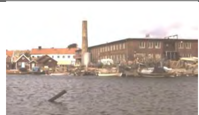
En konservfabrik uppförs på utfylld mark vid samhällets strandområde.
