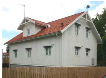
Nyttillkomna bostadshus har olika karaktär. De byggs av traditionella material men är oftast mycket stora.
