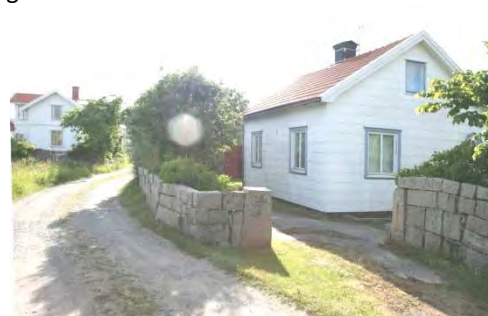
Husen, murarna och vägen har i stort sett samma utseende 2010.
