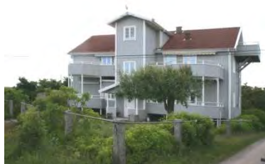
Den fd stenhuggarbostaden har försetts med trapphus och flera balkonger.
