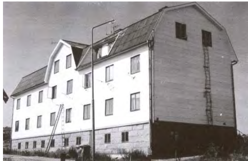
Det stora flerfamiljshuset för stenhuggarfamiljer hade på 1970-talet har klätts med eternitplattor.
