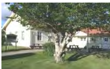
Den gamla folketshusbyggnaden har rivits och ersatts med en ny intill parken med dansbanan.
