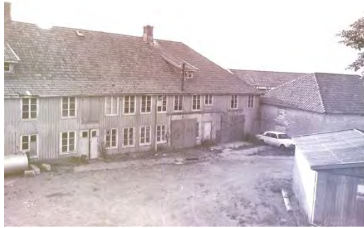
På 1970-talet stod konservfabriken tom och övergiven då verksamheten lagts ner.
