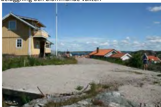
De nya vägarna uppe på berget är endast grustäckta. Ordnad avslutning mot kanterna saknas ännu.
