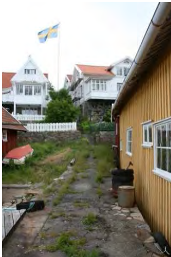
Gångvägarna ner mot stranden är oftast uppbyggda av fältsten
