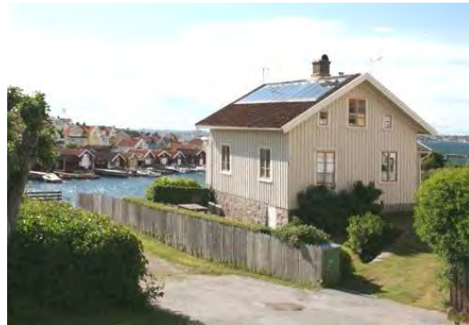
Ett av de mindre dubbelhusen har ursprunglig form och fönstersättning och solpaneler på taket.
