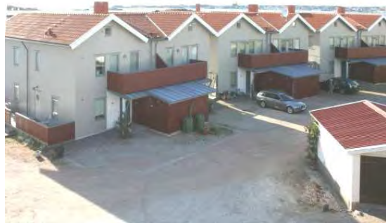
2010 har en del av fabriksbyggnaden ersatts av nya bostadshus i radhusform. Ett uthus står kvar.
