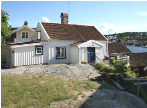
I den äldsta delen av Östersidan finns flera enkelhus som oftast har byggts till på olika sätt.
