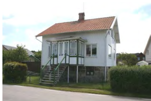
Ett dubbelhus med plastpanel och liten förstuga.
