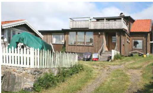
Stora om- och tillbyggnader samt byte av fasadmateriel och fönster har förändrat karaktären helt.
