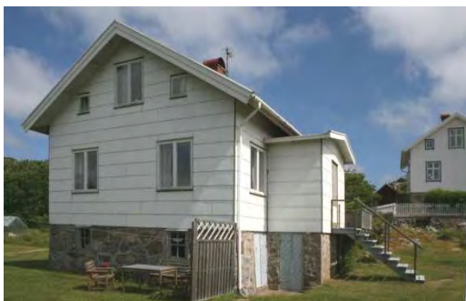
Ett av de två eternitklädda husen i Stockevik med traditionell form och hög stensockel.
