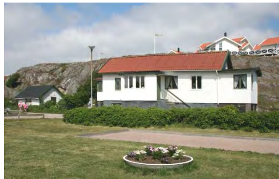
Ett förlängt enkelhus med eternittak, plastpanel och tvåluftsfönster.
