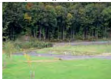
Figur 113. Restaurering av vattendrag – Weesenstein, Tyskland.
