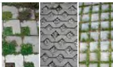
Figur 97. Genomsläpplig markbeläggning, Malmö.
