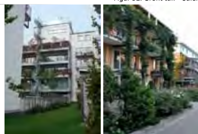
Figur 93-94. Grön fasad – Malmö & grön fasad i Freiburg – Tyskland.
