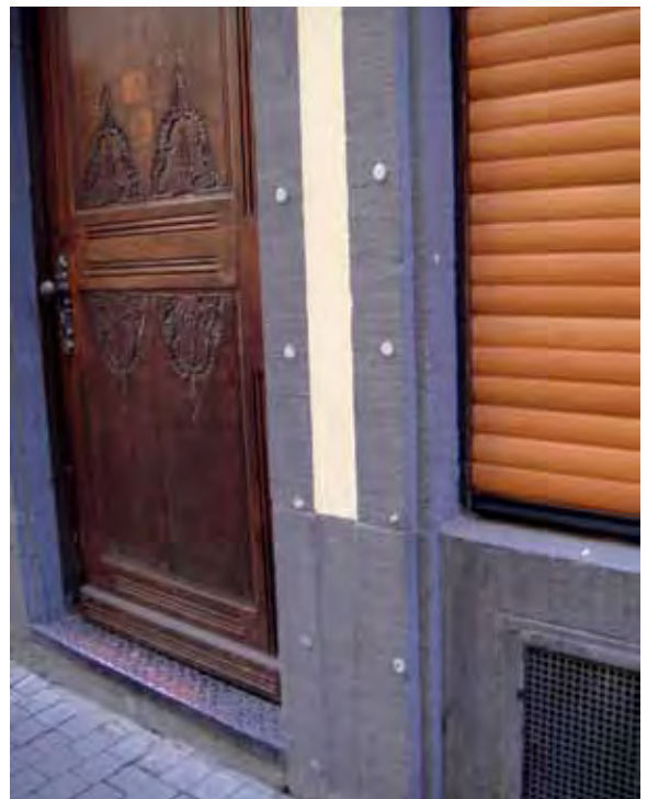
Figur 52. Temporära skydd i Köln, Tyskland.
