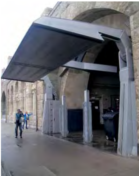
Figur 50. Tillfälligt skydd i stadsmuren i Hamburg, Tyskland.
