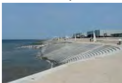
Figur 119. Mångfunktionellt översvämningskydd i Cleveleys – Lancashire, UK.
