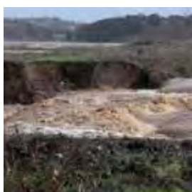
Figur 17. Brott i jordvall vid extremt högt flöde.
