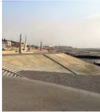
Figur 39. Mångfunktionellt översvämningskydd i Cleveleys – Lancashire, UK.
