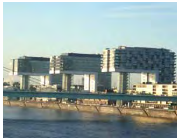
Figur 51. Upphöjda hus i område som översvämmas – Köln, Tyskland.
