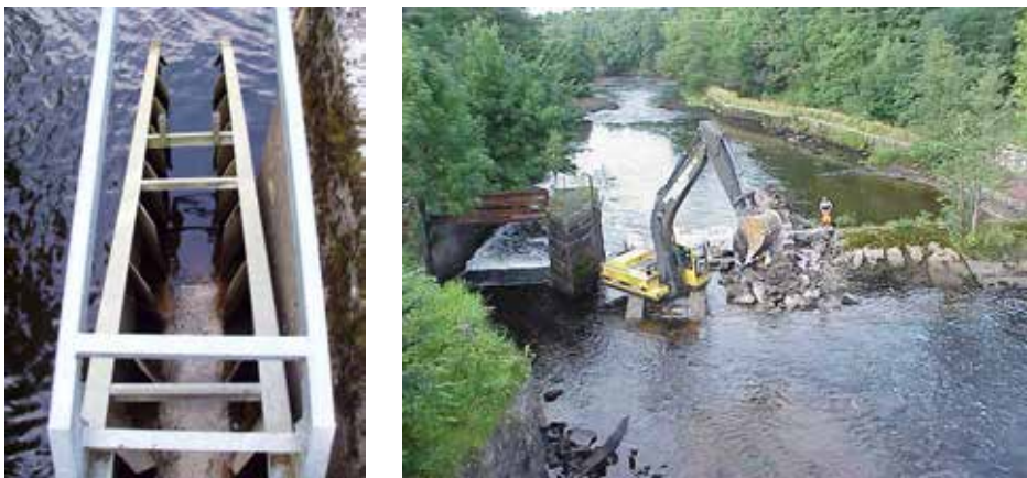
Bilden till vänster utgör ett exempel på hur en denilränna kan vara konstruerad. Bilden till höger är ett exempel på utrivning av en gammal damm. Foto: Länsstyrelsen i Västra Götaland.
