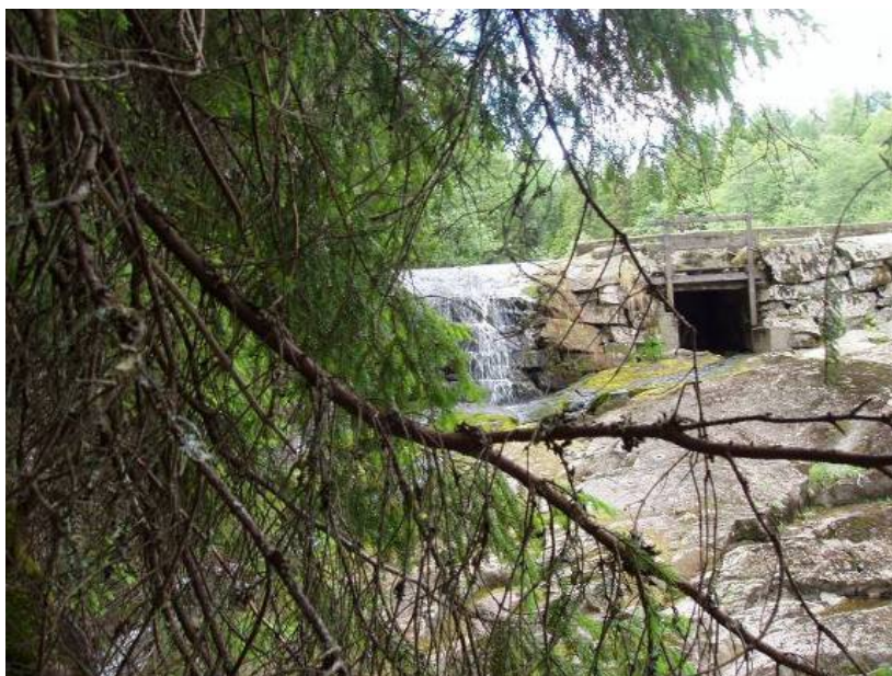
Damm vid Kvarnehögen i Grimån. Länsstyrelsen i Västra Götalands län.
