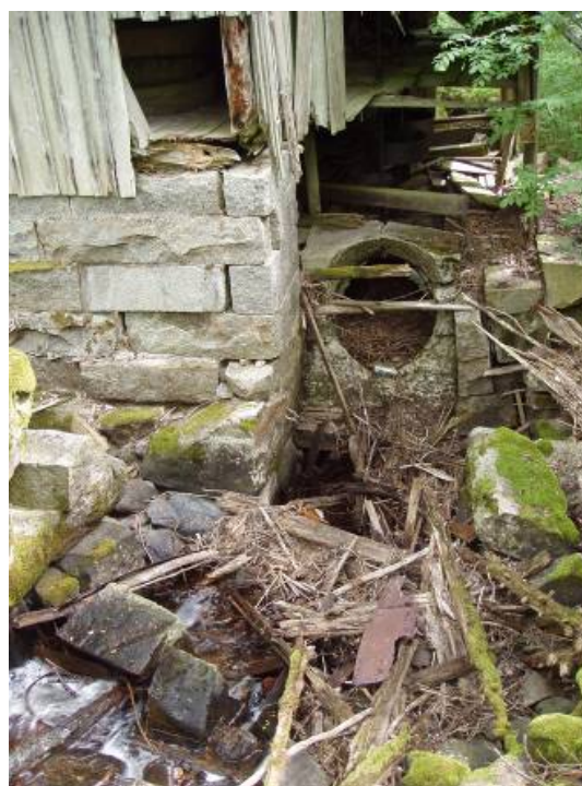
Bilden till vänster visar rännan som en gång ledde vattnet till turbinerna i kvarnhuset. Bilden till höger visar det förfallna kvarnhuset. Bråten från förfallet skapar vandringshinder. Länsstyrelsen i Västra Götalands län.
