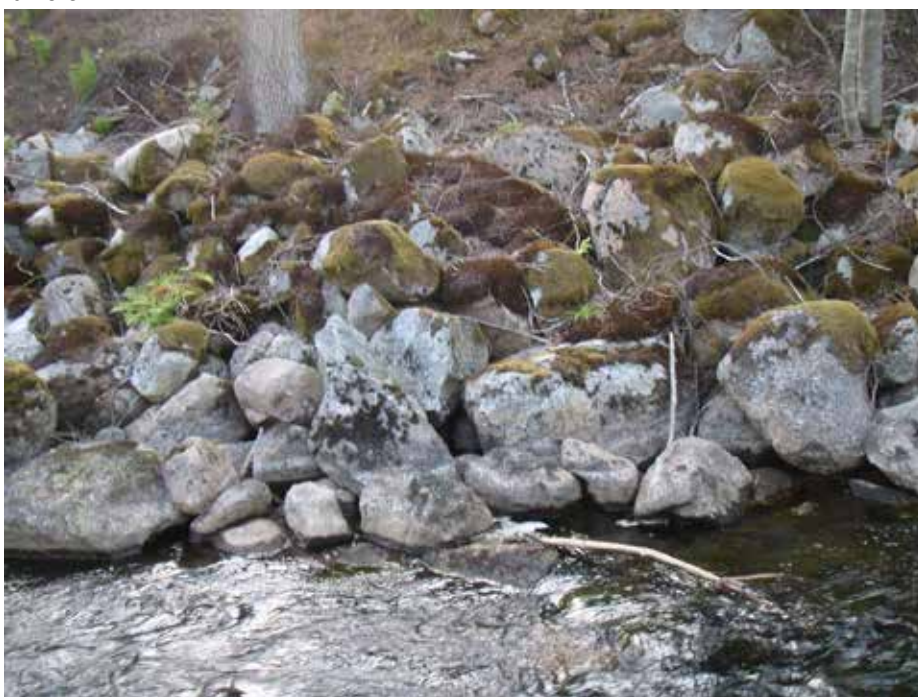
Rensningar i de övre delarna av i Ørbekken, strax före Ørsjøens utlopp. Foto: Daniel Johansson
