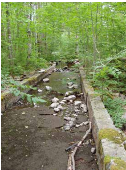
Bilden till vänster visar rännan som en gång ledde vattnet till turbinerna i kvarnhuset. Bilden till höger visar det förfallna kvarnhuset. Bråten från förfallet skapar vandringshinder. Länsstyrelsen i Västra Götalands län.
