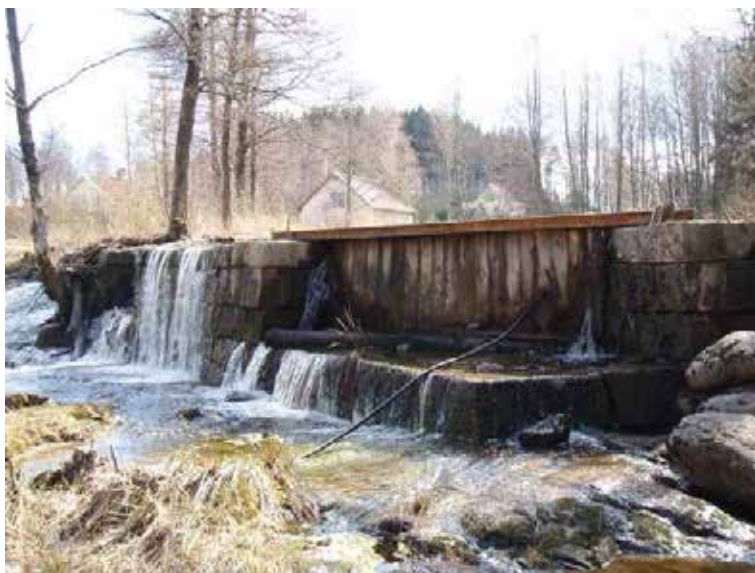
Den gamla kvarndammen belägen ca 400 m uppströms Torpbäckens mynning i Norra Bullaresjön utgör det första artificiella vandringshindret. Foto: Länsstyrelsen i Västra Götalands län
