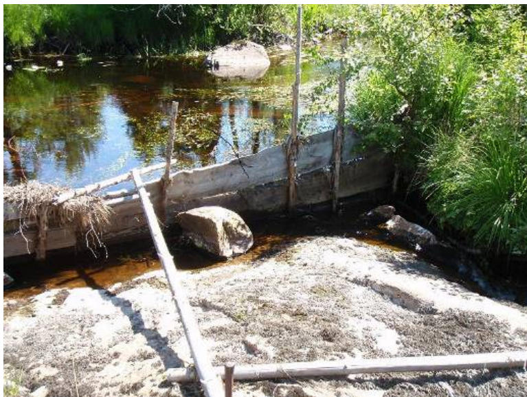
Bilden visar blockeringen som stänger av sidofåran så att all fisk måste gå genom ålkistan. För uppströmsvandrande fisk utgör planken ett effektivt vandringshinder. Foto: Daniel Johansson
