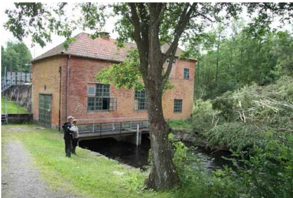
Figur 58. Vandringshinder 1 i Rolfsåns västra fåra vid Ålgårda, med på bild är biotopkarterare Niklas Wengström (Sportfiskarna) och Daniel Helsing, kommunekolog i Kungsbacka kommun. Till höger i bild syns fällna träd som är en del av arbetet med att anlägga fiskvägen runt Ålgårda kraftverk.
