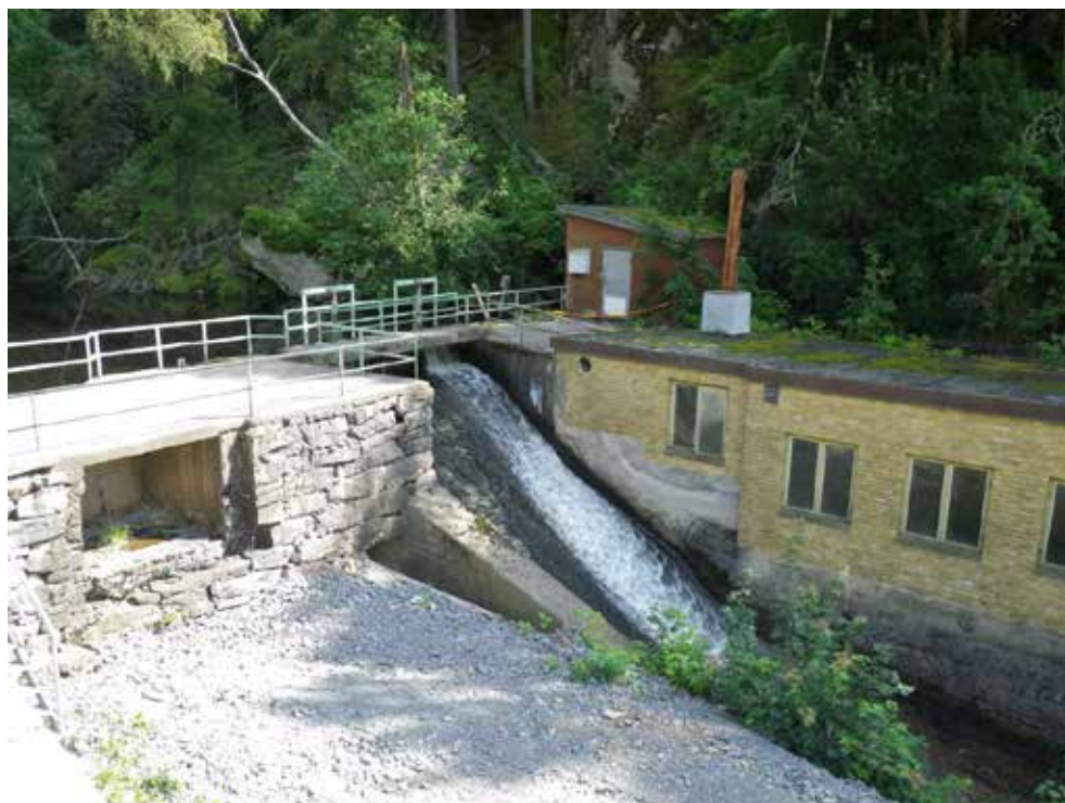
Figur 78. Vandringshinder 2 i Sörån är en damm som ligger vid Hultafors. Ån leds dels in i en kanal som går in under den lilla röda tegelbyggnaden i bild och dels ned för den branta hällen.
