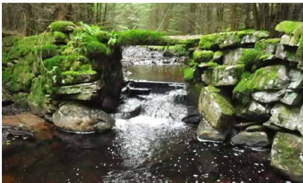
Figur 20. Vandringshinder 1 i Ekån. En gammal damm rest som idag utgör ett partiellt vandringshinder för öring i ån.
