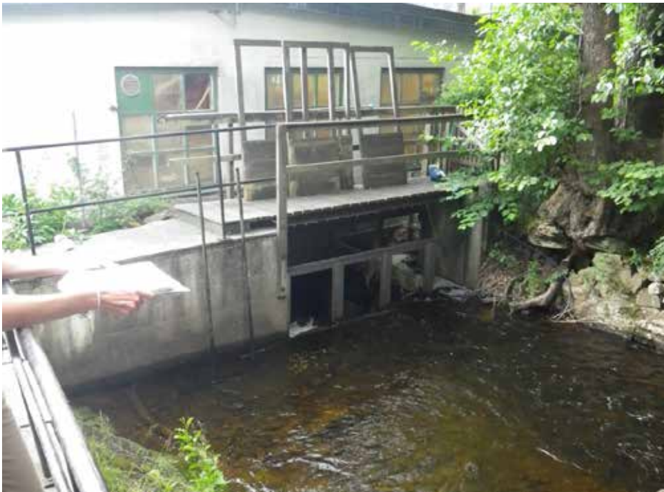
Figur 93. Hinder 2 i Fälån är ett definitivt hinder som utgörs av en damm. Bilden är tagen ovanifrån hindret.
