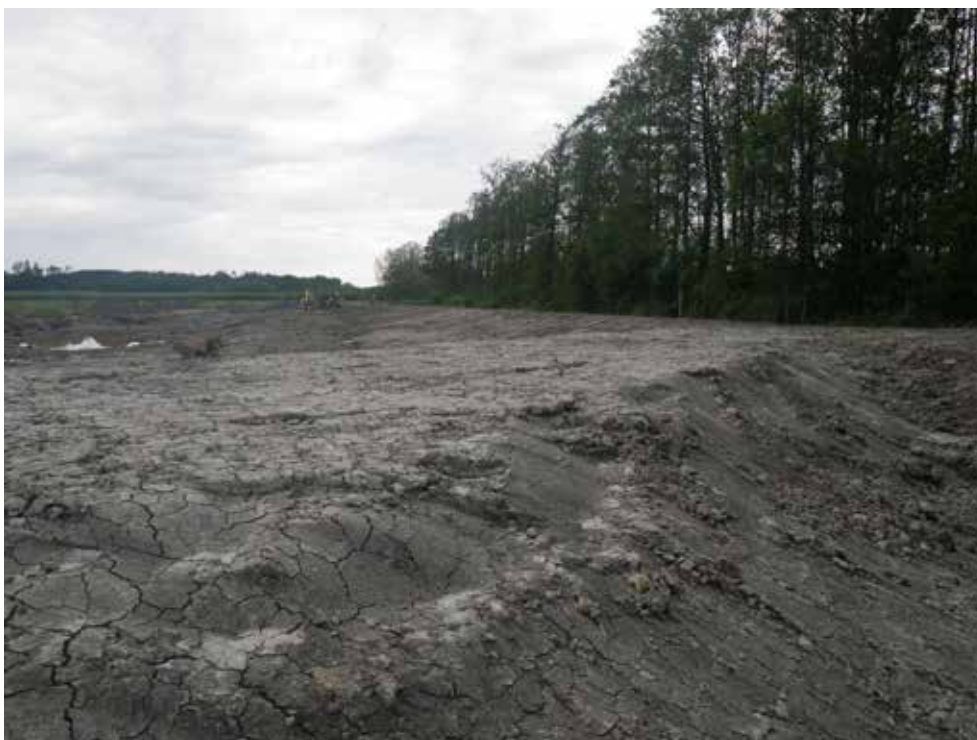
Figur 56. Anläggning av en våtmark på sträcka 35 mellan Gåsevadsholm och Hjälmsån, skyddszone är mellan 3-10 m till Rolsån.
