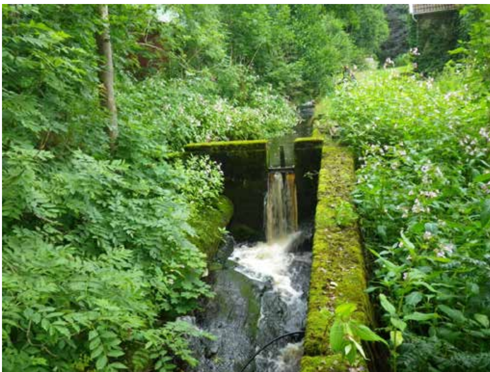
Figur 41. Vandringshinder 6 i Skrålabäcken. Hindret ligger i anslutning till kvarnen i Skene och har förmodligen haft en historiskt viktig funktion för kvarnverksamheten. Idag är funktionen okänd.
