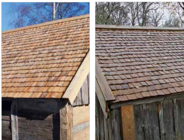
Spånet är lagt efter två olika metoder. Det till vänster (ladugården) sägs vara hållbarare i längden medan det till höger (ryggåsstugan) ska stå sig bättre mot hårda vindar oavsett vilket håll den kommer från.
