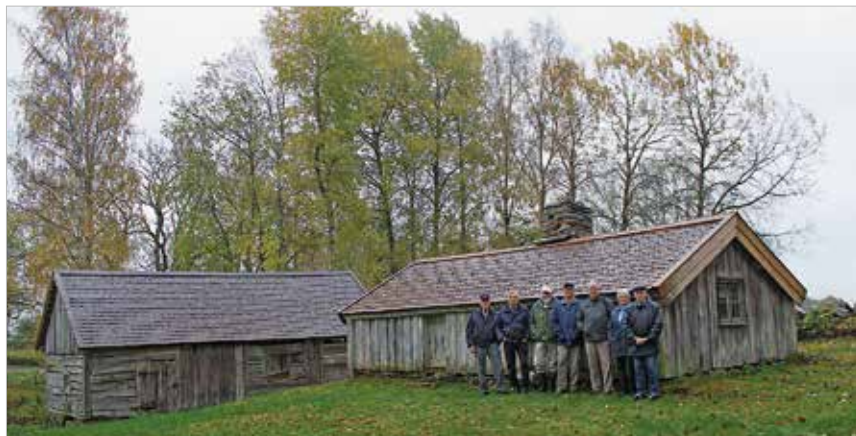
Medlemmar från föreningen utanför ryggåsstugan ett år efter att den färdigställts. Från vänster: Kjell Claesson, Gunnar Åkesson, Börje Brorson, Lennart Davidsson, Leif Brunnegård, Marianne Lindh och Egon Hjälml.
