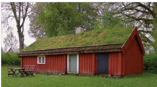
Den lilla ryggåsstugan före och efter takomläggningen. De nya vindskivorna målades med falu rödfärg.
