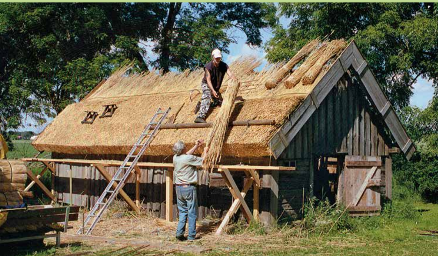
Vasstaksläggning i Levene fornby. Lars Galle lägger vass med assistans av Håkan Brander från Levene hembygdsförening.
