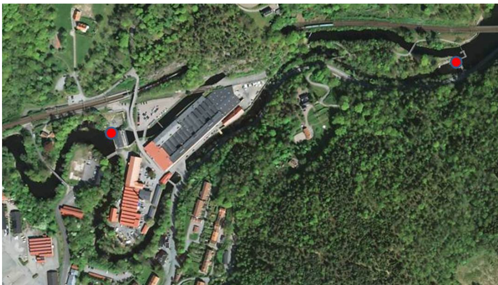
Figur 1. Kraftverket vid Jonsered i Säveån. De två fiskvägarna är utmarkerade med röda prickar (Jonsereds nedre fiskväg till vänster i bild och Jonsereds övre till höger).
