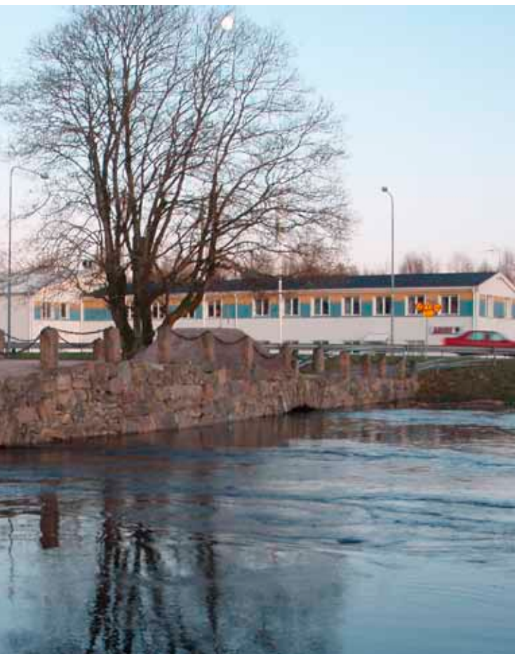
▲ Gamla valvbron, Svenljunga. December 2012. Foto: Leif Isberg, Länsstyrelsen i Västra Götalands län
