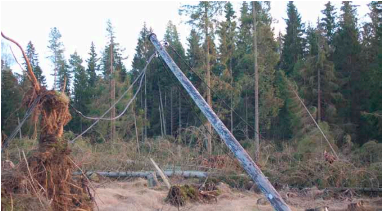
▲ Nedfallen elledning under Stormen Per, januari 2007. Foto: Per Andersen, Ulricehamns kommun
