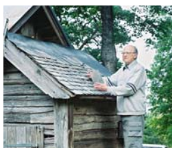
Olov Ljung lägger om skiffertaket på ett dass i Dalsland.
