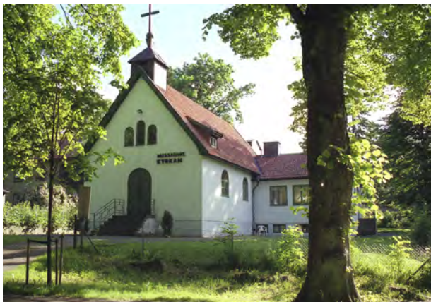
1945 byggdes Nya Varvets Missionskyrka i Göteborg, ritad av arkitekt Per Mårtensson.
