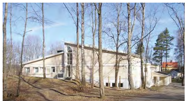
Byggnaden från söder.
