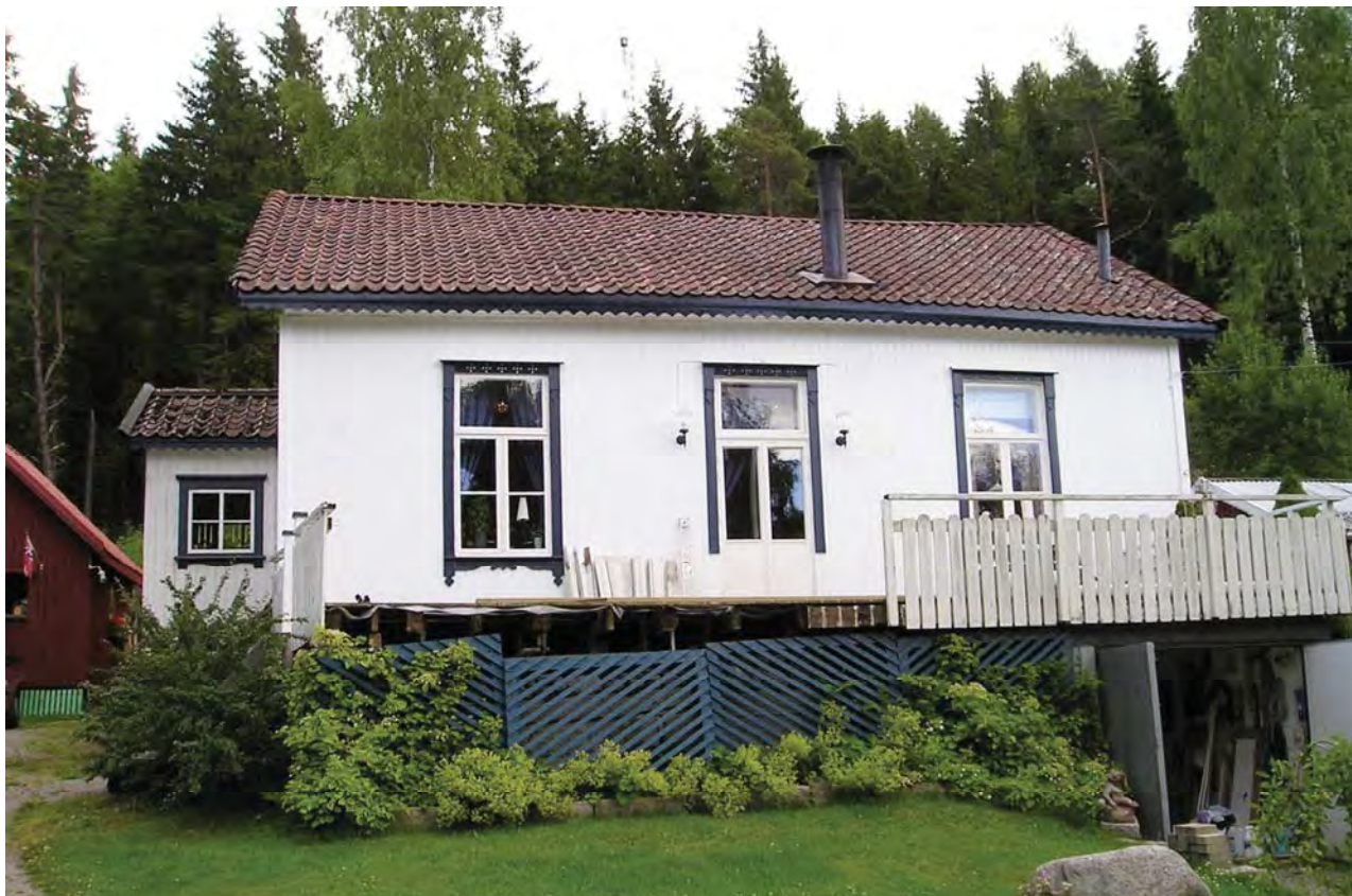
Byggnaden sedd från sydväst
