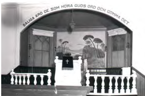
Estraden före ombyggnaden 1958
