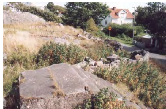
Idag finns bara yttertrappan och delar av grundmurarna kvar av missionshuset.
