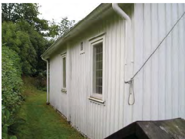
Fasaden mot öster
