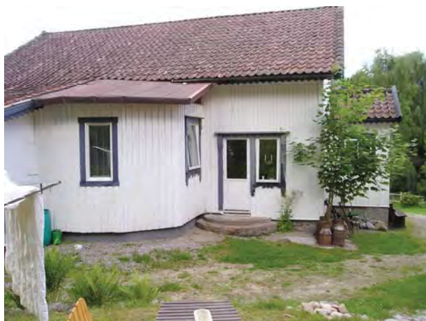
Byggnaden sedd från norr
