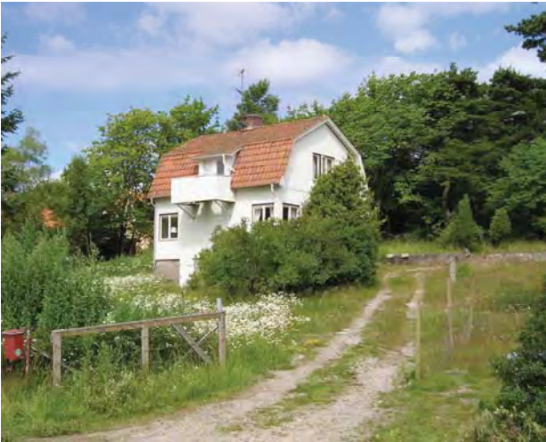
Huset är numera ombyggt till bostad
