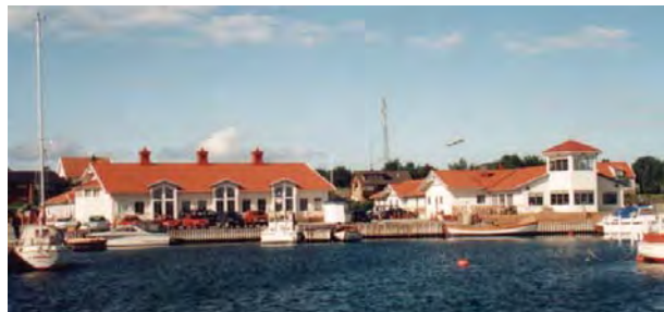
Nimbusanläggningen från nordost
