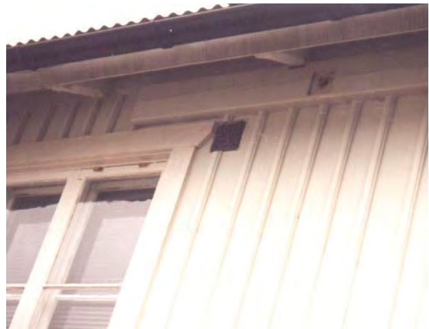
Under takfoten ses fästet för staget som håller huset samman
