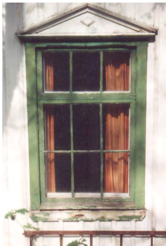
Fönster mot väster
