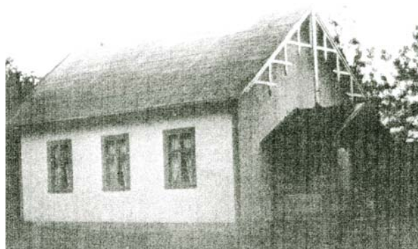
Missionshuset före ombyggnad.
