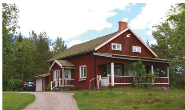
Huset sett från väster.
