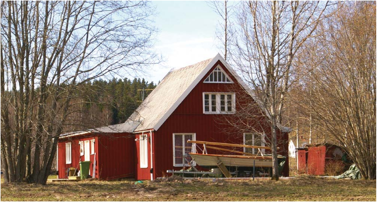
Missionshuset 2014 ombyggt till bostad.
