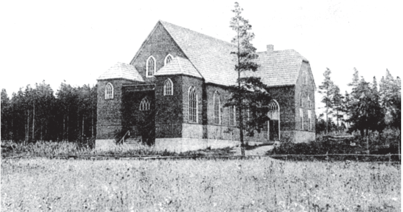
Första missionskyrkan i Tösse byggdes 1922 och brann ner 1942.
