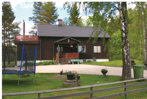
Kapellet 2015 ombyggt till bostad.
