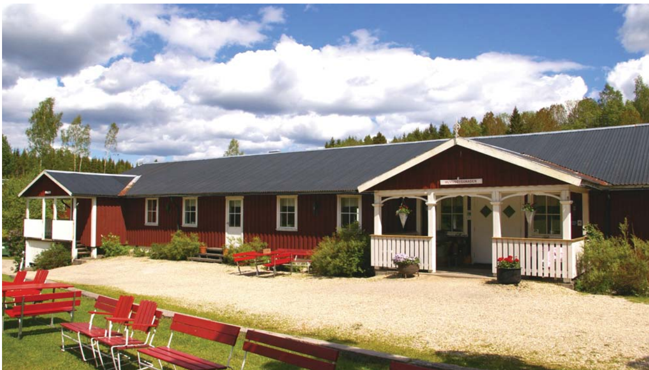
Huvudbyggnaden från sydväst.
