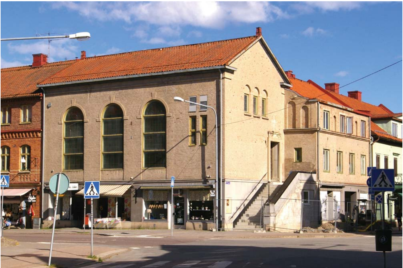
Åmåls 2:a Metodistkyrka byggd 1935.
