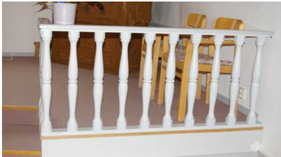
Den gamla balustraden, som under flera årtionden varit inklädd med släta skivor, har åter fått bli synlig.
