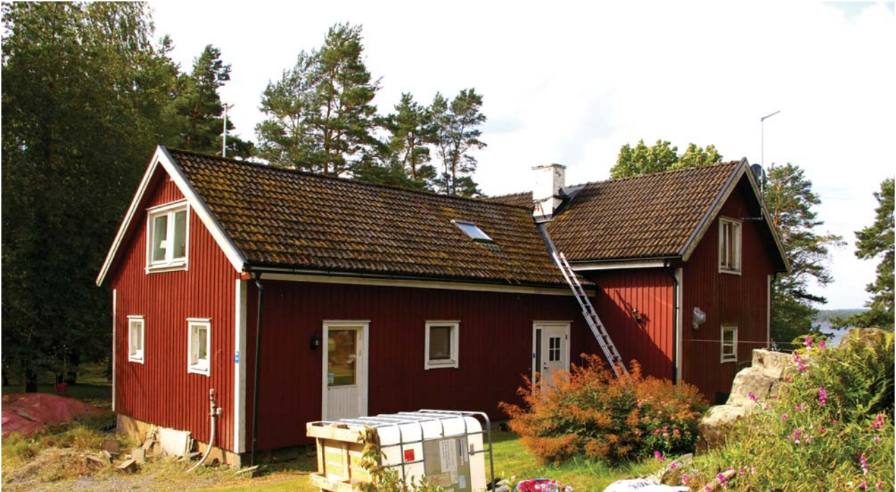
Kapellet ombyggt till bostad.
