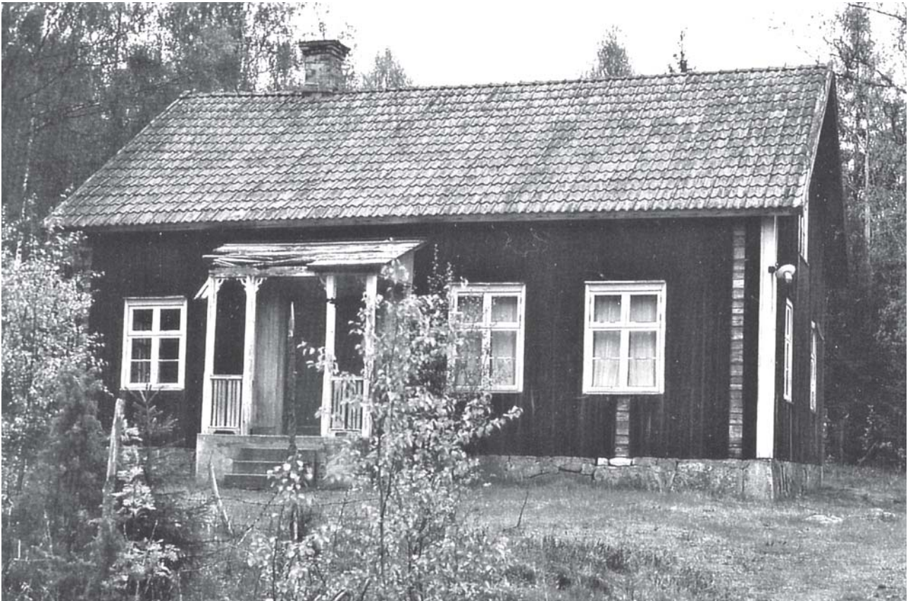
Missionshuset 1965 strax före rivningen.
