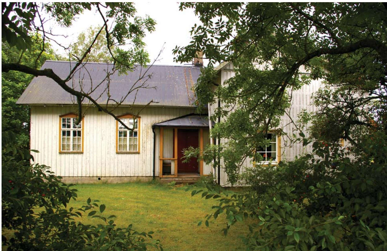
Missionshuset 2015 sett från vägen.
