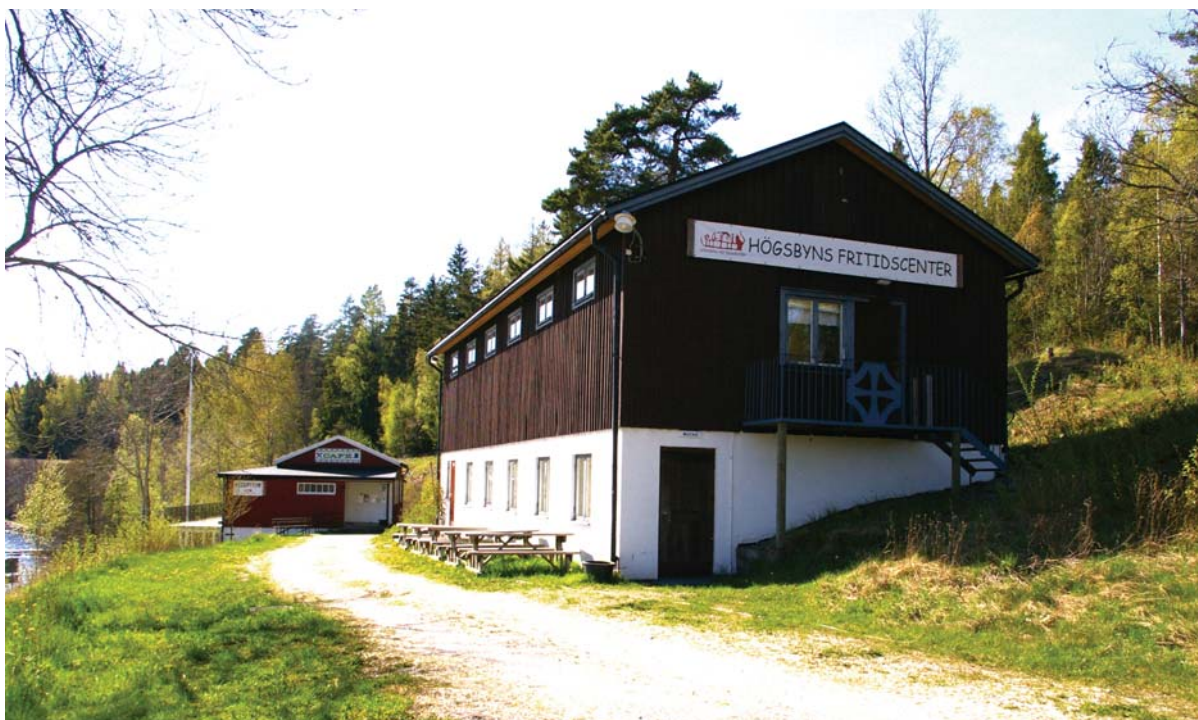
Logementbyggnaden efter omändring till fritidscenter.
