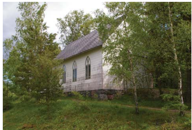
Byggnaden sedd från sydväst.
