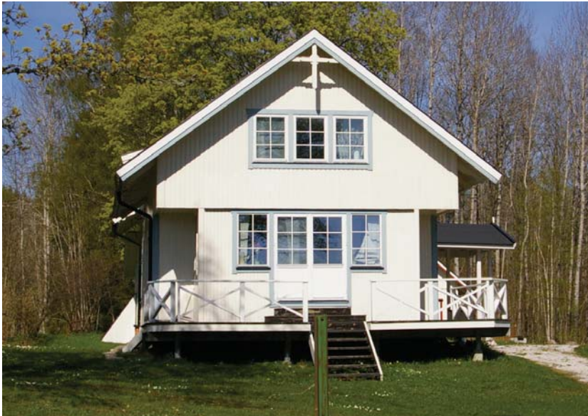
Missionshuset 2014 ombyggt till bostad.
