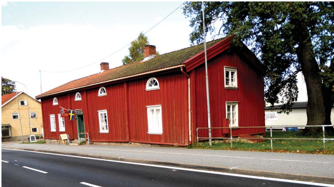
Hembygdsmuseet som en gång inrymde Västra Eds Missionssal. Byggnaden går även under namnet Karl XII-stugan. Foto: Gunnar Olsson 2014.
