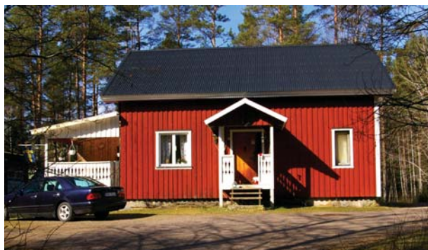
Fasaden mot vägen.
