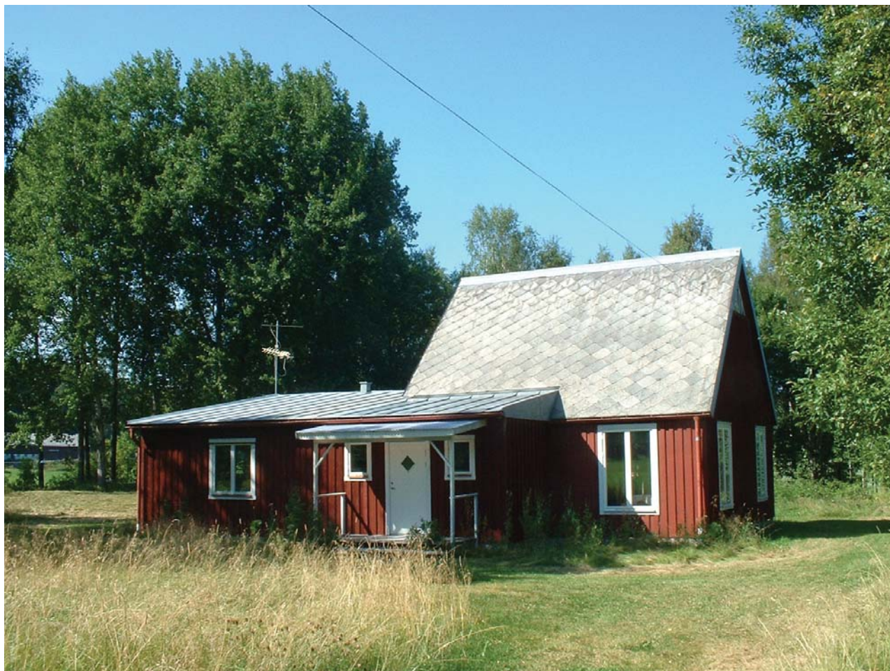
Missionshuset före ombyggnad till bostad.
