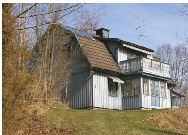
Kapellet ombyggt till bostad.
