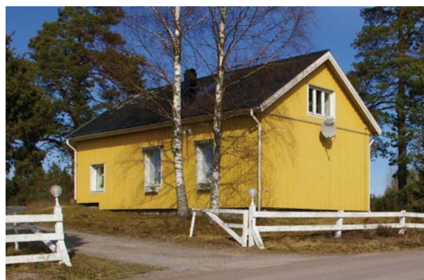
Missionshuset 2015 ombyggt till bostad.
