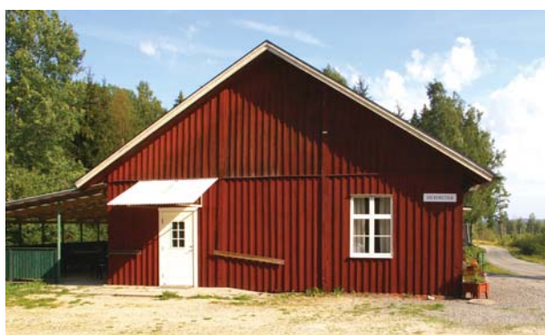
Byggnaden sedd från söder.
