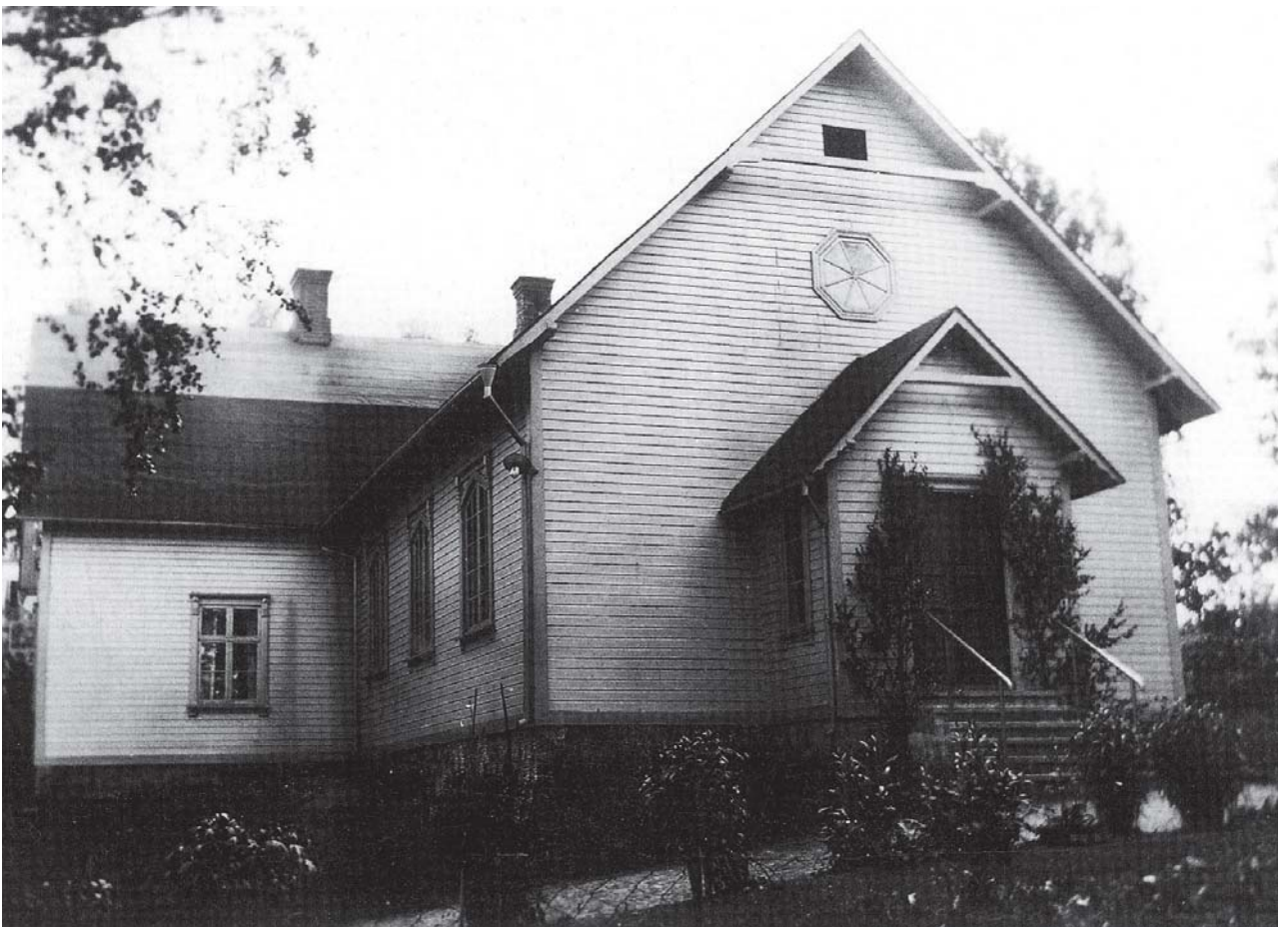
Kapellet före ombyggnad till bostad.
