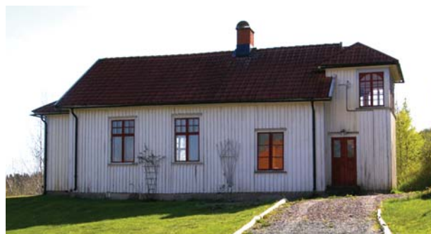
Fasaden mot norr.
