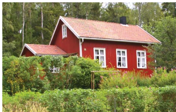
Huset från sydväst.
