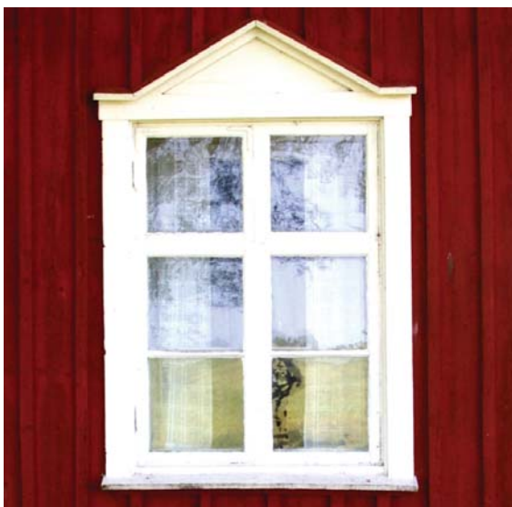
Detalj av fönster.
