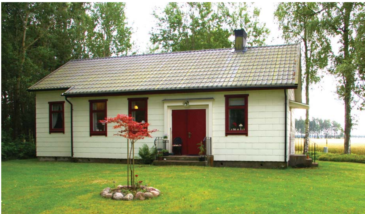
Huset från norr.
