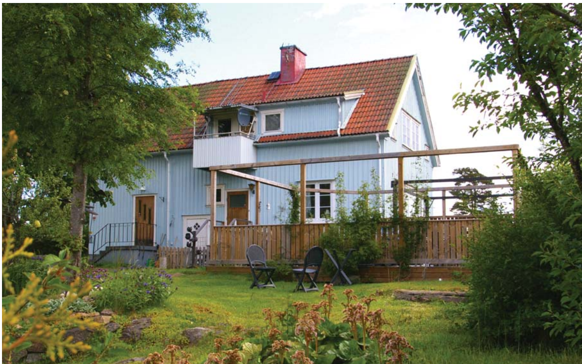
Huset ombyggt till bostad, sett från sydväst.
