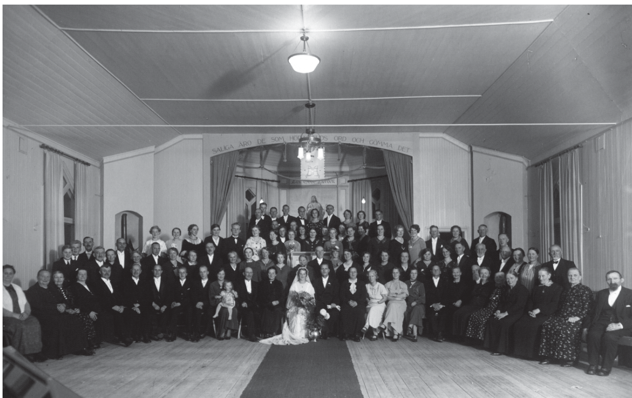
Gammalt bröllopsfoto som visar kyrksalen från tiden när kaminerna fortfarande fanns kvar.
