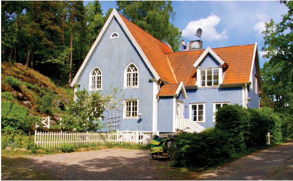
Missionshuset ombyggt till bostad, sett från söder.
