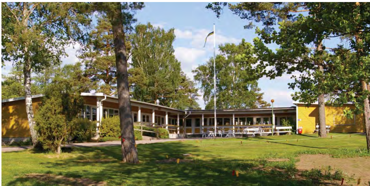
Huvudbyggnaden från nordväst.
