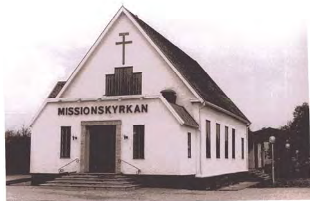
Exteriör efter tillbyggnad av kapprum.
