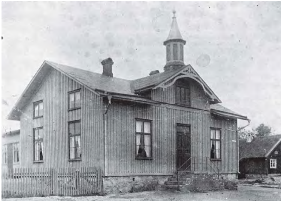
Missionshuset efter ombyggnaden 1891.
