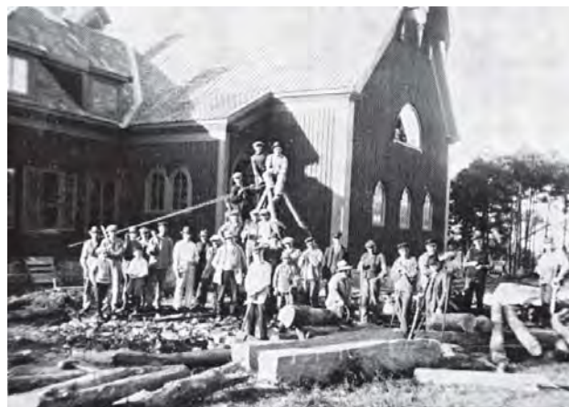
Arbetslag vid kyrkbygget.
