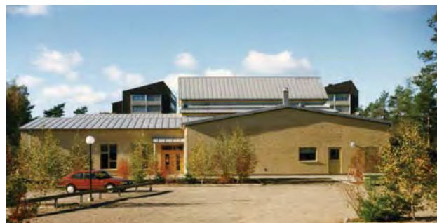
Kyrkan sedd från sydost.
