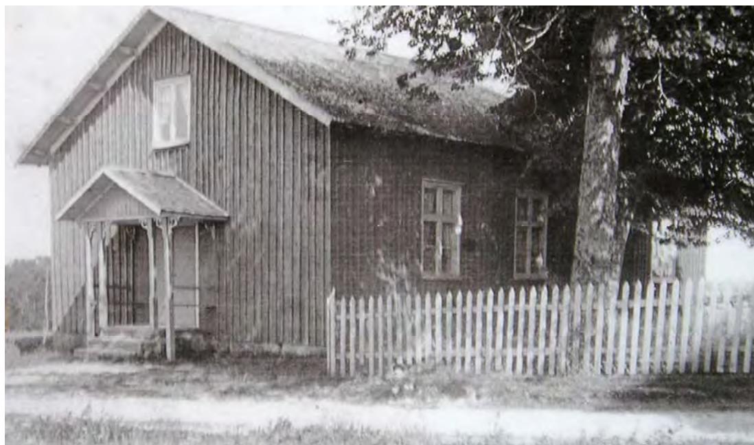
Norska Skogsbygds Missionshus uppfört 1970
