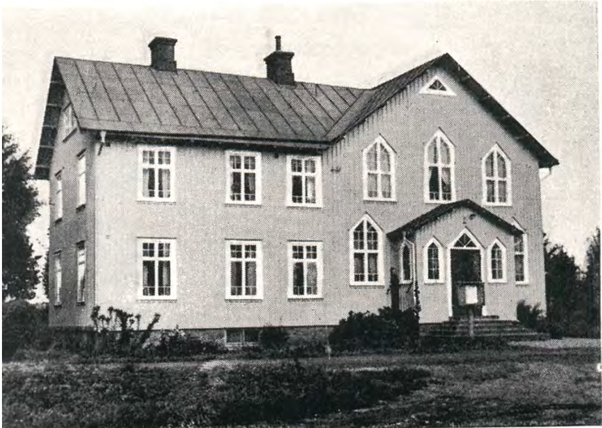
Missionskyrkan från sydost före tillbyggnader
