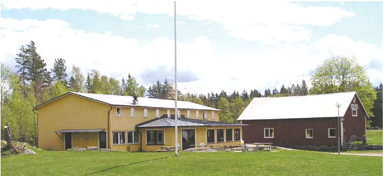
Matsalsbyggnad och logement
