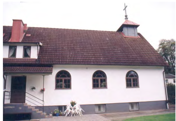
Långsidan mot sydost
