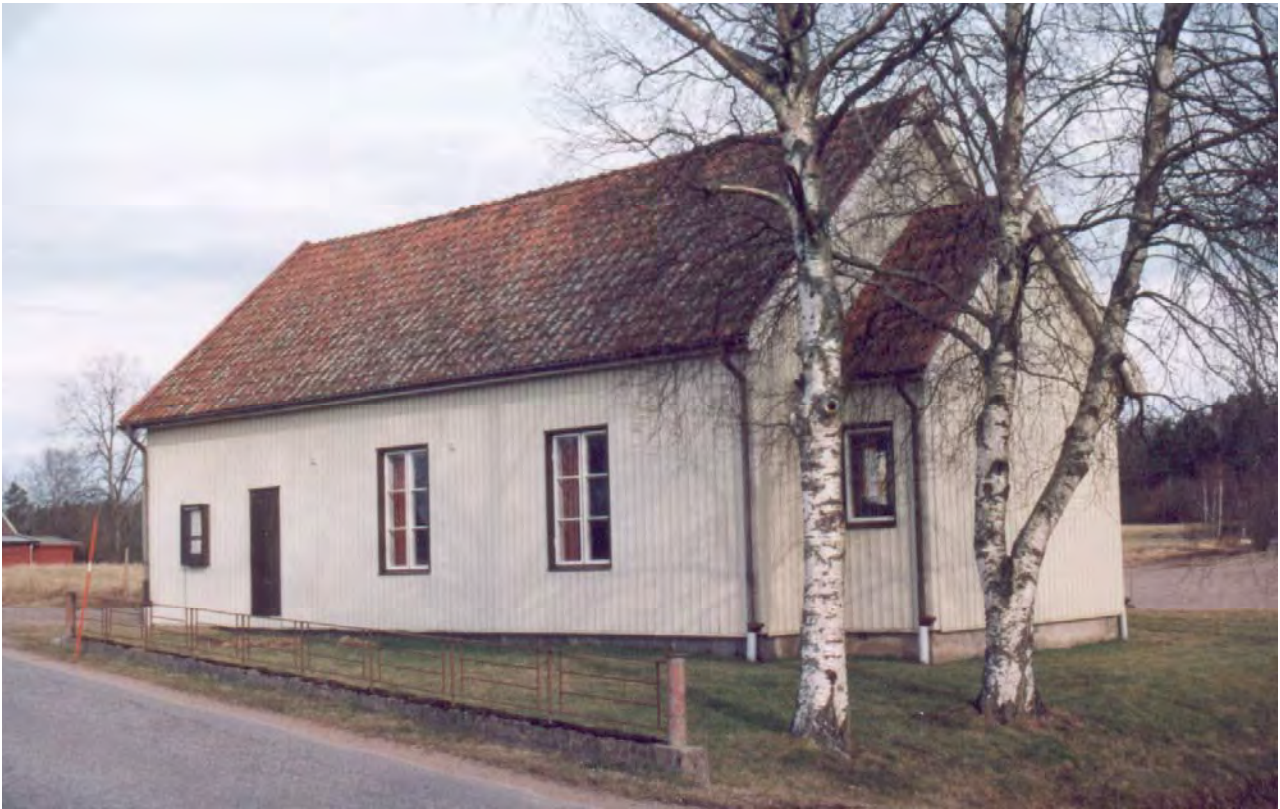
Eggvena Missionshuset sett från sydost
