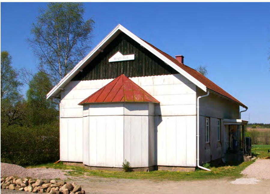
Missionshuset ombyggt till bostad 2016.
