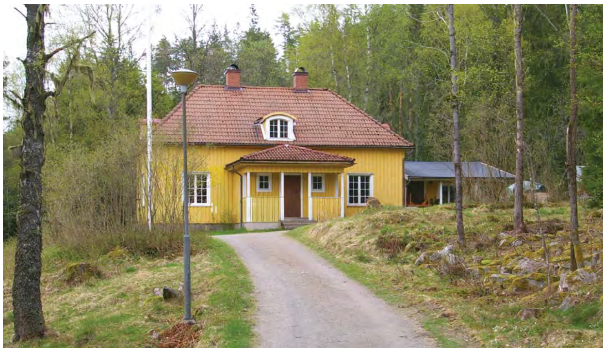
Huvudbyggnaden sedd från väster.
