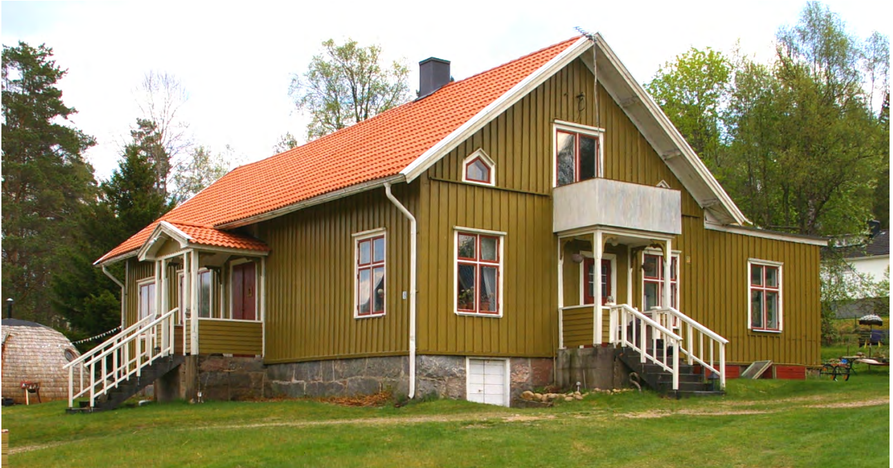
Missionshuset efter ombyggnad till föreningslokal sett från väster.
