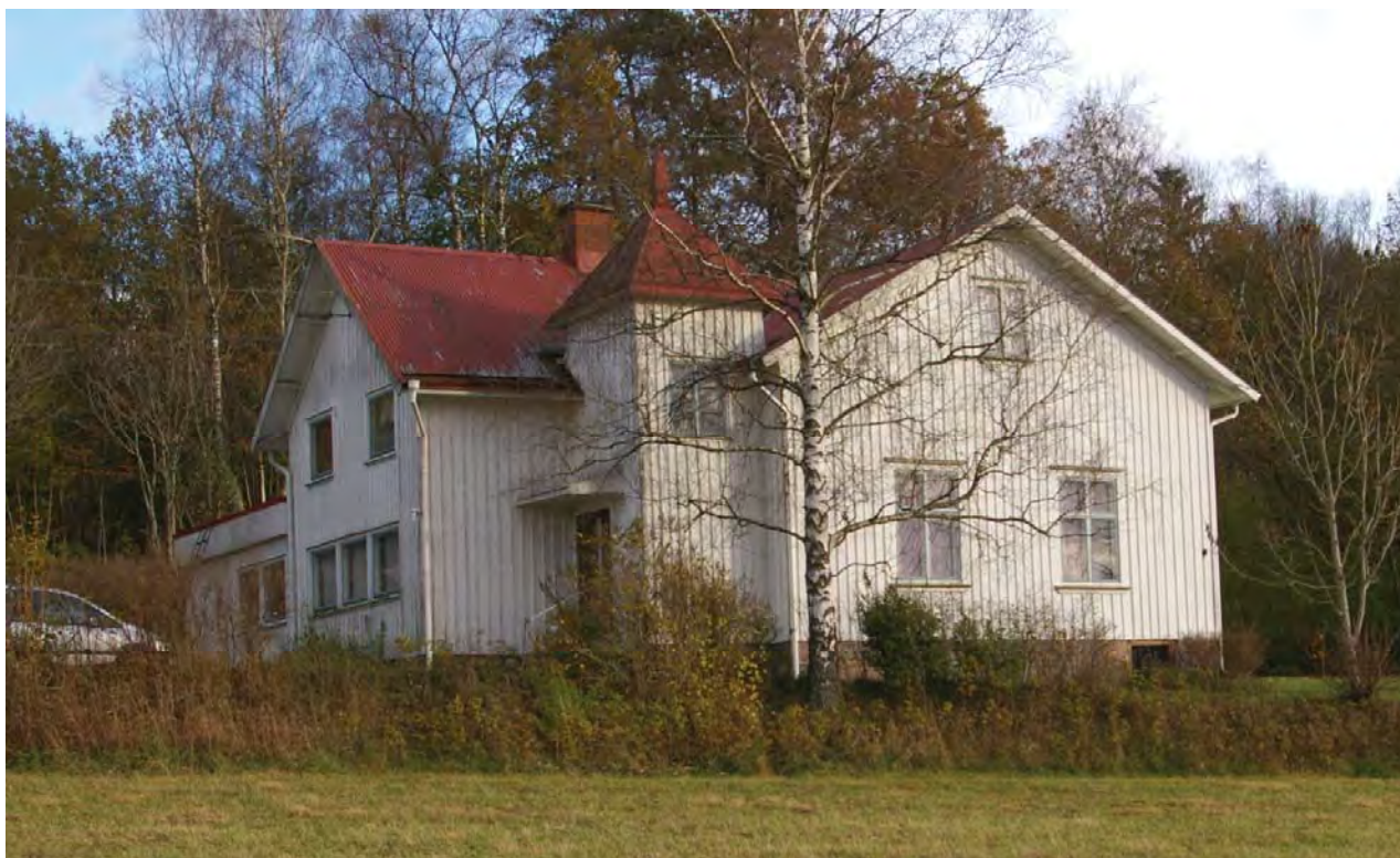
Mellby Missionskyrka 2010, ombyggd till bostad.
