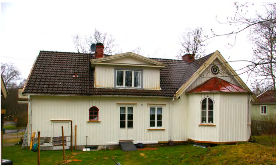
Missionshuset under ombyggnad till bostad 2016.
