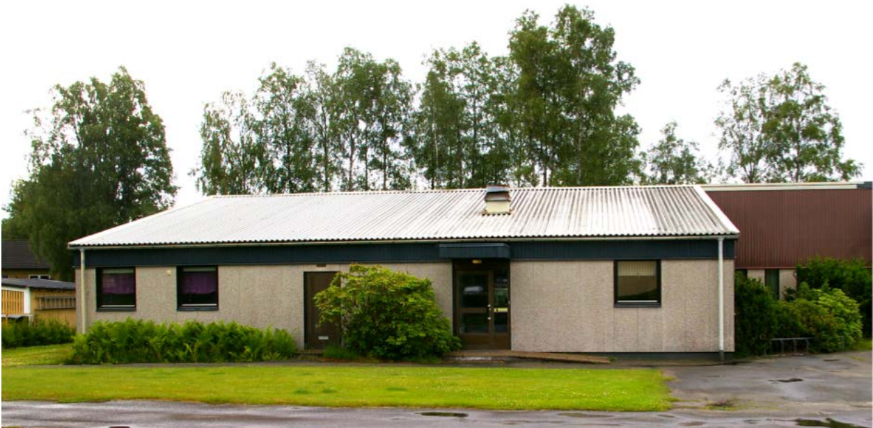
Kyrkans fasad mot norr.
