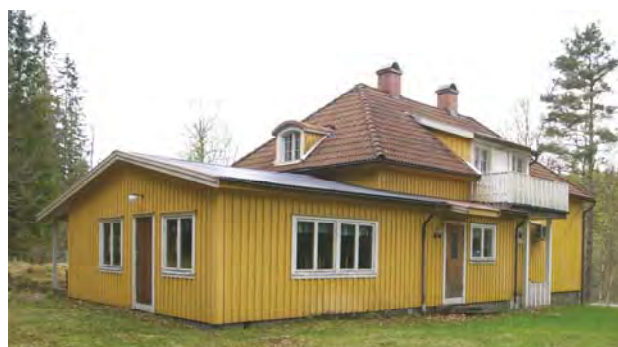
Huvudbyggnaden från sydost.
