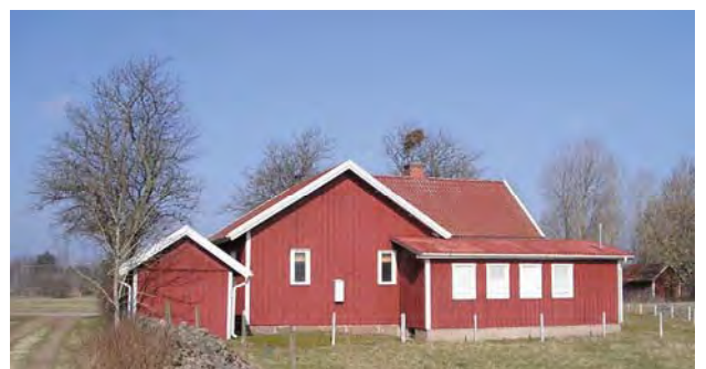
Huset från sydost
