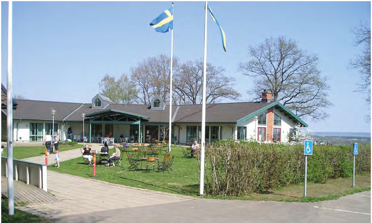
Mössebergsgården från väster
