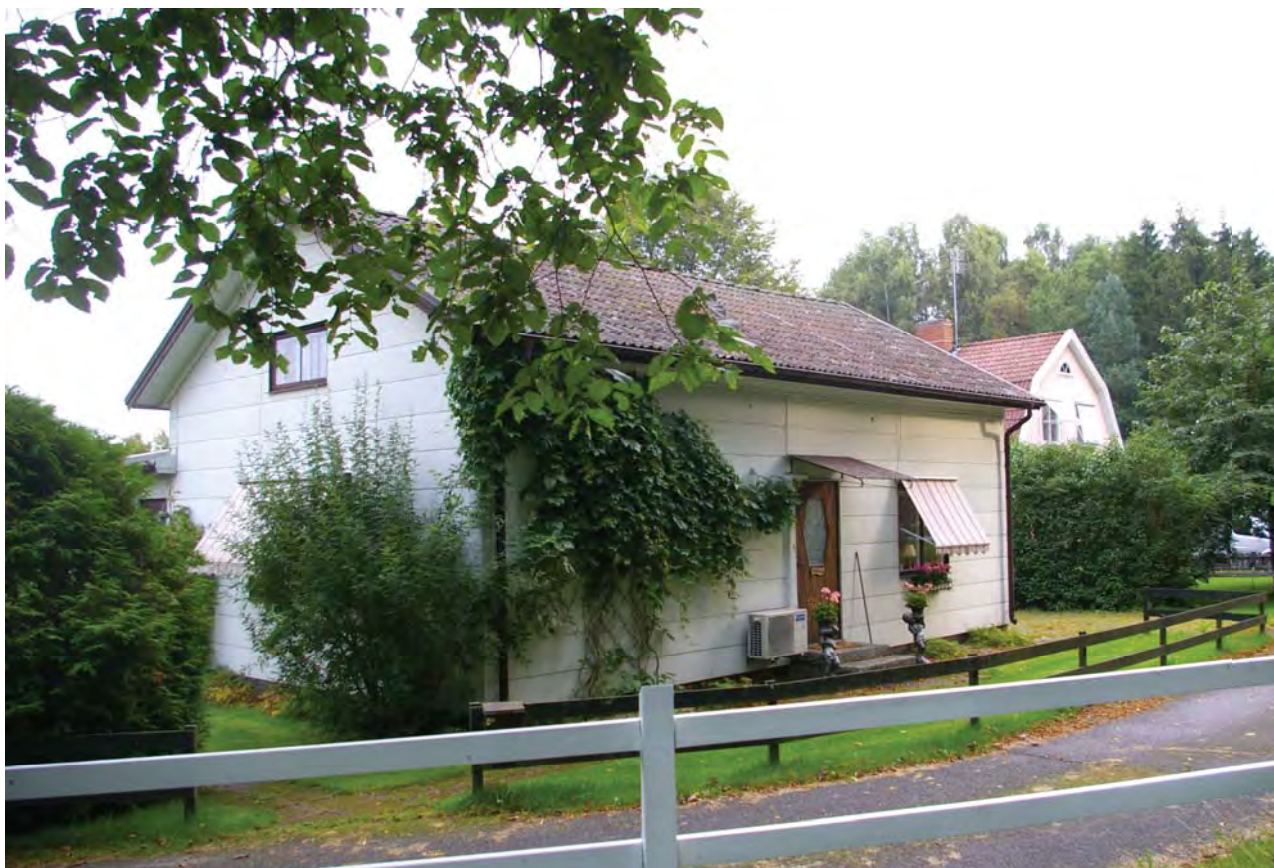
Missionshuset 2011 ombyggt till bostad.
