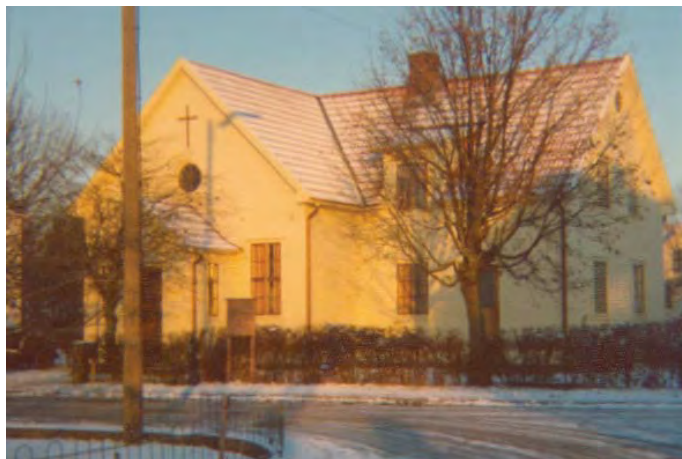
Missionshuset före ombyggnad till bostad
