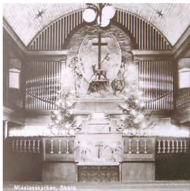
Kyrksalens fond efter att den nya orgeln installerats 1954.
