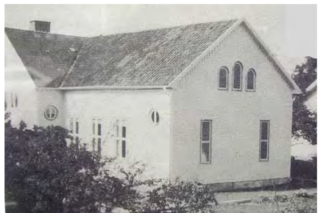
Efter rivning av tornet
