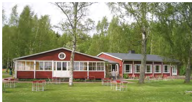
Sommargården från söder. Till höger ses tillbyggnaden gjord 1961.
