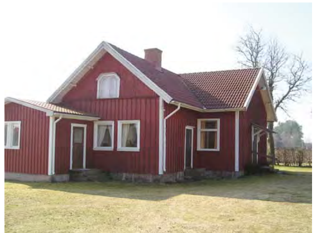
Huset från norr
