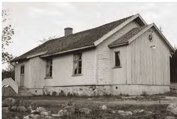
Huset före flyttningen.
