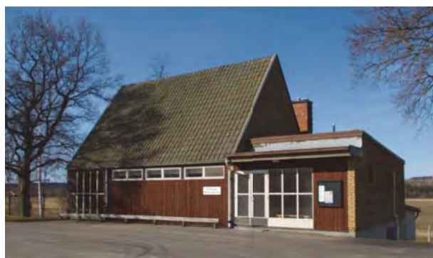
Kyrkan sedd från nordost.
