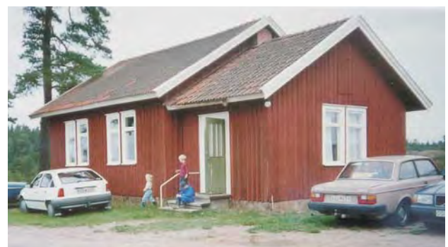
Missionshuset före tillbyggnaden 1994
