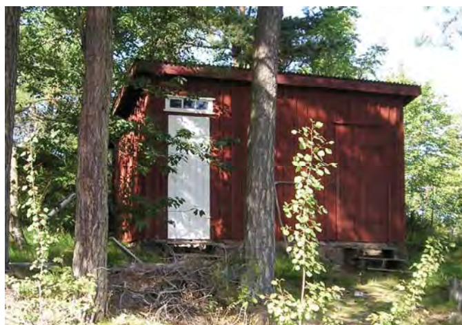
Bakom missionshuset ligger uthuset med vedbod och toalett
