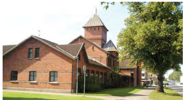
I förgrunden ses den gamla brandstationen ombyggd till ungdomslokaler och expeditioner, i bakgrunden den nybyggda kyrksalsdelen.
