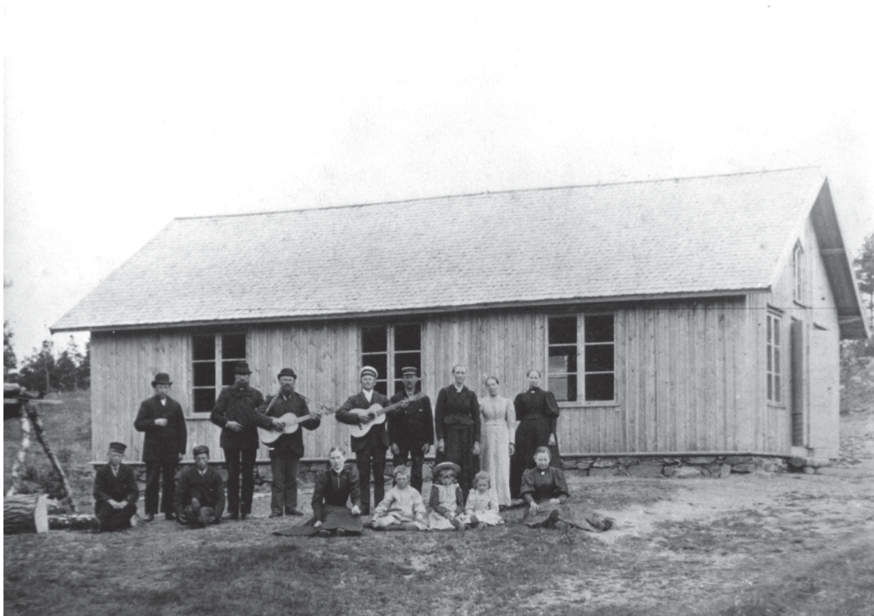
Missionshuset under byggnad
