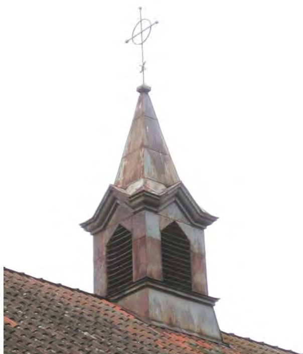
Ventilationshuven på taket har formats som ett vackert litet kyrktorn
