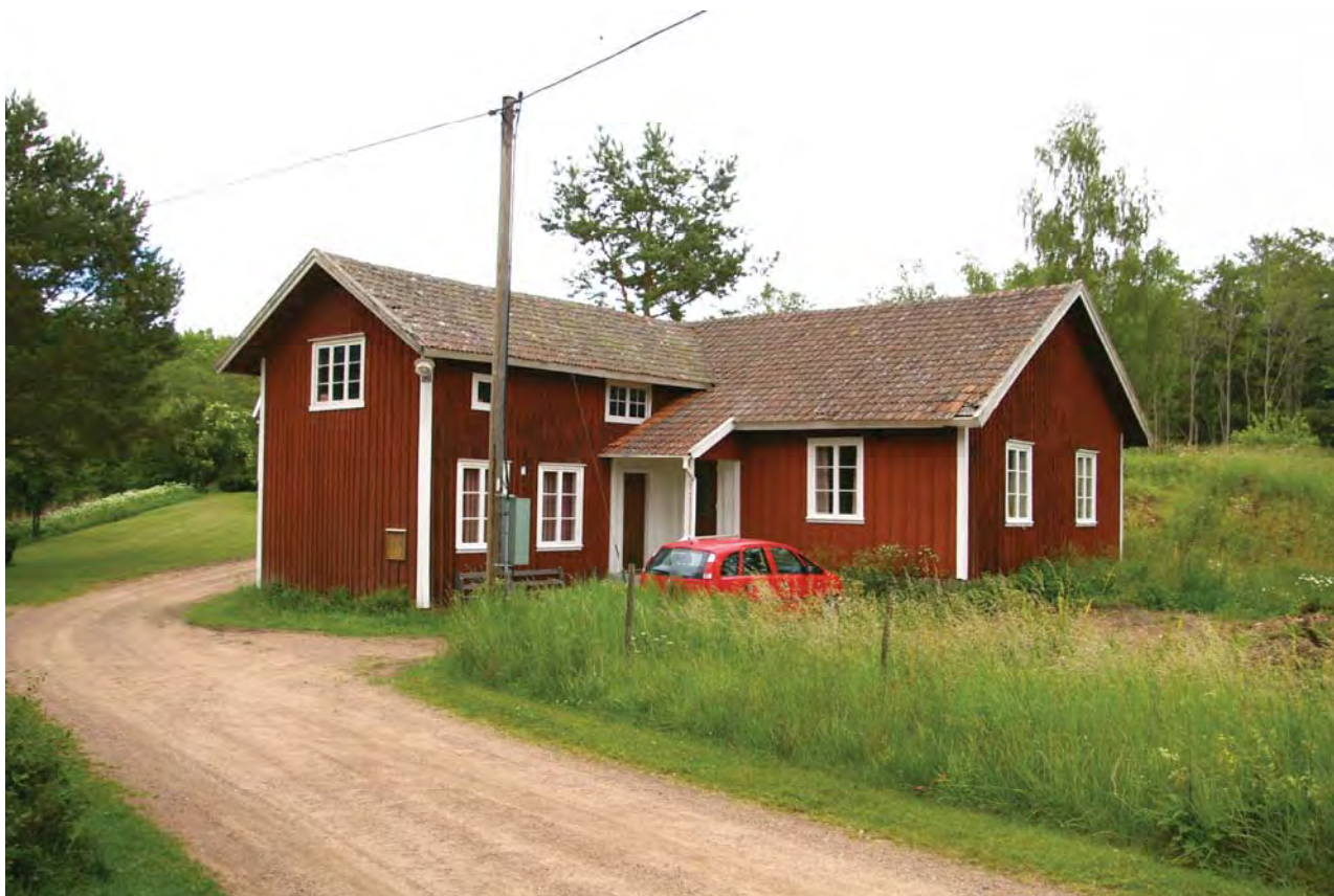
Missionshuset ombyggt till bostad.
