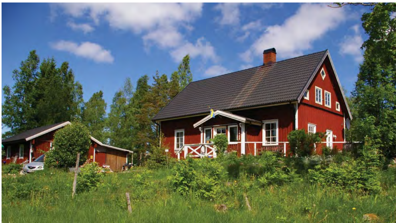
Missionshuset ombyggt till bostad.
