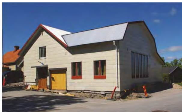
Huset är 2013 under ombyggnad.
