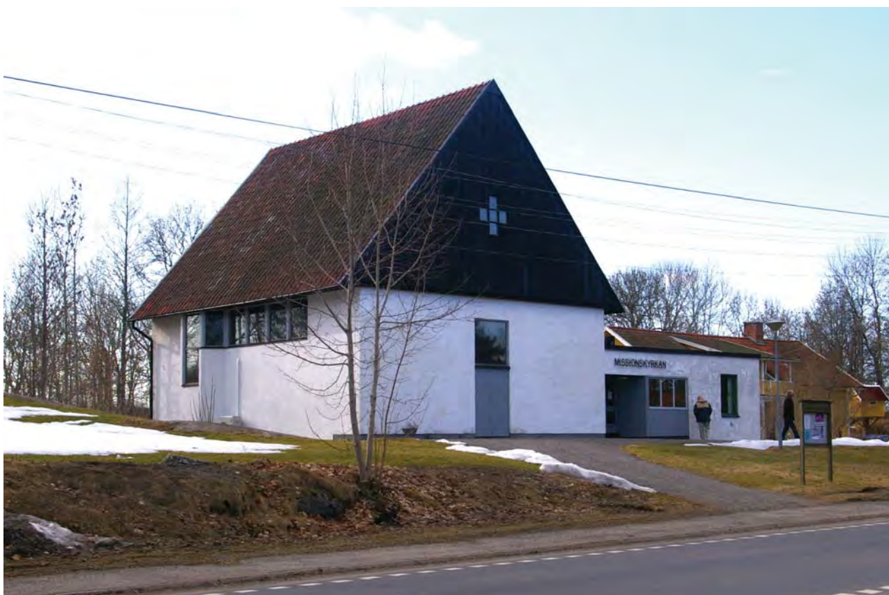
Missionskyrkan sedd från sydost.
