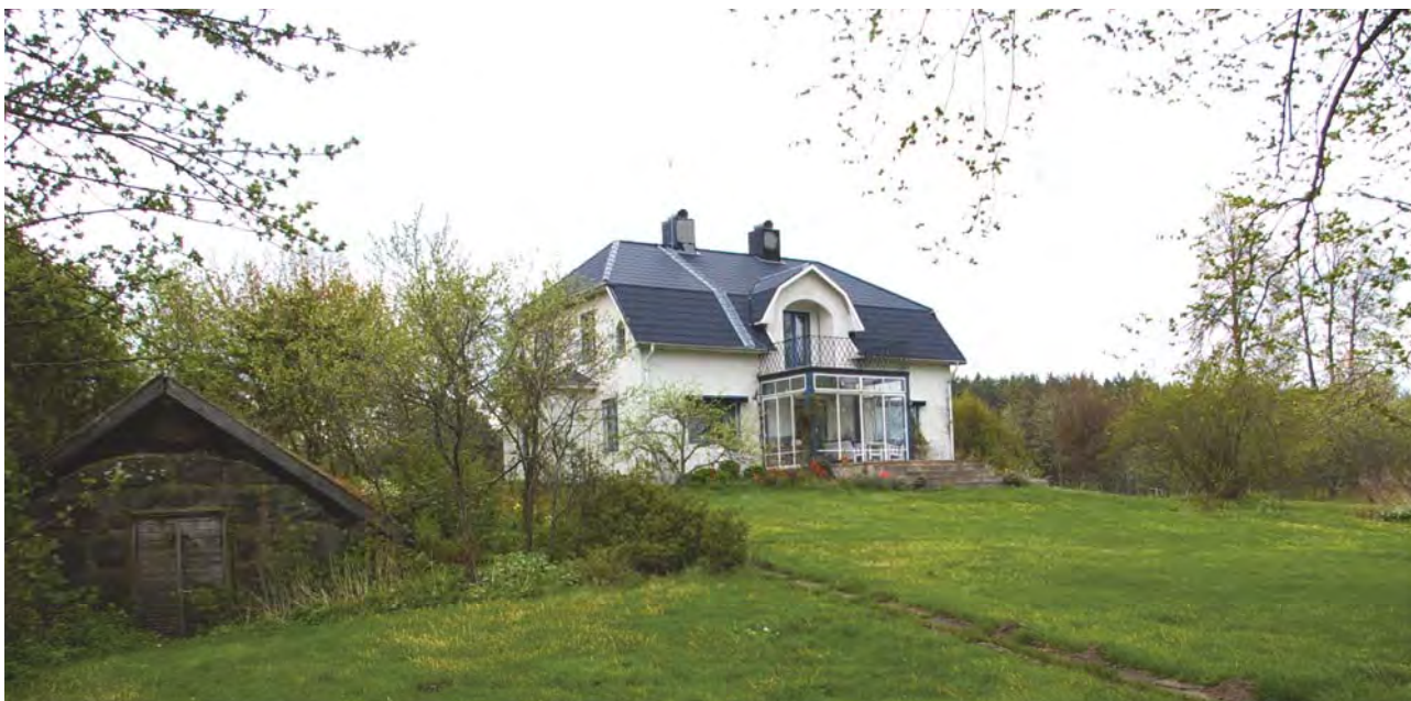
Huvudbyggnaden från sydväst.
