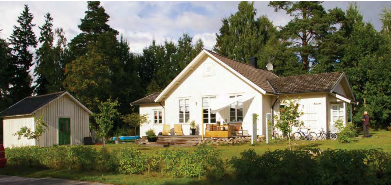
Missionshuset ombyggt till bostad 2013.
