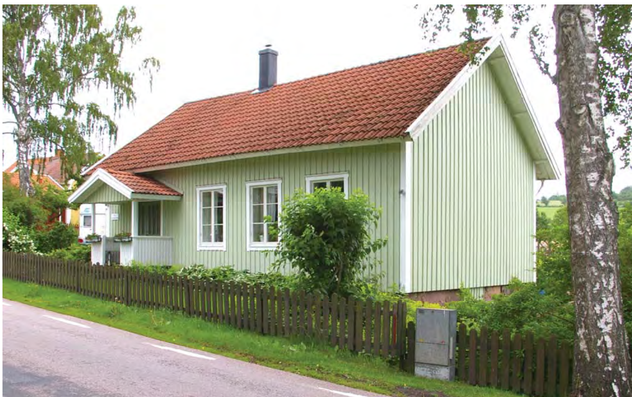
Missionshuset 2011 ombyggt till bostad.
