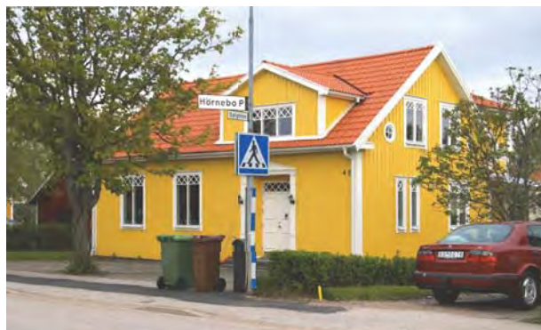
Missionshuset ombyggt till bostad.
