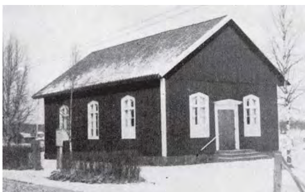
Missionshuset med ingången flyttad till östra gaveln.
