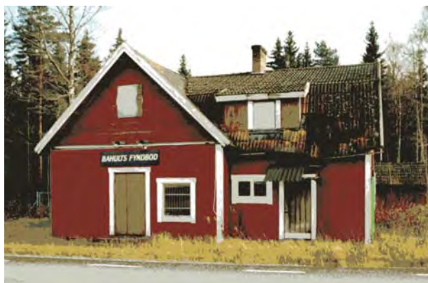
Fasaden mot vägen 2001.
