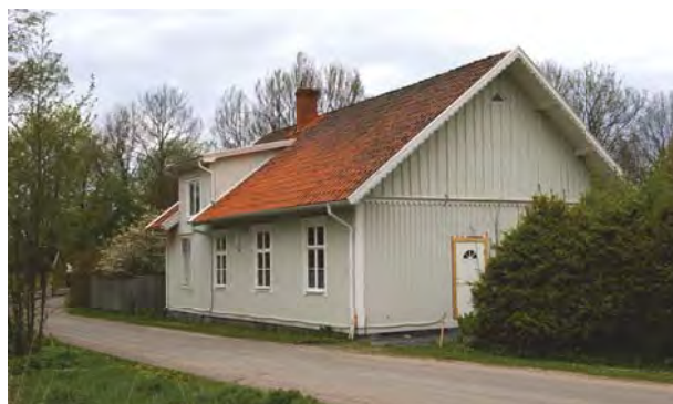
Missionshuset ombyggt till bostad.
