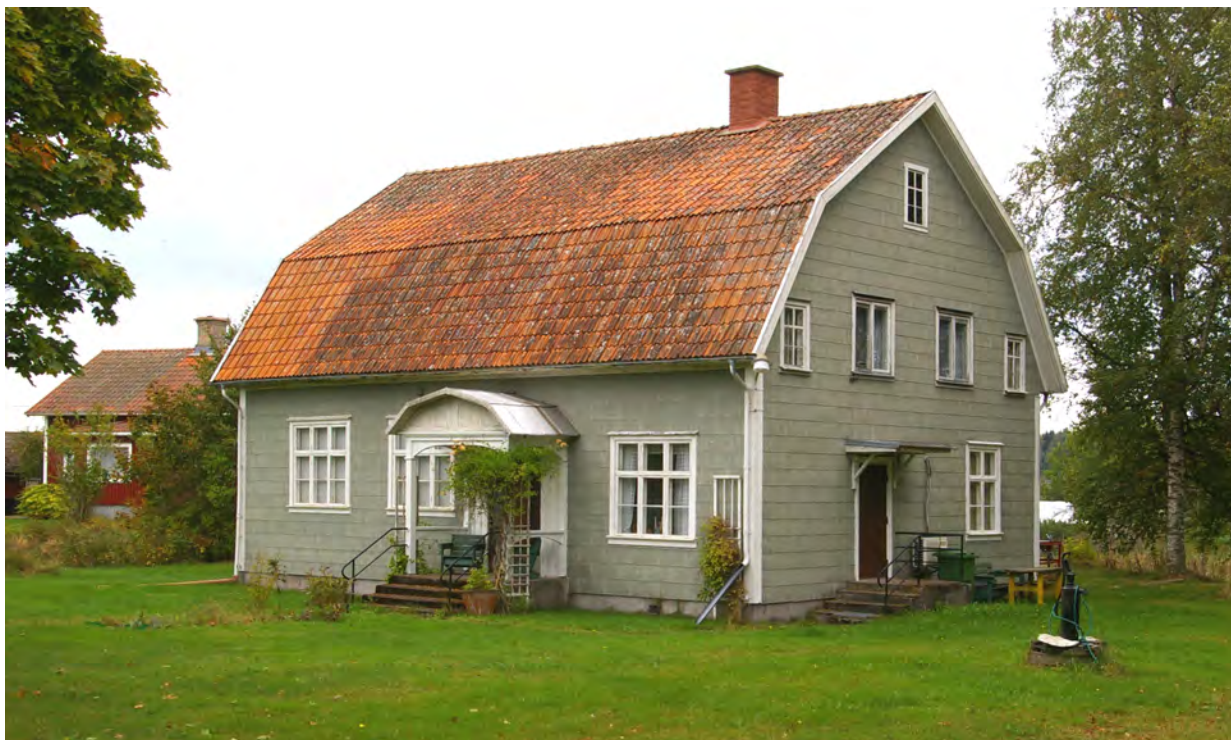
Gunnarstorps Missionshus ombyggt till bostad.
