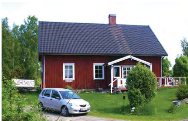
Huset sett från väster.
