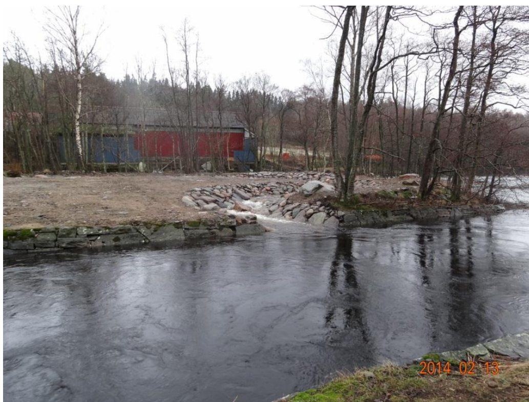
Omlöpet vid Ålgårda kraftverk, nedre delen efter förlängning 2013. Foto: Andreas Bäckstrand.
