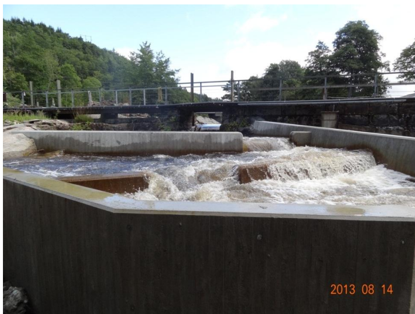
Teknisk fiskväg i anslutning till torrfåran vid Ålgårda kraftverk. Foto: Andreas Bäckstrand.
