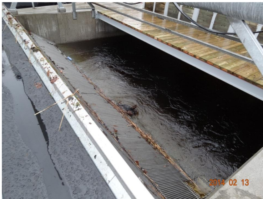
Låglutande galler med flyktväg för fisk i nedre högra hörnet. Foto: Andreas Bäckstrand.
