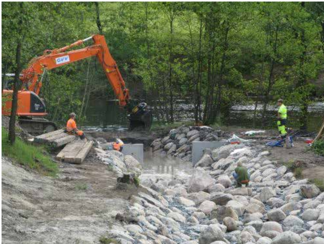
Foto F4. En ny fiskväg i form av ett omlöp* är färdigbyggd vid Bosgårdens vattenkraftverk 56 . På bilden släpps vatten på för första gången. Foto Anna Ek.
